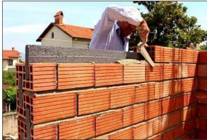
Şekil 5. Örnek tuğla duvar
