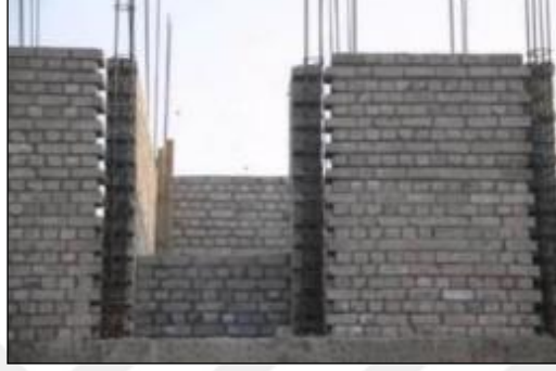
Şekil 8. Kuşatılmış yığma yapı imalatı
