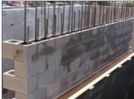
Şekil 9. Donatılı yığma duvar
