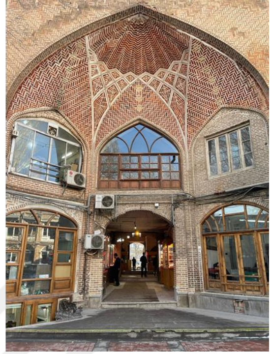
Görsel 5.21. Amir Timçesini Amir Rastasına (sol) ve Amir Timçesine (sağ) bağlayan filtre bölüm (Heşti) (Fotoğraf yazara aittir)
