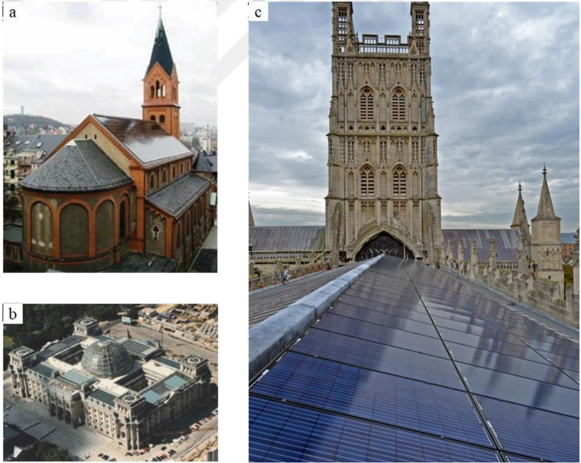
Şekil 5.3. Tarihi binaların çatısında yerleştirilen güneş panelleri: a) Lutheran kilisesi, Almanya. b) Reichstag binası, Almanya. c) Gloucester kilisesi, Almanya ( http-42 , 2021)
