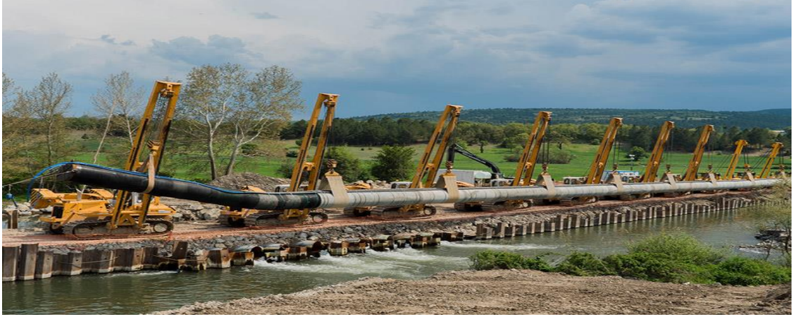
Şekil 2.6. Doğalgazın Boru Hattı ile Taşınması
