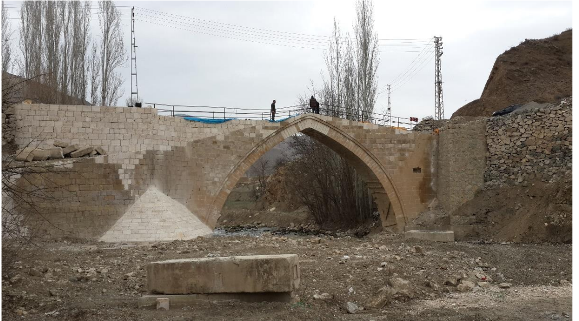
Şekil 4.2. Pehlivanlı Köprüsü restorasyon esnası operasyonel modal analiz çalışması döneminden bir görsel (Okuyucu vd 2016).
