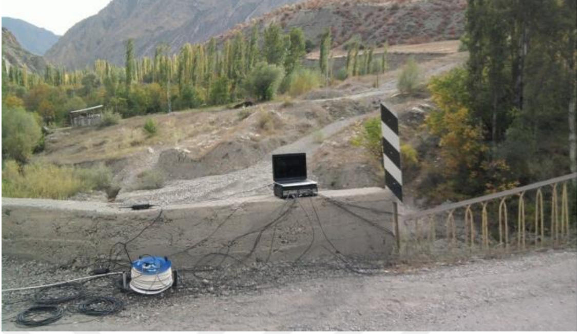
Şekil 3.26. Pehlivanlı Köprüsü restorasyon öncesi operasyonel modal analiz çalışmasına ait bir görsel (Bayraktar 2012).
