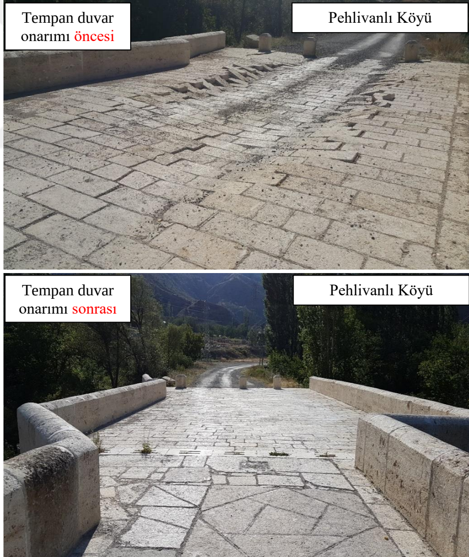
Şekil 3.38. Pehlivanlı Köprüsü tempan duvar onarımı öncesi ve sonrasına ait görüntüler
