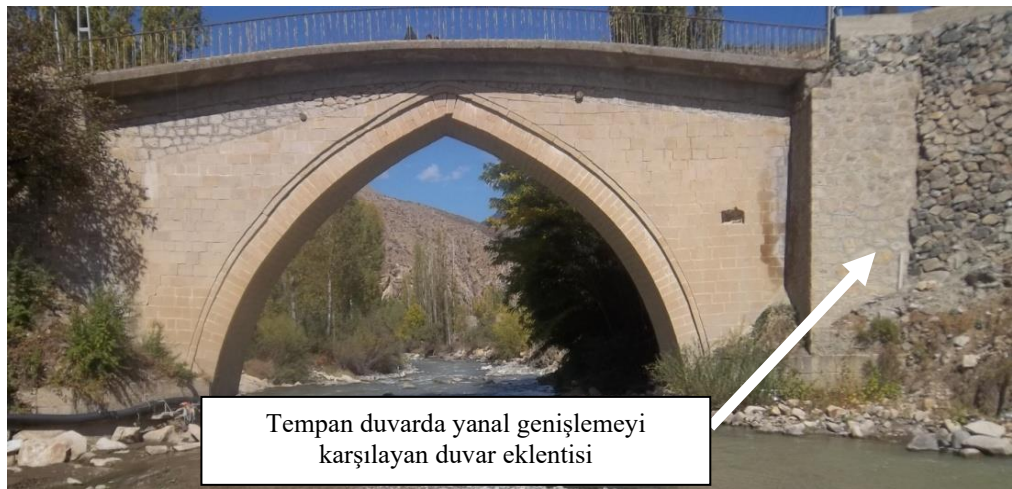
Şekil 4.4. Restorasyon öncesi dönemde Pehlivanlı Köprüsü tempan duvarlarının yanına yapılan duvar eklentisi (Bayraktar 2012).
