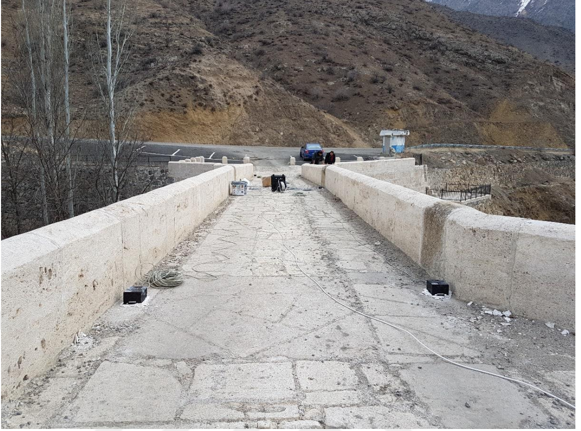
Şekil 3.35. Pehlivanlı Köprüsü restorasyon çalışmasından 2 yıl sonra tekrar yapılan operasyonel modal analiz çalışmasına ait bir görsel.
