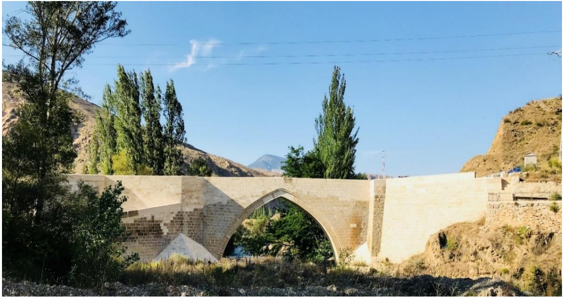
Şekil 3.2. Pehlivanlı Köprüsü genel görünümü
