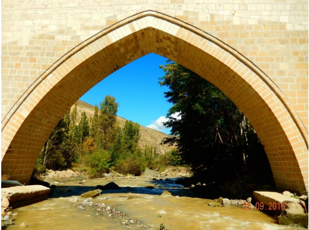
Şekil 3.31. Pehlivanlı Köprüsü restorasyonu sonrası ana taşıyıcı kemerin yakın plan görüntüsü (Okuyucu vd 2016).
