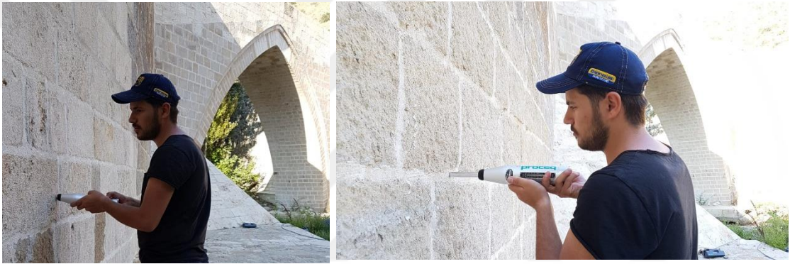
Şekil 3.9. Pehlivanlı Köprüsü Schmidt Çekici uygulaması
