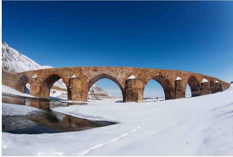
Şekil 1.1. Çobandede Köprüsü (Anonim 2013)
