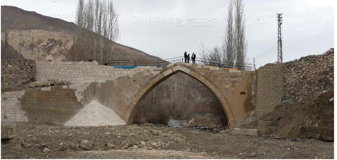
Şekil 3.27. Restorasyon döneminde kireçli köprüsü görüntüsü (Okuyucu vd 2016)
