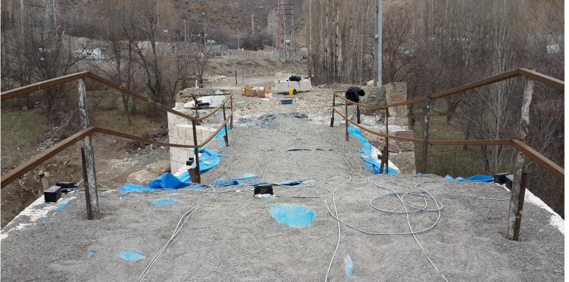
Şekil 3.28. Restorasyon esnası Kireçli Köprüsü operasyonel modal analiz çalışmasından bir görüntü (Okuyucu vd 2016).
