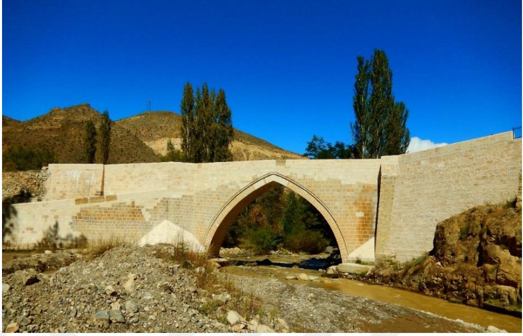
Şekil 3.30. Kireçli Köprüsü restorasyon sonrası genel görünümü (Okuyucu 2016)
