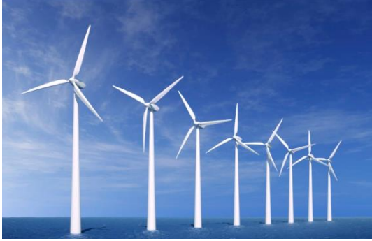
Şekil 1.5. Rüzgar Türbini Kuleleri
