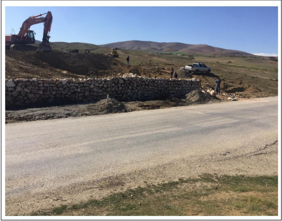
Şekil 7.3. Güneş enerji santralinin kurulumu gerçekleştirilecek arazinin kuruluma uygun hale getirilmesi
