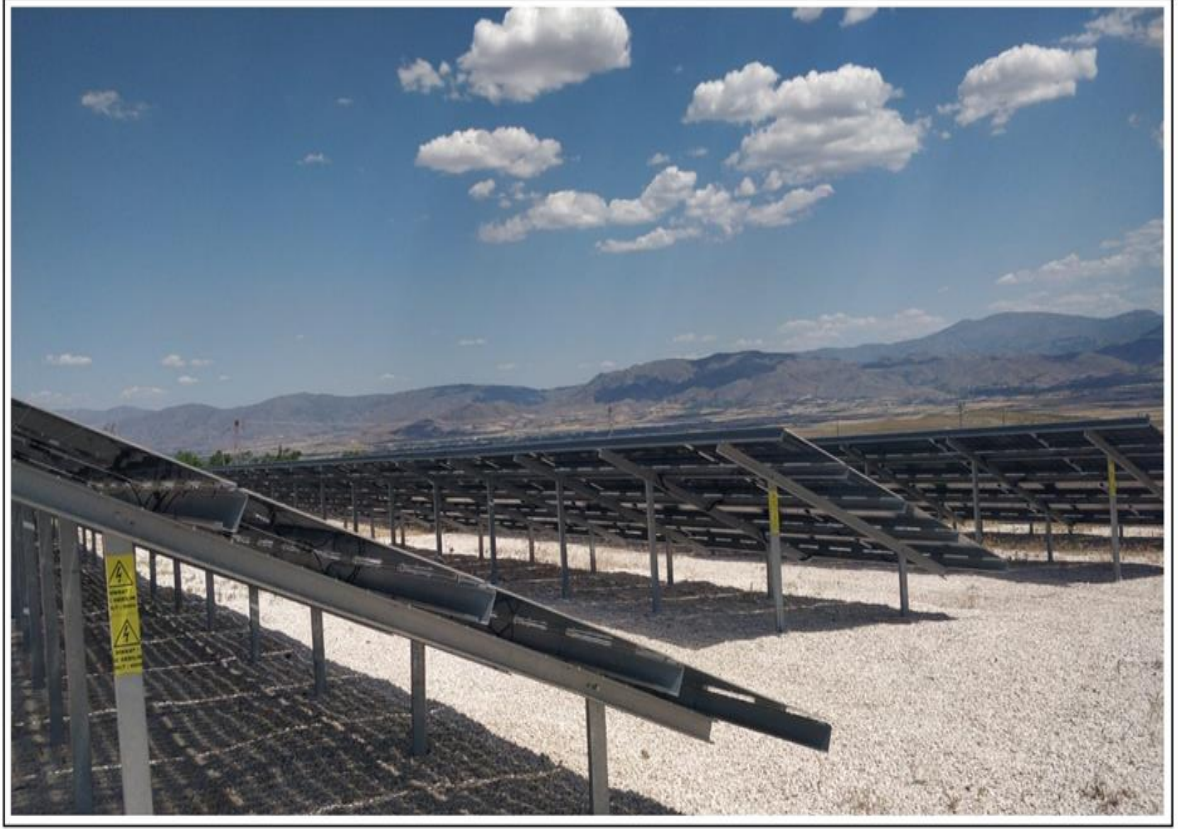
Şekil 7.15. Güneş enerji santralinin enerji hatlarının toprak altına gömülmüş hali
