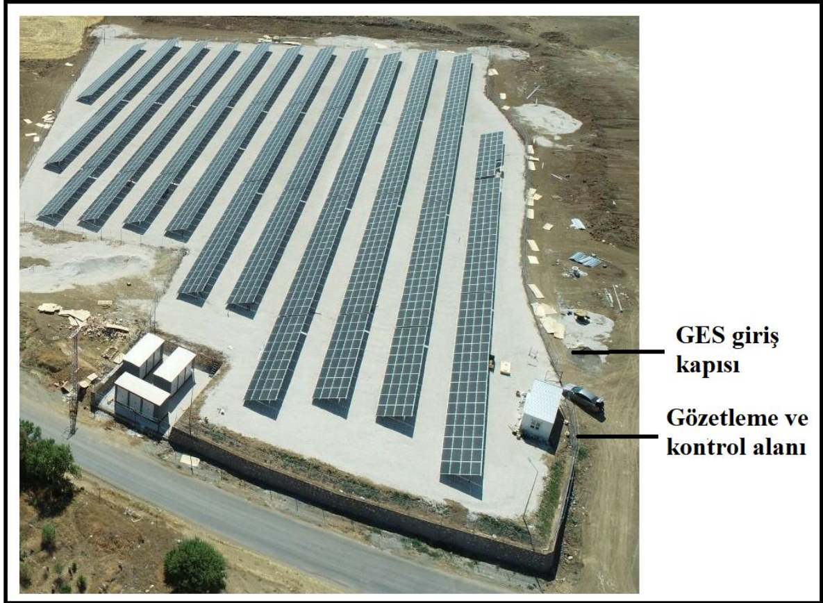
Şekil 7.16. Güneş enerji santralinde gözetleme ve kontrol alanının görünümü
