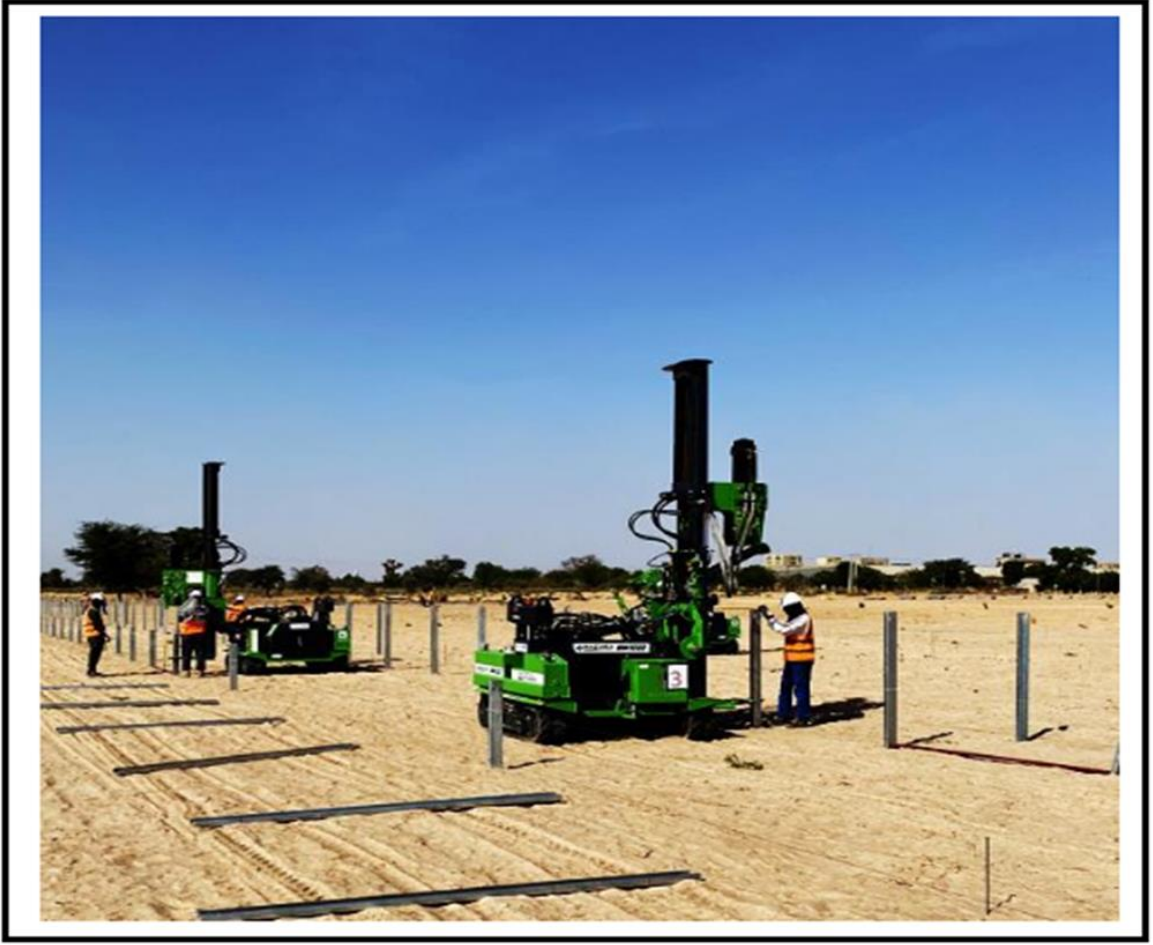
Şekil 7.4. Çelik konstrüksiyon çakma makinasının görünümü
