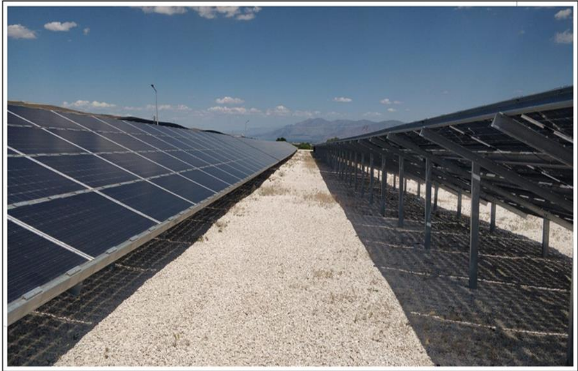
Şekil 7.6. Fotovoltaik panel dizilimi ve ışınım altında gölgelenmemesi için aralıklı dizilimi
