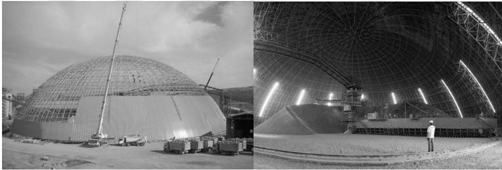
Şekil 2.8. Akçansa Klinker Deposu, Çanakkale
