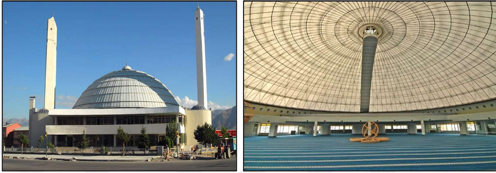
Şekil 3.14. 50 m çaplı çift katmanlı uzay kafes kubbe, Terzi Baba Camii, Erzurum
