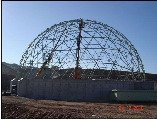
Şekil 3.18. 30 m çaplı jeodezik kubbe, Kışladığı Altın Madeni, Uşak
