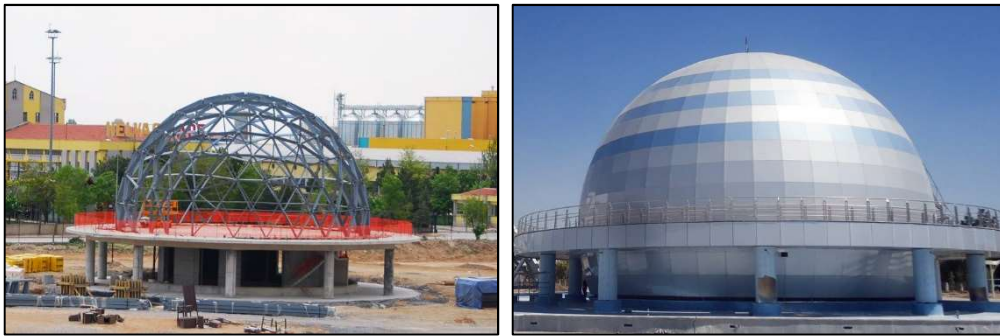
Şekil 3.16. 21 m çaplı jeodezik kubbe, Konya Bilim Merkezi Planetarium Binası
