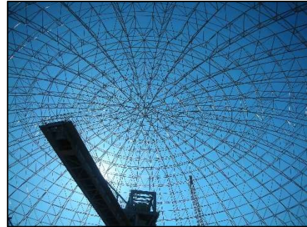
Şekil 3.19. 124 m çaplı çift katmanlı uzay kafes kubbe, Akçansa Çimento Stokholü, Çanakkale
