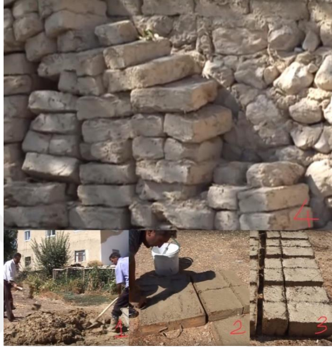
Resim 2.7: Kerpiç tuğlanın yapım aşamaları www.youtube.com (19.09.2018).
