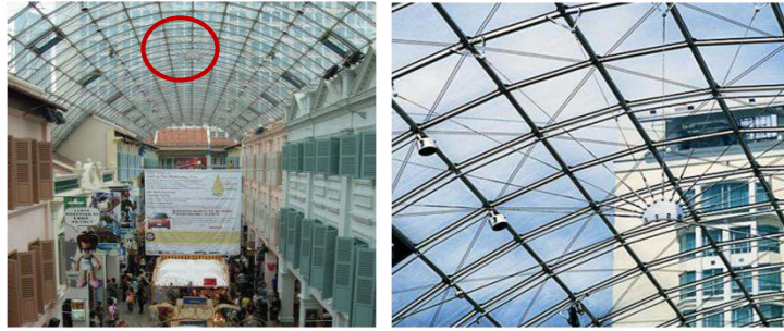
Şekil 4.28 Bugis Junction, Singapur [114]
