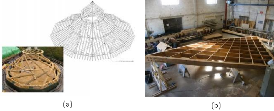
Şekil 5.26 Hiperbolik paraboloid sistem kuruluşu (a) Hill Holt Woodland Centre ve (b) Gillespie Hyperbole [137]
