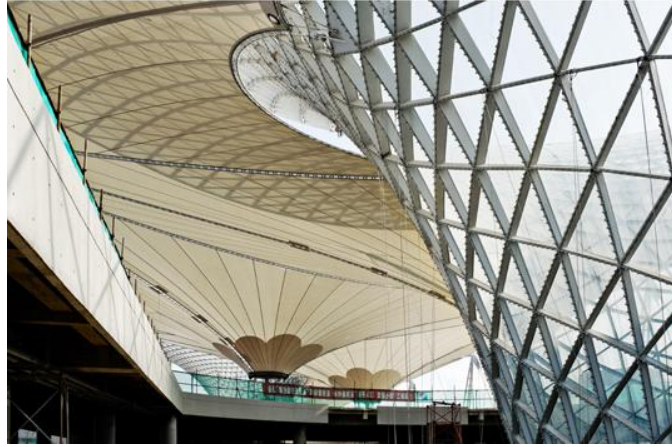
Şekil 7.9 Shanghai Expo Boulevard yapısı [215]
