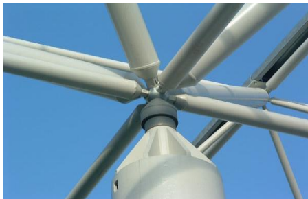
Şekil EK-1.1 Çift tabakalı uzay kafes sistemlerin ana elemanları [229]
