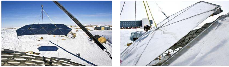
Şekil 6.18 Vinç ile kaldırma yöntemi [191]
