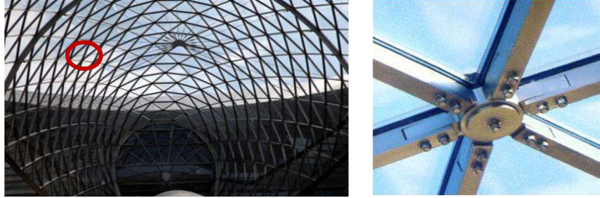
Şekil 4.41 DZ Bank yapısının taşıyıcı sisteminde kullanılmış SBP-3 birleşimi [119]
