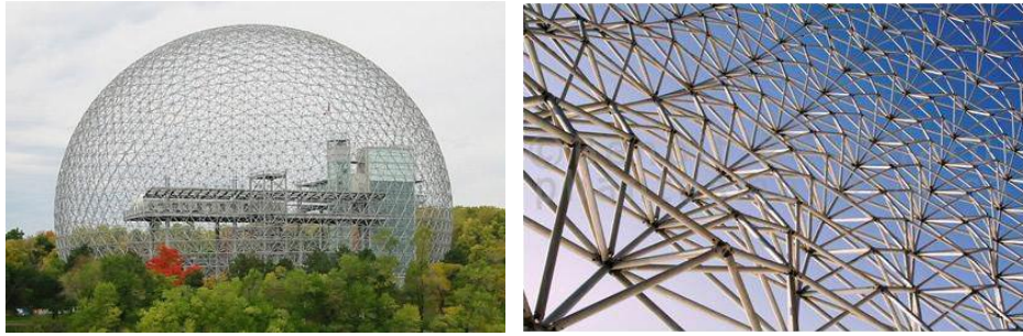
Şekil 3.14 Biosfer, Kanada (Fuller, 1967) ve taşıyıcı sistem detayı [37], [38]
