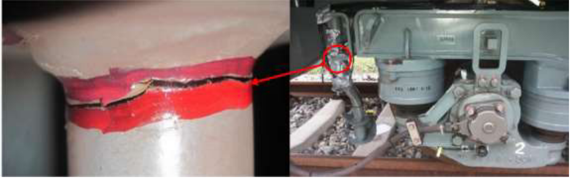
Şekil 2.11. Hasar Almış Koruyucu Demir
