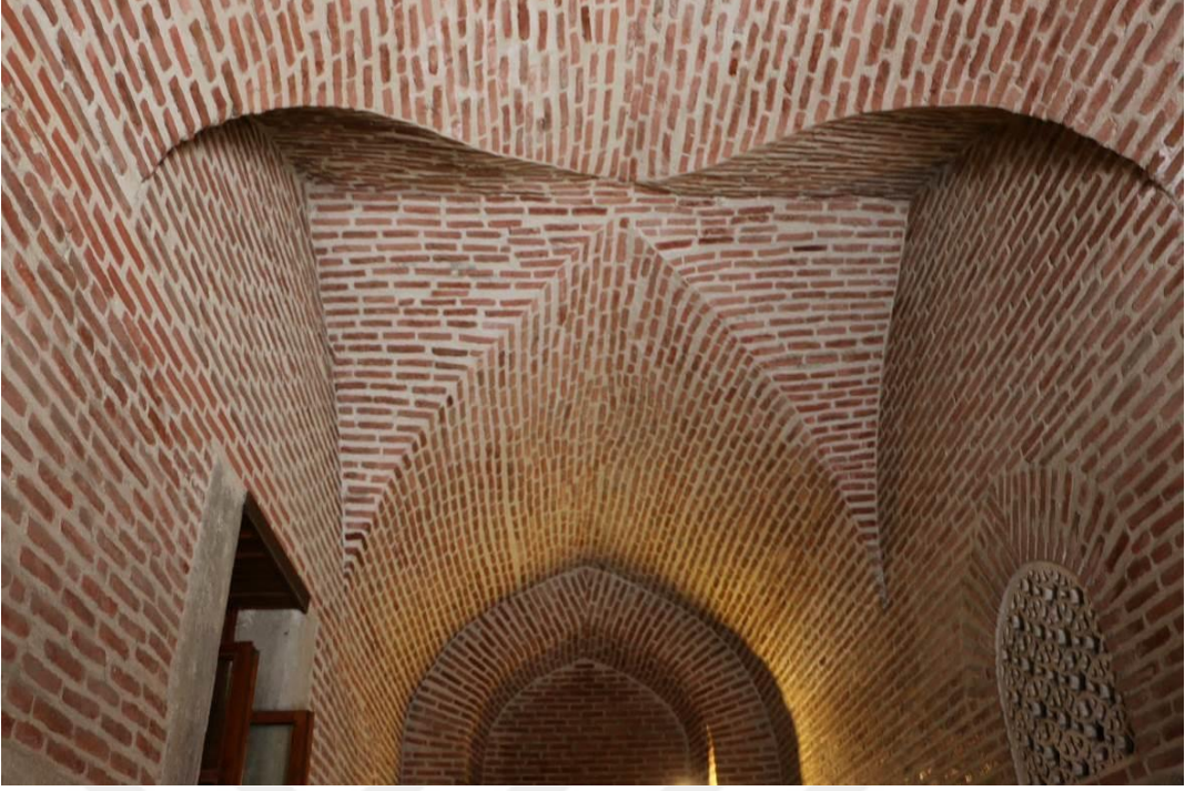
Şekil 4.64. Sahip Ata Hankahı Giriş Eyvanı Çapraz Tono.
