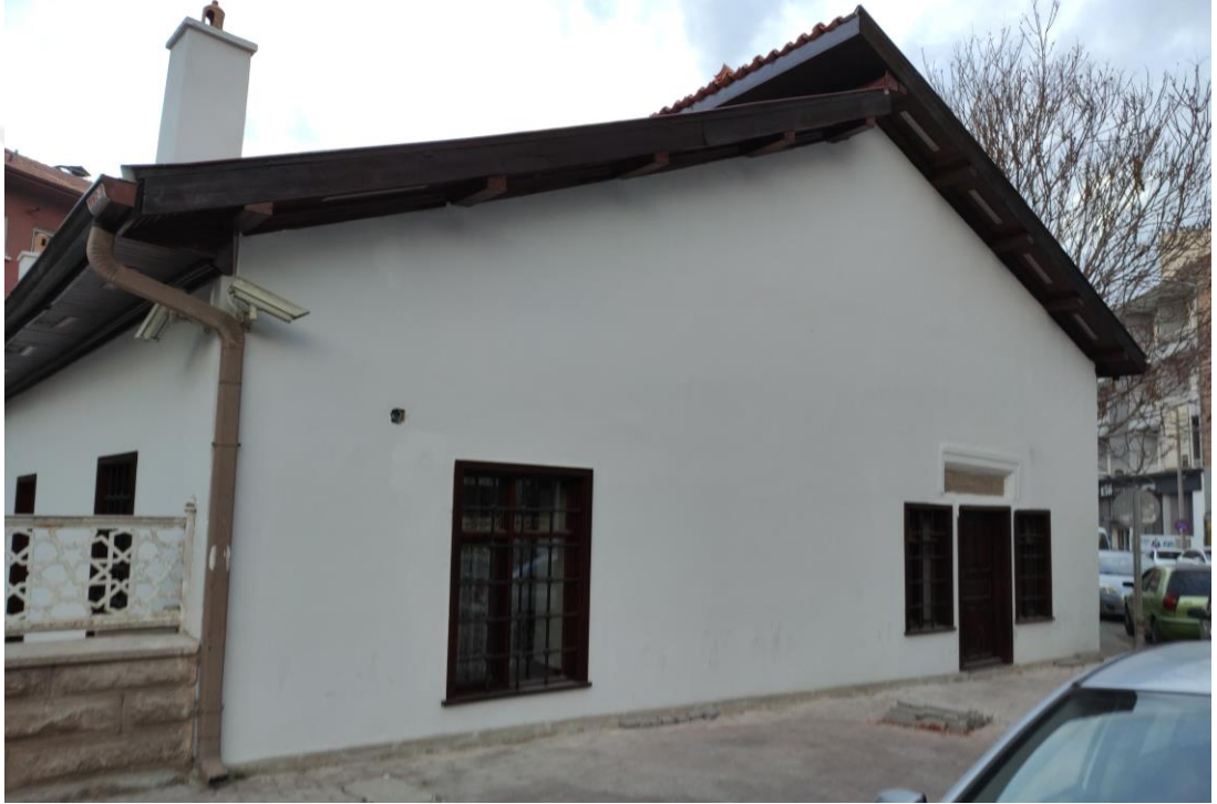
Şekil 4.18. Ebu İshak Kazeruni Zaviyesi Kuzey Cephe Genel Görünümü.
