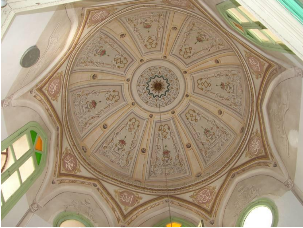
Şekil 4.244. Fatma Hatun Türbesi Kubbe Teziniatı (Ceraı Mimarlık Arşivi).
