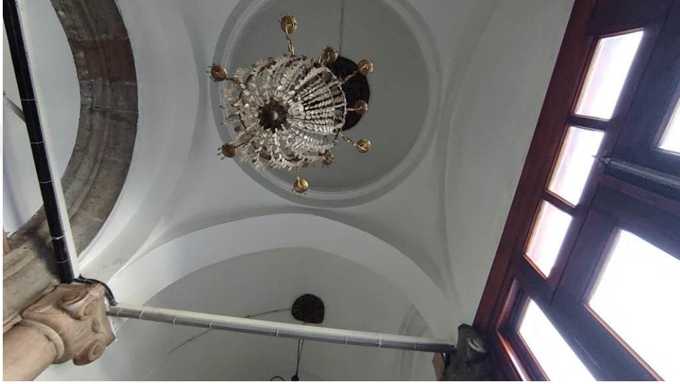
Şekil 4.191. Matbah-ı Şerif Revaklı Bölümde Bulunan Kubbe.
