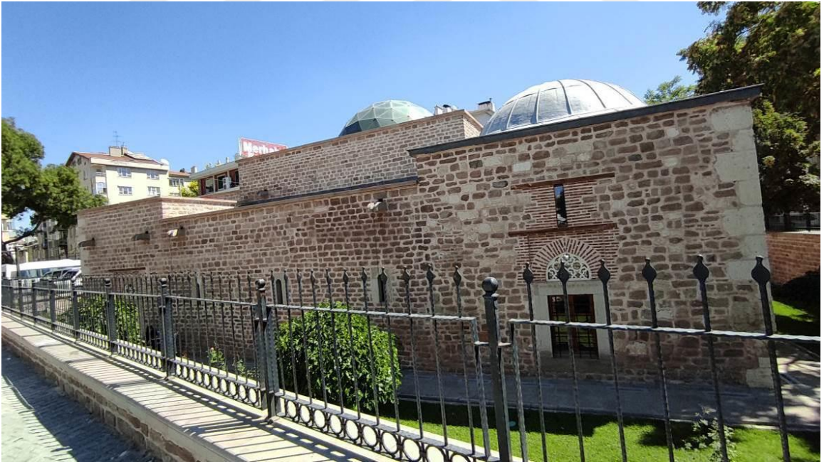
Şekil 4.128. Ali Gav Zaviyesi Batı Cephesi.
