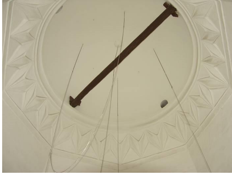
Şekil 4.231. Hürrem Paşa Türbesi Türk Üçgenleri ve Kubbe (Ceray Mimarlık Arşivi).
