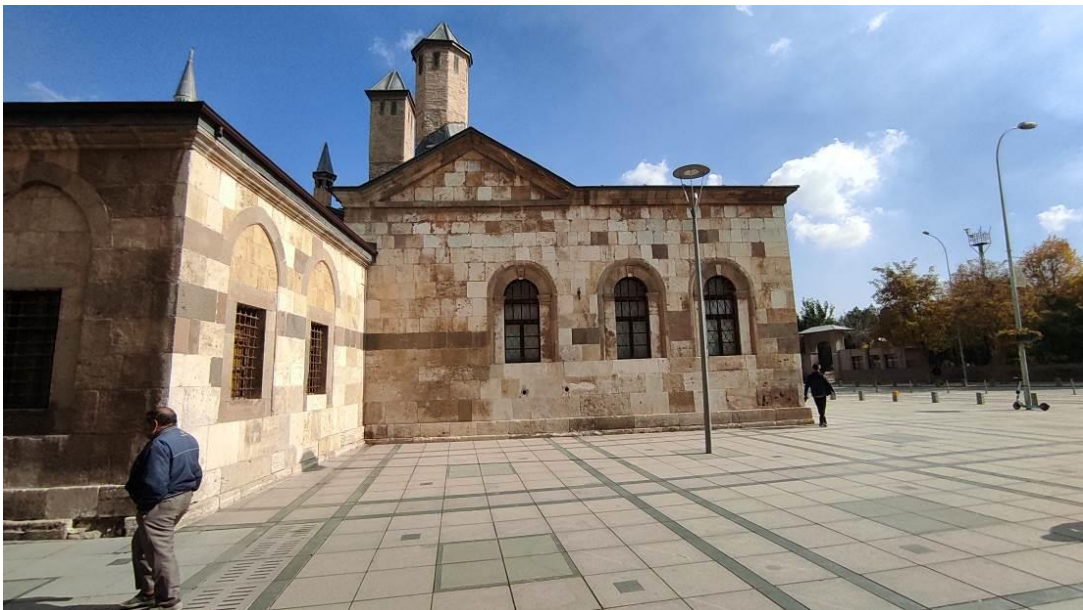
Şekil 4.205. Matbah-ı Şerif Batı Cephesi.
