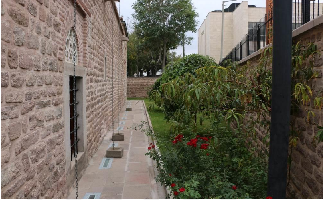
Şekil 4.130. Ali Gav Zaviyesi Batı Cephesi Bahçesi.
