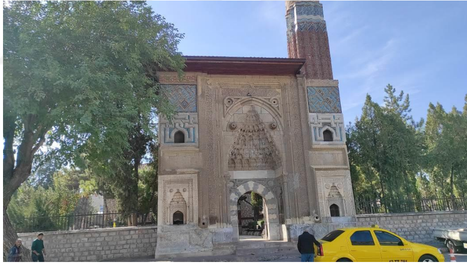
Şekil 4.84. Sahip Ata Camii Taç Kapısı.
