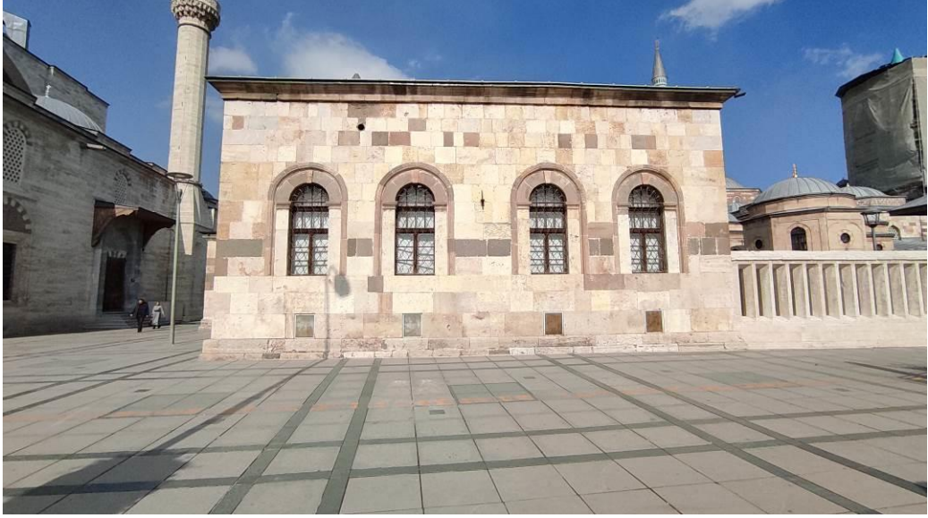
Şekil 4.204. Matbah-ı Şerif Güney Cephesi.
