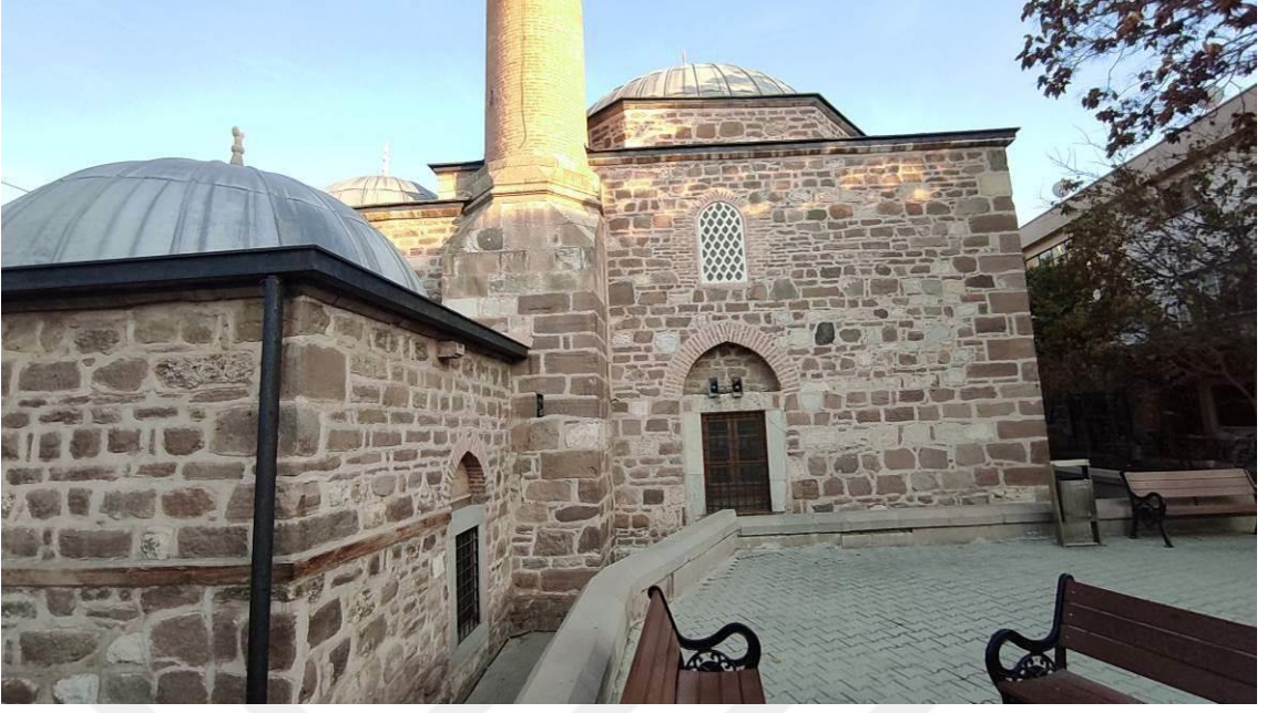
Şekil 4.325. Piri Mehmet Paşa Cami Batı Cephesi.
