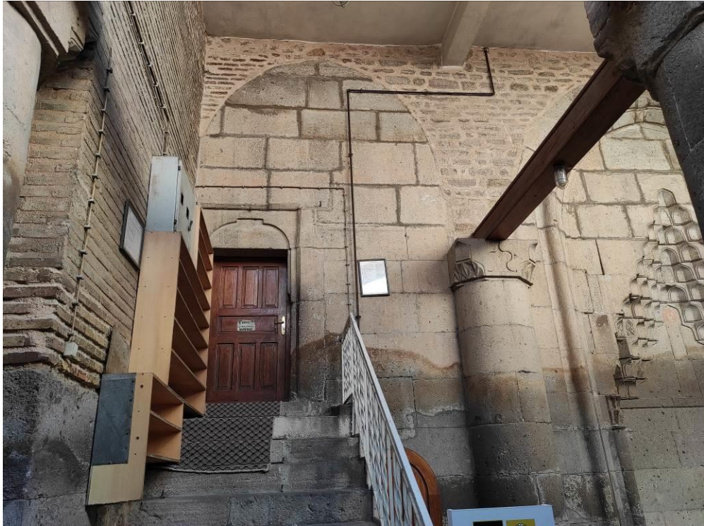
Şekil 4.284. Bulgur Dede Tekkesi Kuzey Cephe Mescit Giriş Kapısı.
