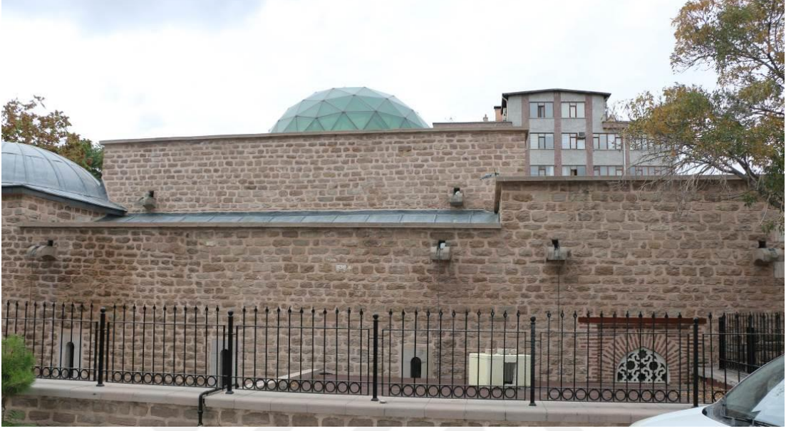
Şekil 4.126. Ali Gav Zaviyesi Doğu Cephesi Taş Çörtenler ile Geodezik Temperli Cam Kubbe.
