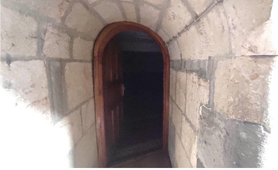
Şekil 4.266. Zemin Kat Mescidine Geçiş Sağlayan Tonoğlu Koridor.
