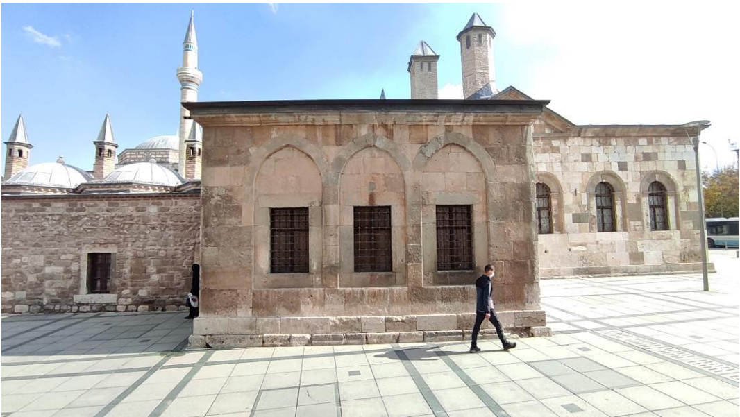
Şekil 4.214. Meydan-ı Şerif Batı Cephesi.
