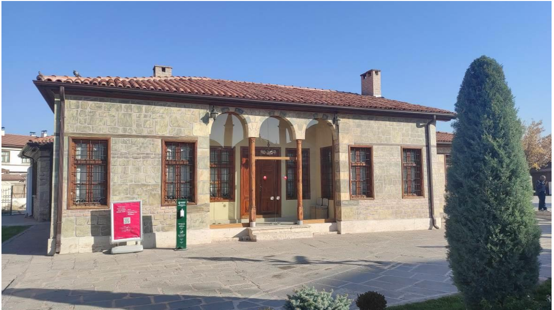
Şekil 4.222. Çelebi Konağı Güney Cephesi.
