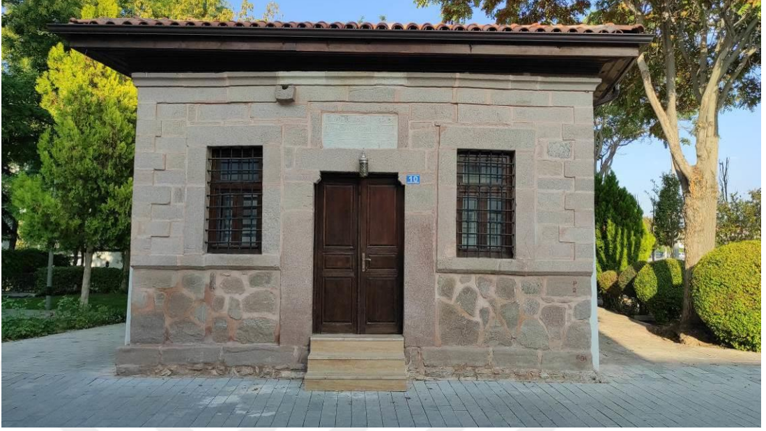
Şekil 4.37. Fatma Hatun Süt Tekkesi Batı Cephesi.
