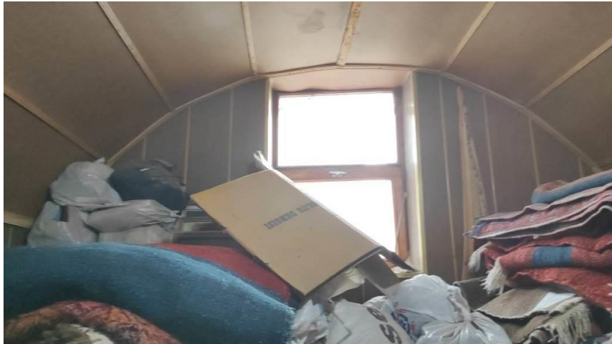
Şekil 4.319. Odanın Güney Duvarı ve Penceresi.
