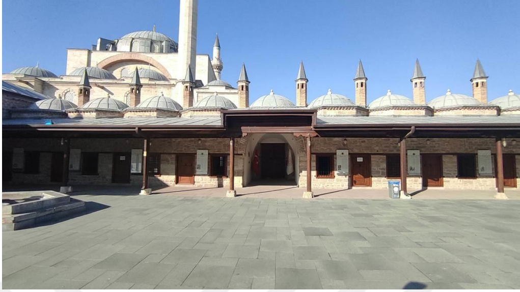
Şekil 4.186. Dedegan Hücreleri Doğu Cephesi.
