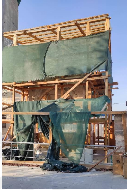
Şekil 4.233. Mehmet Bey Türbesi Restorasyon Çalışmaları.
