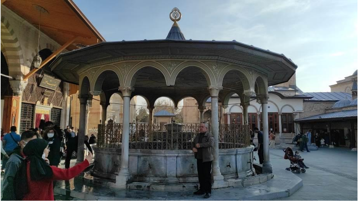
Şekil 4.246. Şadırvan Kuzey Cephesi.
