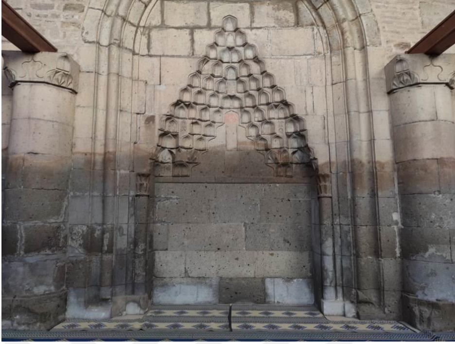
Şekil 4.264. Son Cemaat Mahallinde Bulunan Mihrap.
