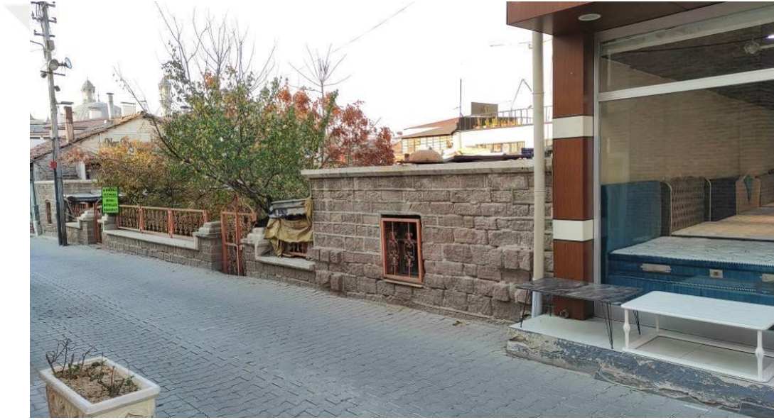
Şekil 4.296. Piri Mehmet Paşa Zaviyesinin Güney Cephesi.
