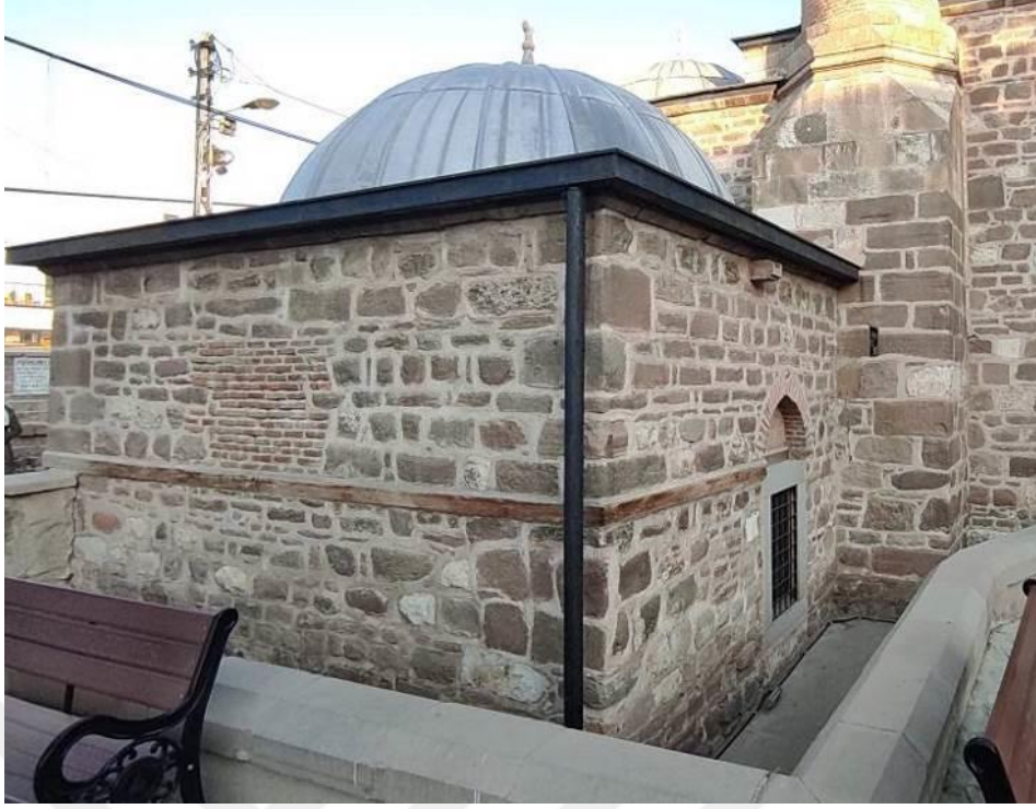
Şekil 4.334. Camiye Bitişik Yapının Batı Duvarının Dış Cephesinde Görülen Tuğla Örgü.
