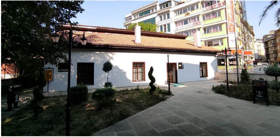
Şekil 4.16. Ebu İshak Kazeruni Zaviyesi Doğu Cephe Genel Görünümü.
