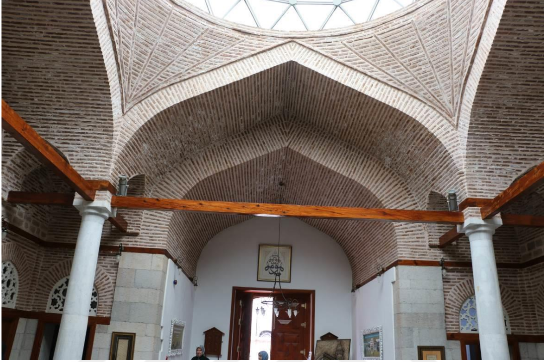
Şekil 4.111. Ali Gav Zaviyesi Kuzey Giriş Eyvanı.
