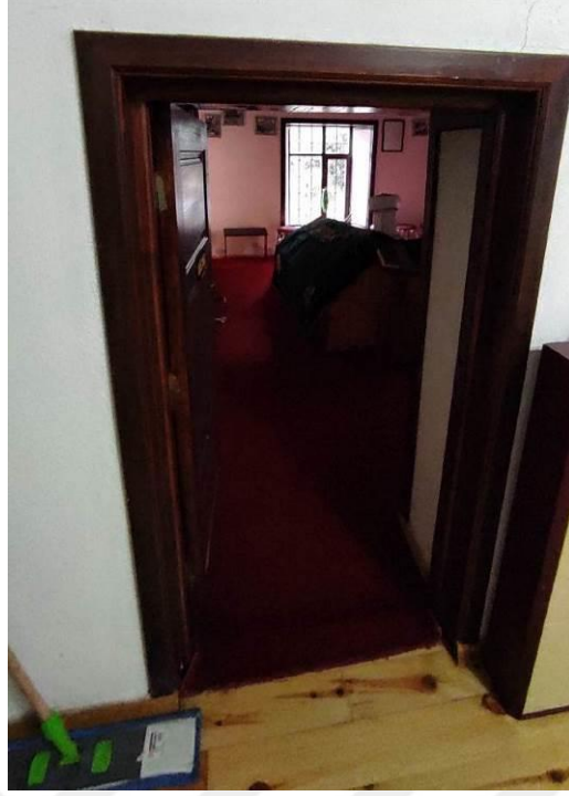
Şekil 4.11. Türbeye Geçiş Kapısı ve Sanduka.
