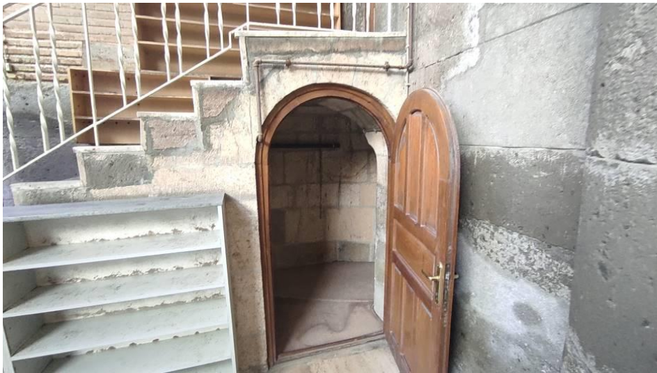
Şekil 4.265. Sahanlığın altında bulunan ahşap kapı.
