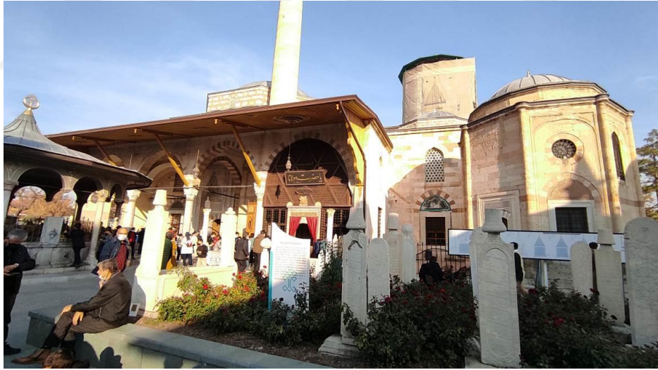
Şekil 4.171. Mevlana Aistanesi Ana Bina Batı Cephesi.
