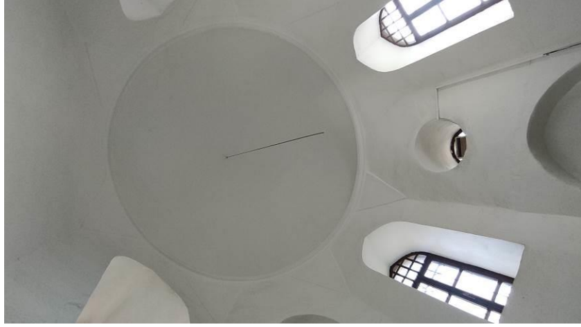
Şekil 4.239. Sinan Paşa Türbesi İçerden Kubbeye Bakış.
