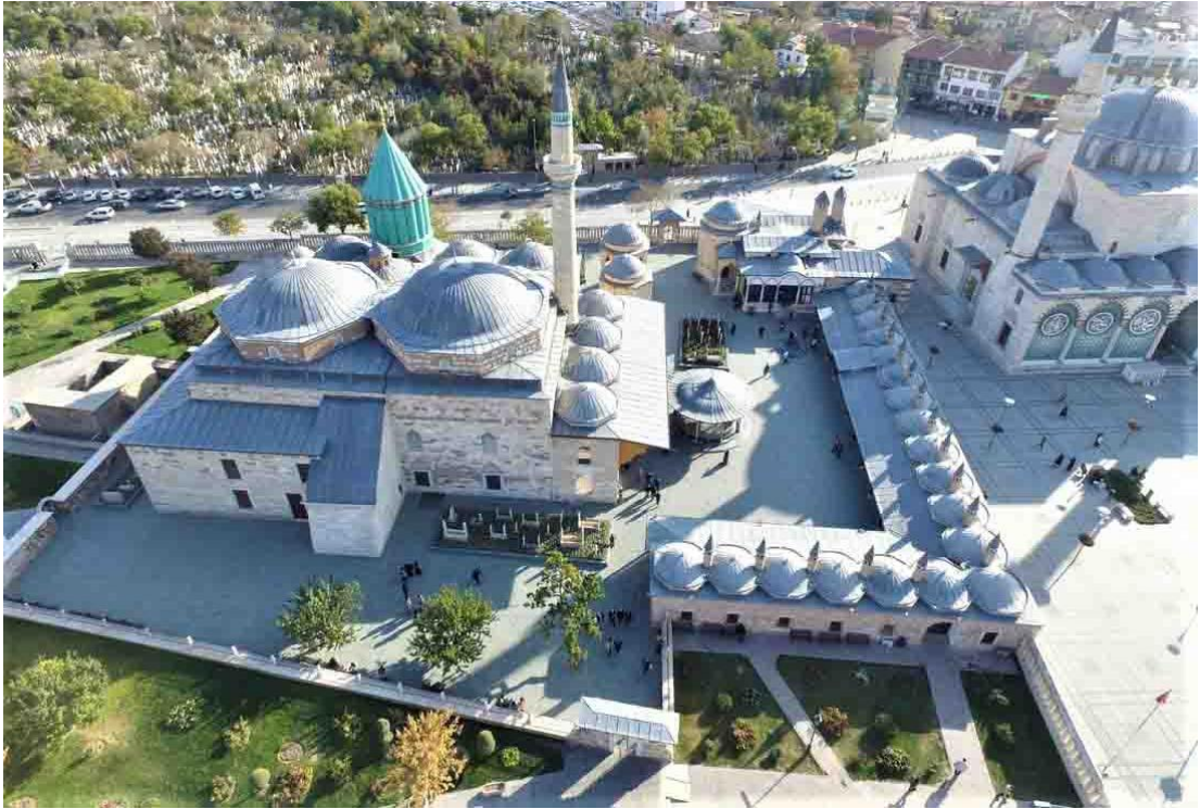
Şekil 2.10. Mevlana Dergâhı Hava Fotoğrafı (Anonim3, 2020).
