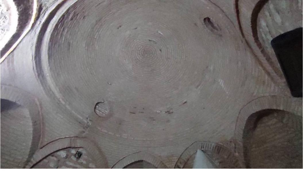
Şekil 4.339. Matbahın Kubbesi ve Kubbeye Geçiş Elemanları.
