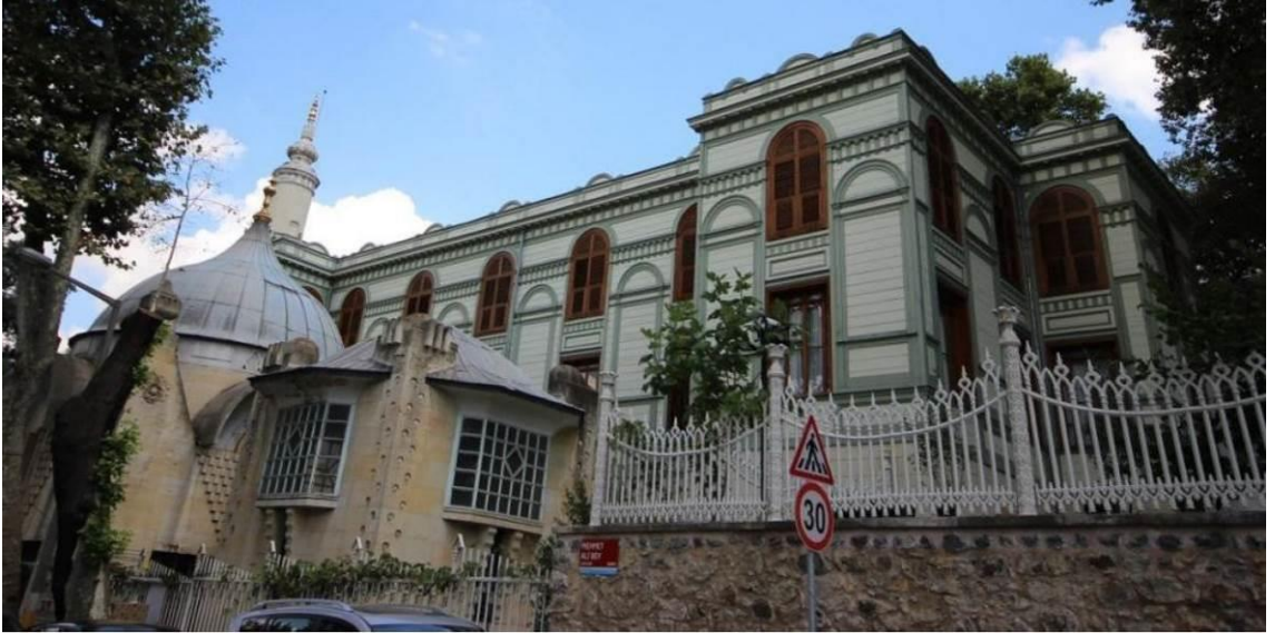
Şekil 3.12. Ertuğrul Tekkesi, Türbe ve Kütüphanesinin Güneybatı Cephesi (Özgür Yıldız, Eryılmaz, 2019).
