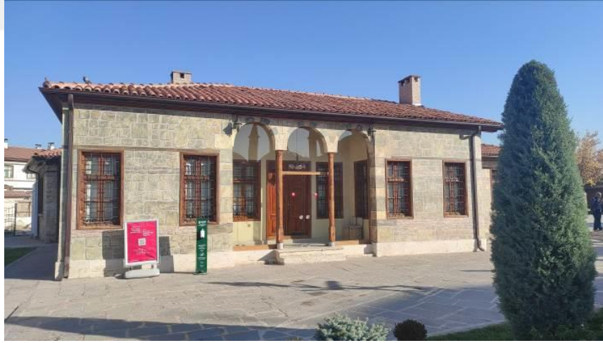
Şekil 4.143. Çelebi Konağı Güney Cephesi.
