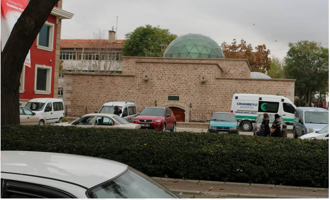
Şekil 4.118. Ali Gav Zaviyesi Kuzey Cephesi.
