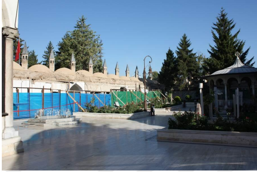
Şekil 4.152. Derviş Hücrelerinin Restorasyon Uygulaması Sırasında Görünüşü.
