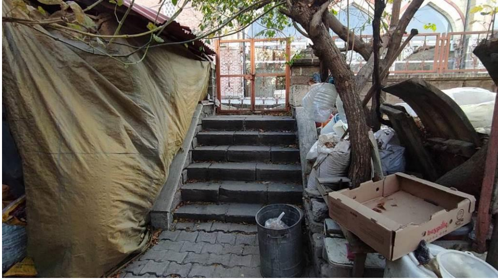
Şekil 4.299. Piri Mehmet Paşa Zaviyesi Doğuda Yer Alan Avlu Kapısı ve Merdiveni.
