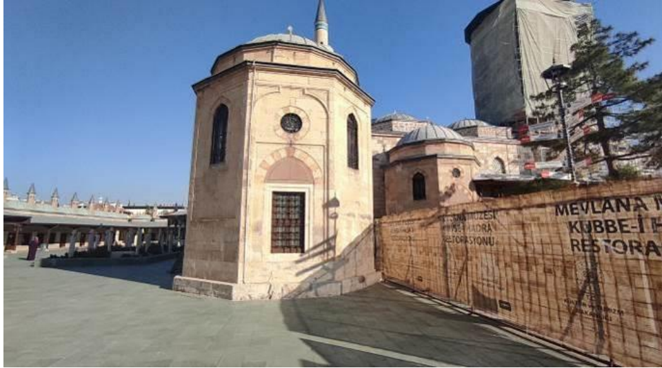
Şekil 4.144. Sinan Paşa Türbesi Güney Cepheden Görünüm.
