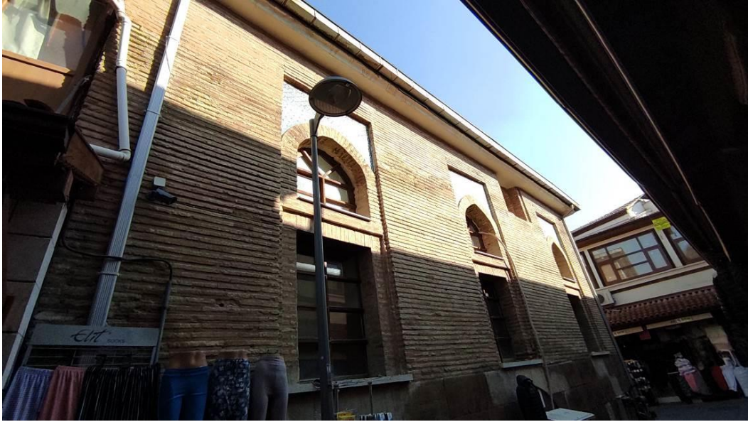
Şekil 4.279. Bulgur Dede Tekkesi Güney Cephesi.
