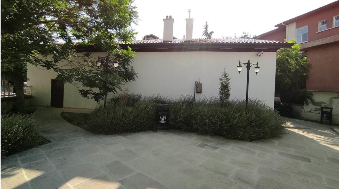
Şekil 4.22. Ebu İshak Kazeruni Zaviyesi Batı Cephe Genel Görünümü.
