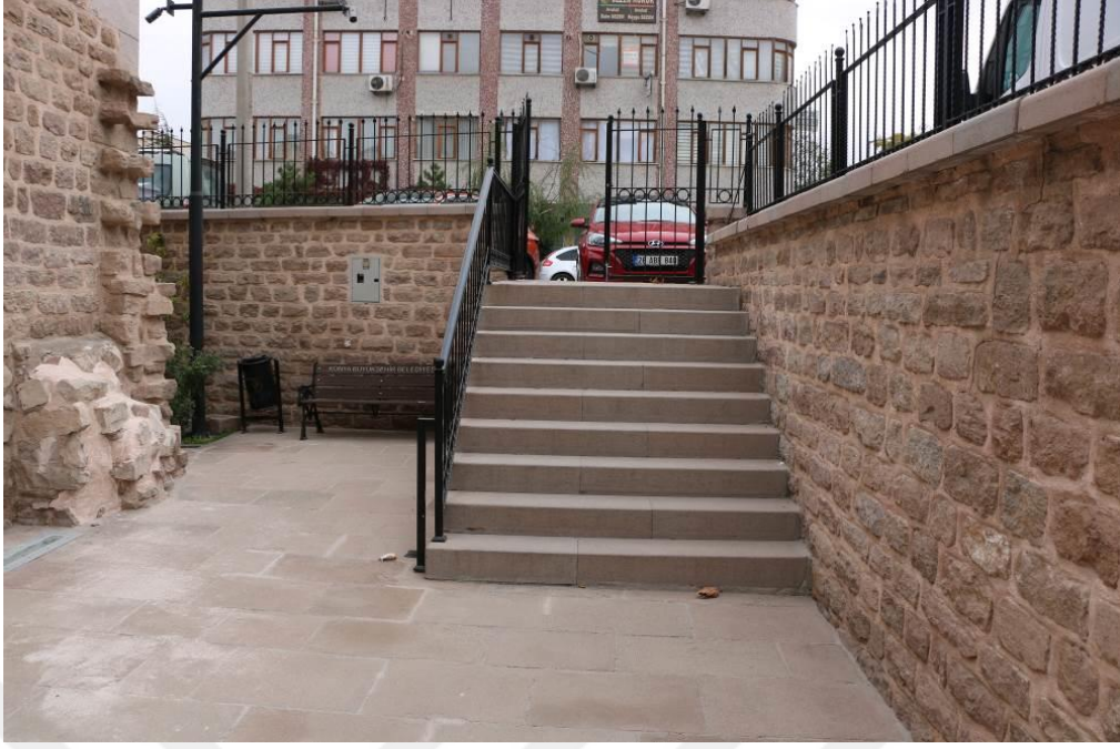
Şekil 4.121. Ali Gav Zaviyesi Kuzey Cephede Yer Alan Taş Merdiven.
