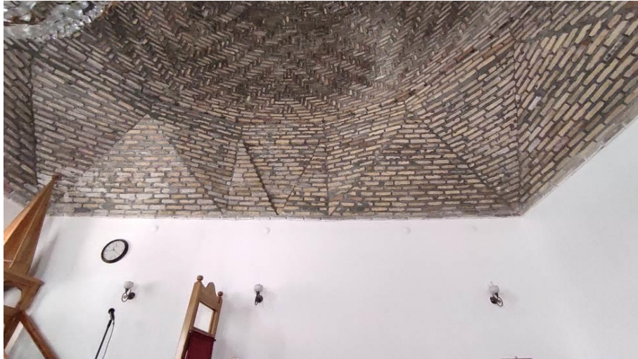
Şekil 4.275. Harimde Kubbeye Geçiş Elemanı Olarak Türk Üçgenleri.
