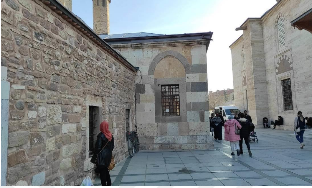
Şekil 4.218. Meydan-ı Şerif Kuzey Cephesi.
