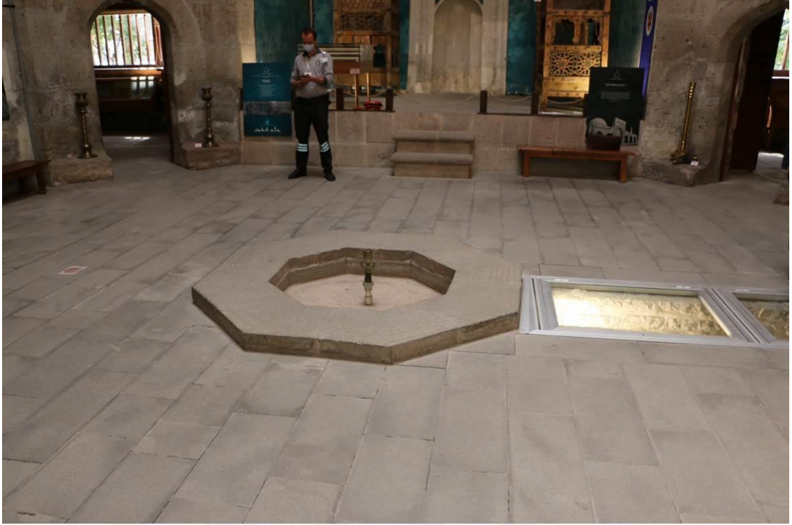
Şekil 4.66. Sahip Ata Halkahı Havuz ve Su Kanalı.
