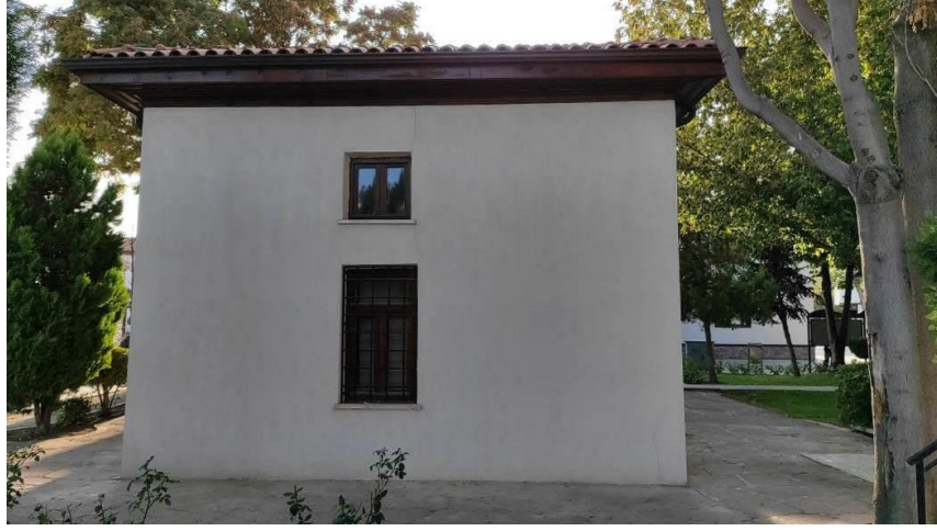
Şekil 4.41. Fatma Hatun Süt Tekkesi Doğu Cephesi.
