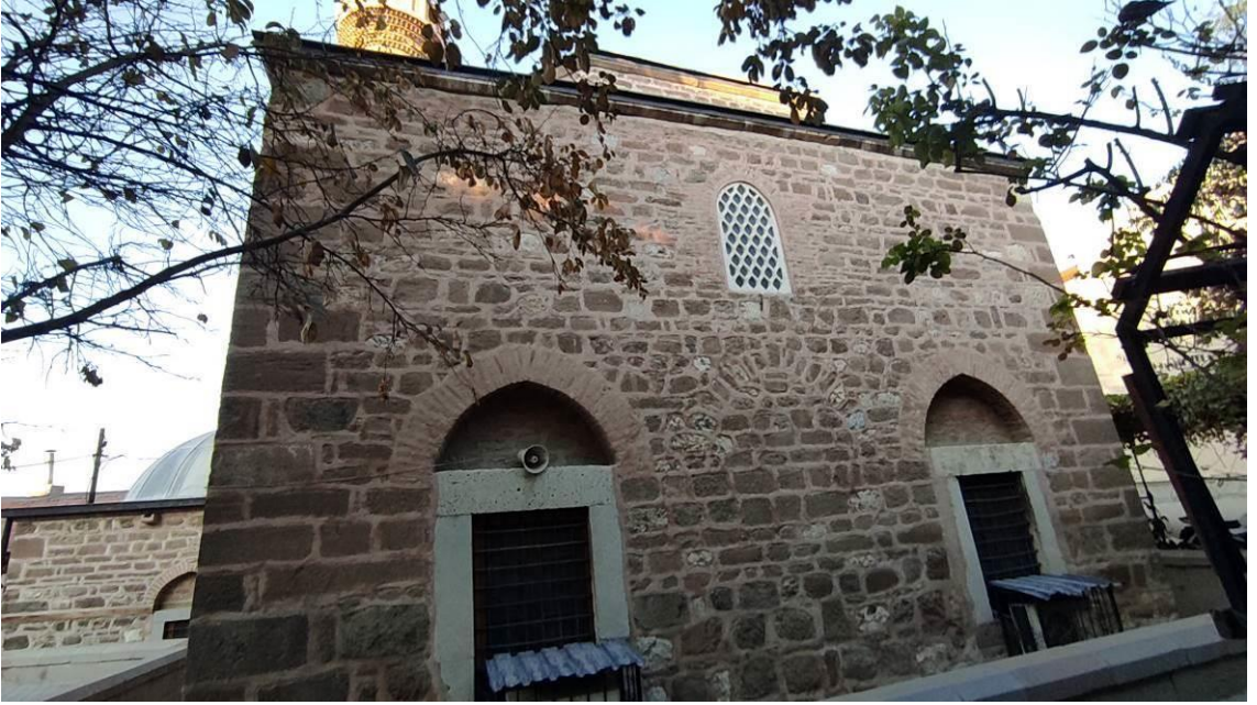
Şekil 4.326. Piri Mehmet Paşa Cami Güney Cephesi.
