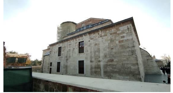
Şekil 5.20. Mevlana Âsîtânesi Doğu Cephesi.
