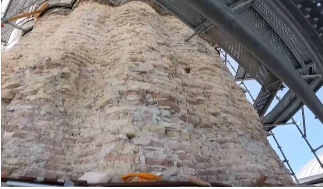
Şekil 4.154. Kubbe-i Hadra'nın Tuğla Duvar Örgüsü (Anonim15, 2021).
