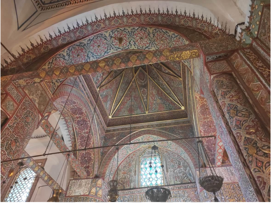
Şekil 4.164. Mevlana'nın Türbesinin Üst Örtüsü.
