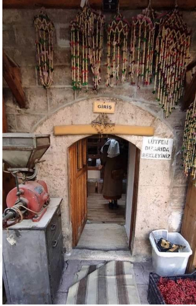
Şekil 4.309. Piri Mehmet Paşa Zaviyesi Batı Duvarı Yer Alan Giriş Kapısı.
