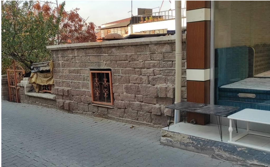
Şekil 4.298. Piri Mehmet Paşa Zaviyesi Doğu Kolu Güney Cephesi.
