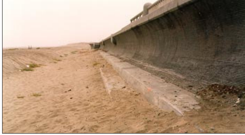
Şekil 2.10 Kavisli-yüzlü düşey kıyı duvarı [7]
