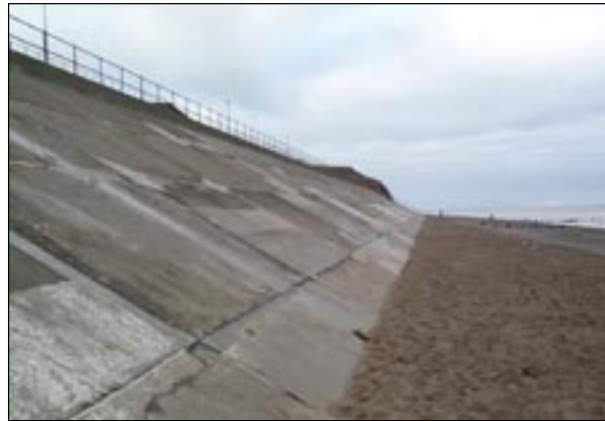
Şekil 2.7 Porozitesiz eğimli kıyı duvarı [5]
