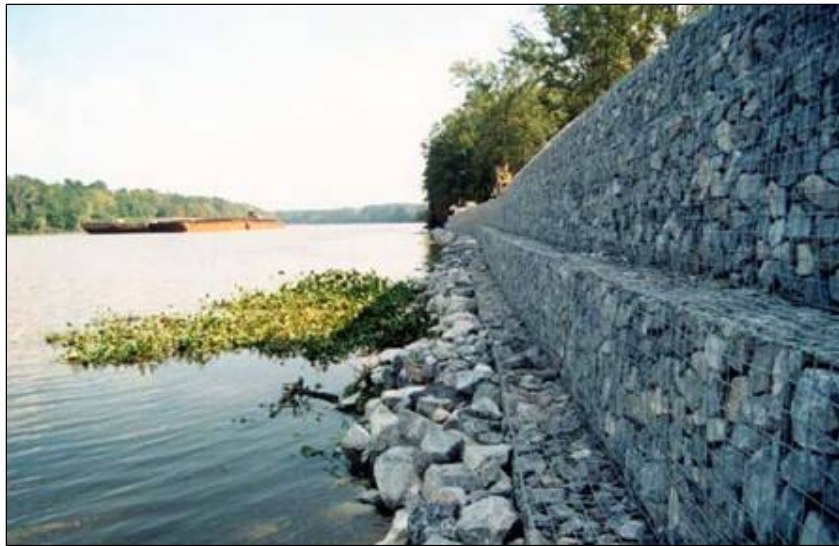
Şekil 2.11 Gabion tipi bir kıyı duvarı [9]
