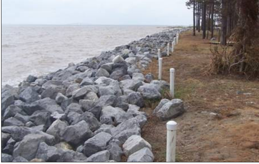
Şekil 2.1 Taş dolgu kaplama [1]
