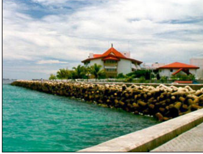
Şekil 2.6 Beton bloklu kıyı duvarı [4]
