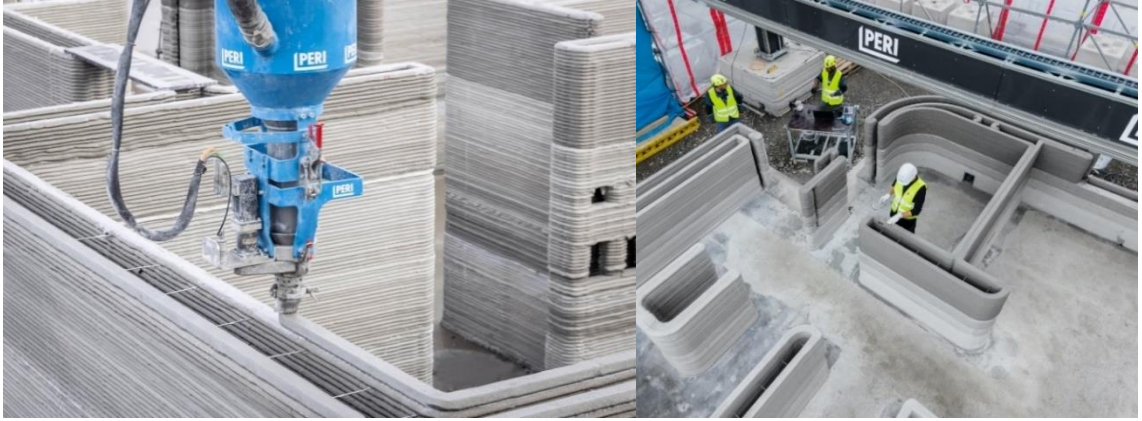
Görsel 3.28. Üç boyutlu beton yapı üretim ( http-12 )
