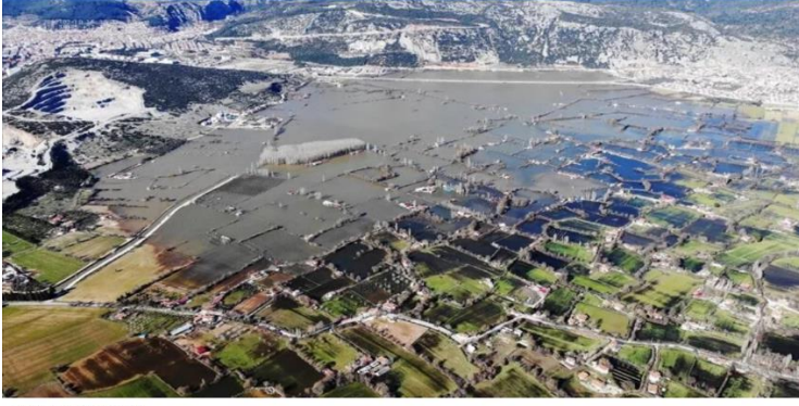
Görsel 3.5 Sular altında kalan 'çukur yaylada' drone ile hasar tespiti. 11
