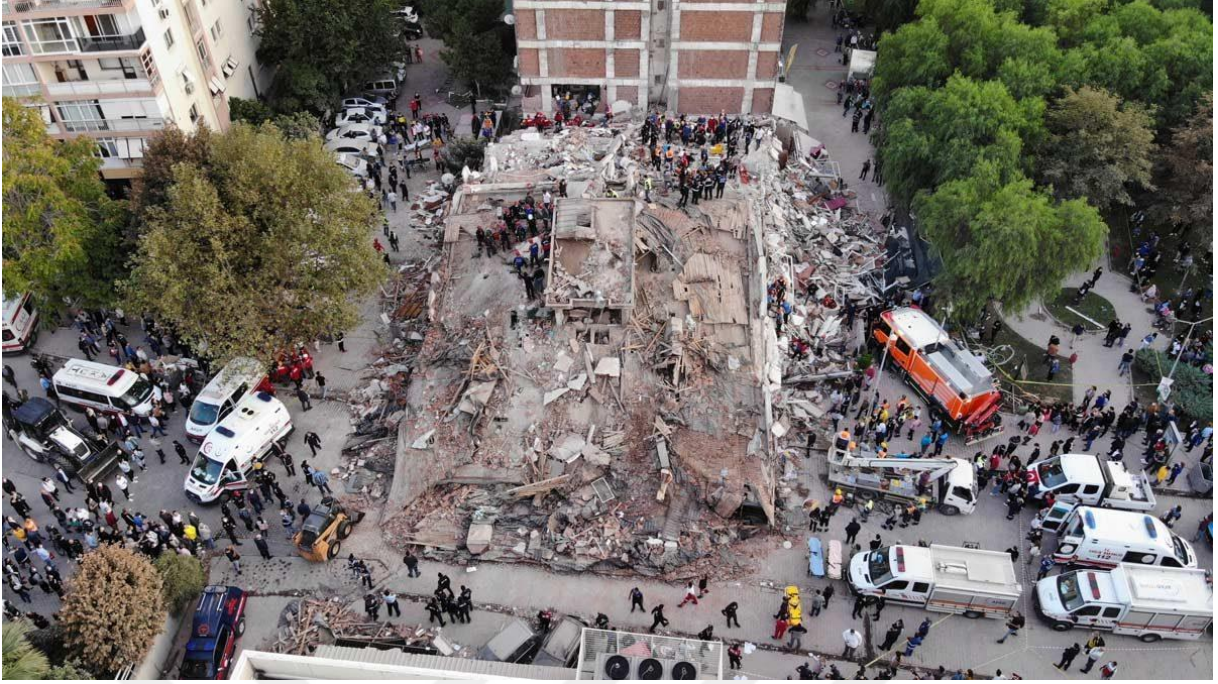
Görsel 2.2 30 Ekim 2020 tarihinde İzmir’de yaşanan depreme ait drone fotoğrafı.
