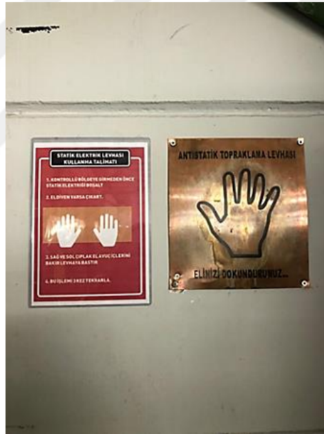
Şekil 4.1. Üretim alanında bulunan statik elektrik levhası
