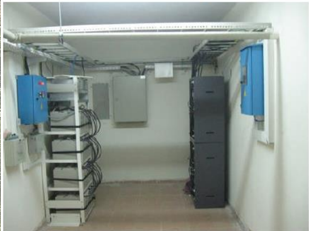
Resim 7.1. Telekomünikasyon baz istasyonu kabini ve iç görünümü [79]
