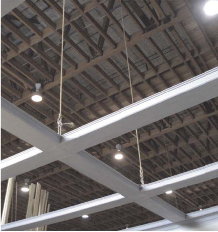
Resim 2.2. Setlerin tavandaki gridlere bağlanarak sabit hale getirilmesi [6]
