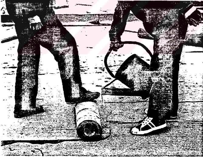
Resim 3.2. Sıcak asfalt ile bitümlü örtünün yapıştırılması
