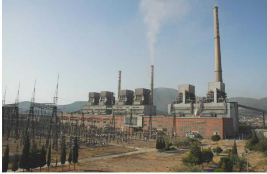
Şekil 3.4. Soma termik santrali
