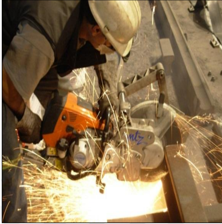
Şekil 2.13 Ray Kafalarının Kesilmesi.
