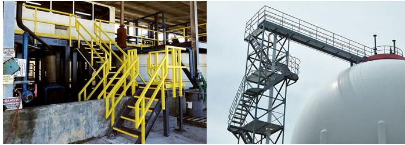
Görsel 2.2. Pultrüzyon yöntemiyle üretilmiş GFRP kompozit trabzanlar [47]
