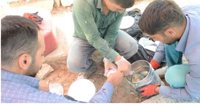
Şekil 5.19. Taşların Sağlamlaştırma ve Bir Araya Getirilmesinde Kullanılan Epoksinin Orantılanması
