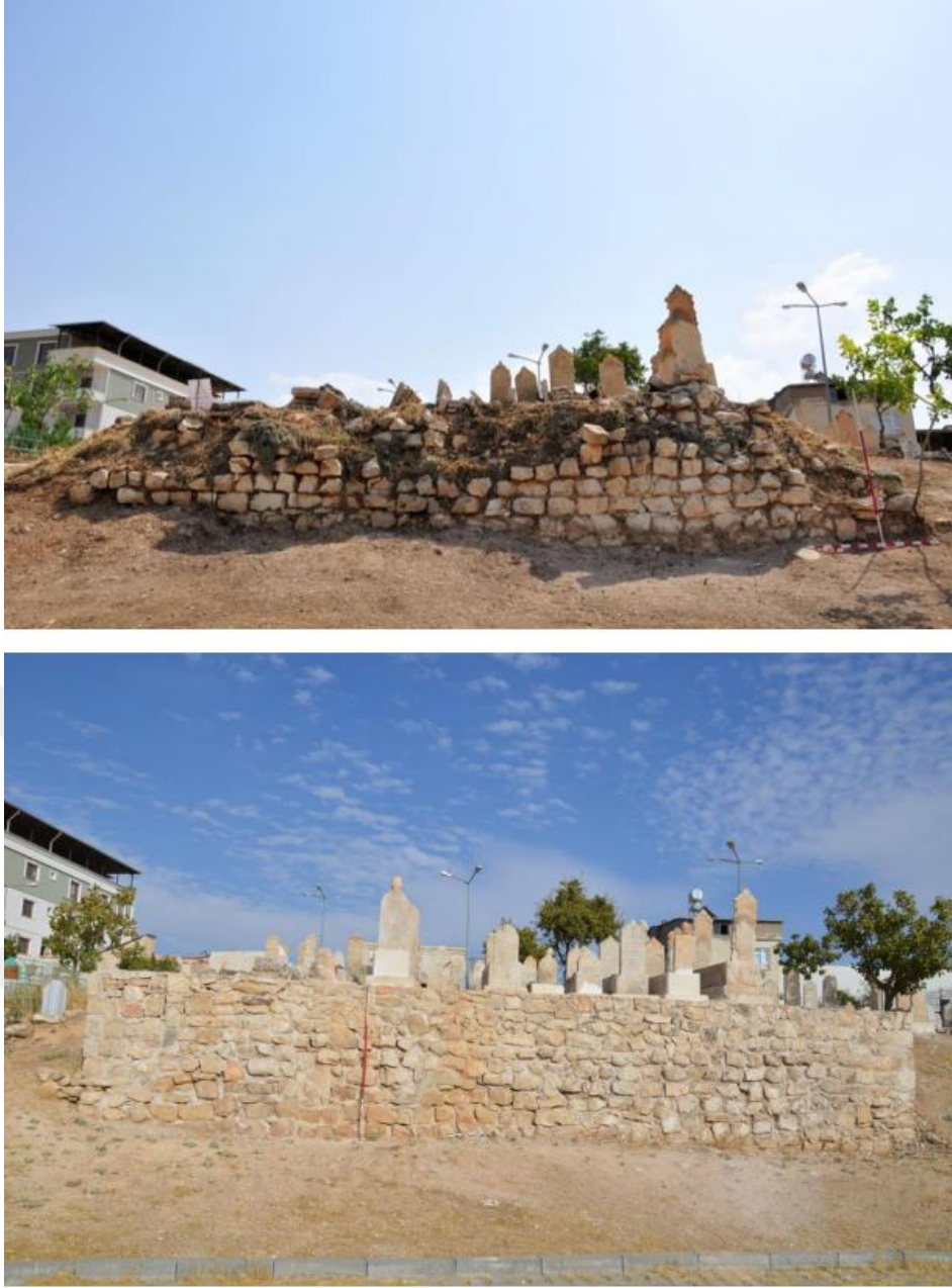
Şekil 5.14. Set Duvarının Restorasyon Öncesi-Sonrası Durumu
