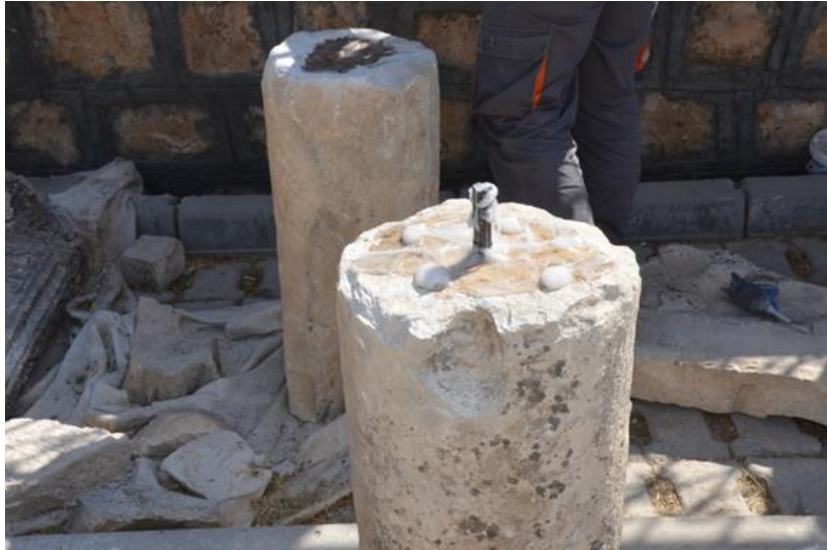
Şekil 5.29. Karbon Fiber Çubuk ve Epoksi Kullanılarak İkiye Ayrılmış Sütunların Bir Araya Getirilmesi
