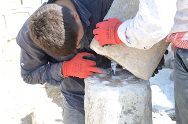
Şekil 5.30. İkiye Ayrılmış Sütun Parçaların Birleştirilmesi
