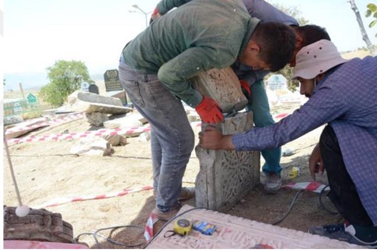
Şekil 5.22. Kopan İki Parçanın İki Taraftan Açılan Dübellerle Bütünleştirilmesi
