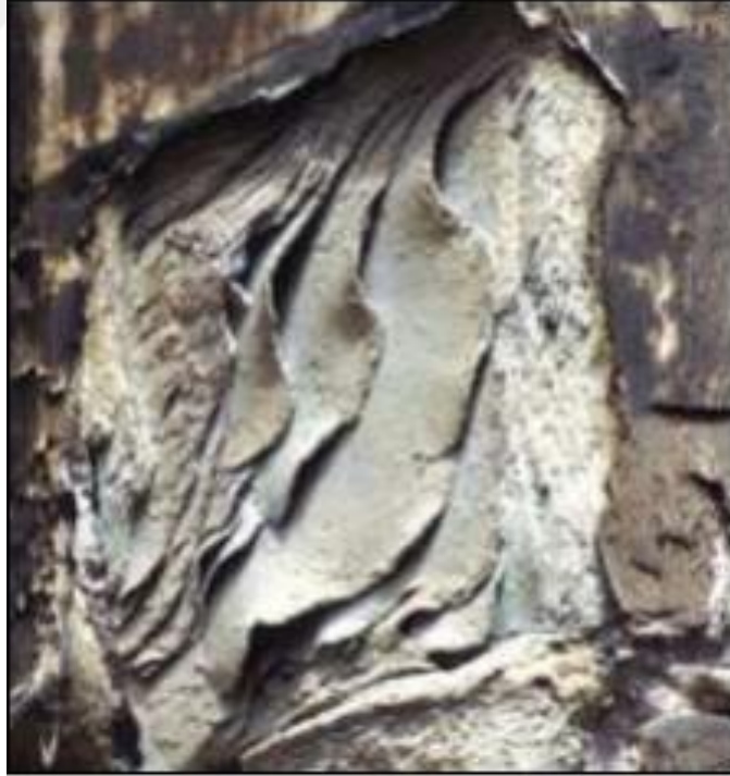
Şekil 4.9. Yapraklanma Örneği (MEB, 2013, S. 16).
