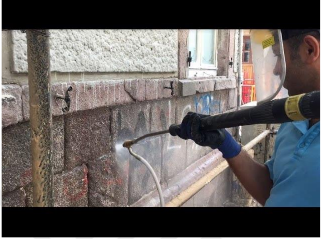
Şekil 4.17. Basınçlı Su İle Yıkama (Ersen, 2013, S. 6).
