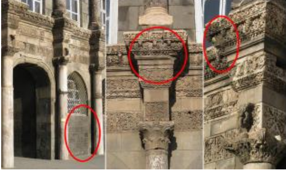
Şekil 4.6. Taş Yüzeyindeki Kararmalar (Hasbay ve Hattap, 2017, S. 32).
