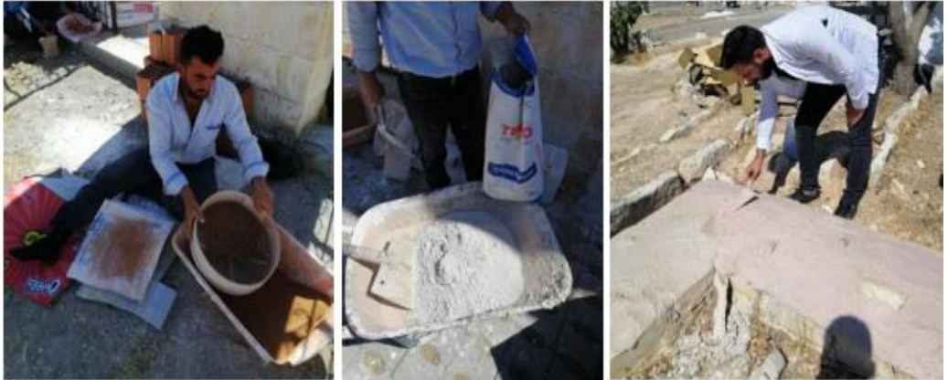
Şekil 5.13. İç Duvarların Restorasyon Uygulama Çalışmaları
