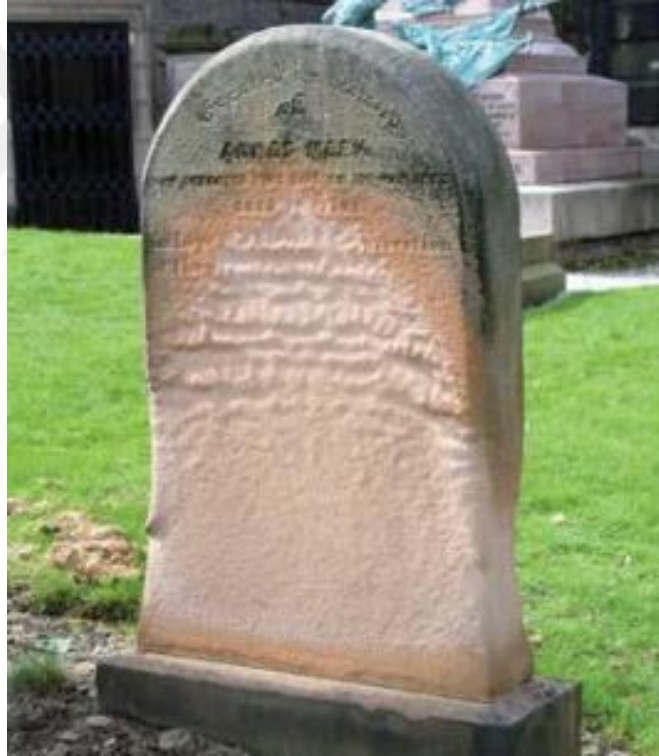
Şekil 4.11. Taşta Oluşan Tozlaşma (Hasbay Ve Hattap, 2017, S. 35).
