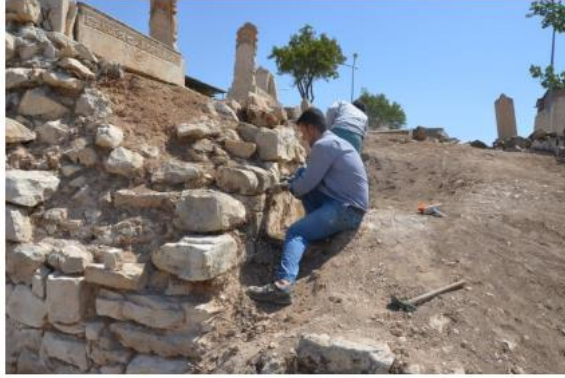
Şekil 5.12. Set Duvarının Onarılması
