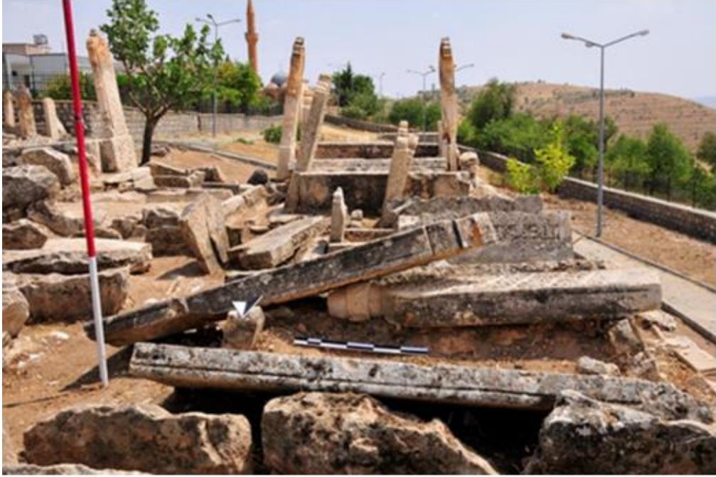
Şekil 5.46. Şeyh Ethem'in Kabri'nde Restorasyon Öncesi Genel Durumu
