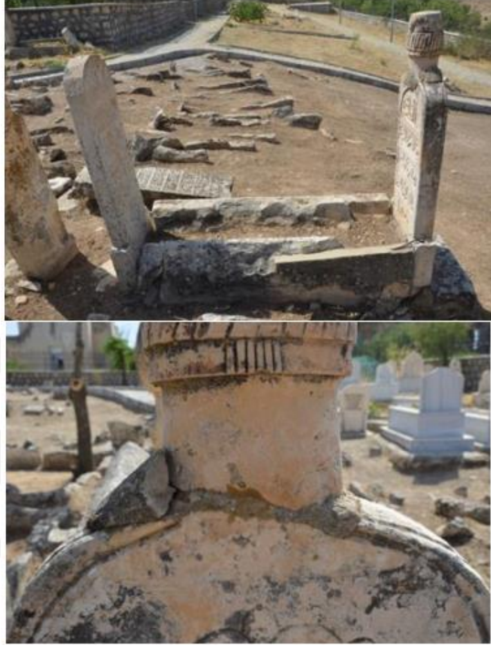
Şekil 5.34. OK18 Numaralı Mezarda Çimento Harç Ve Demir Kenet Kullanılması
