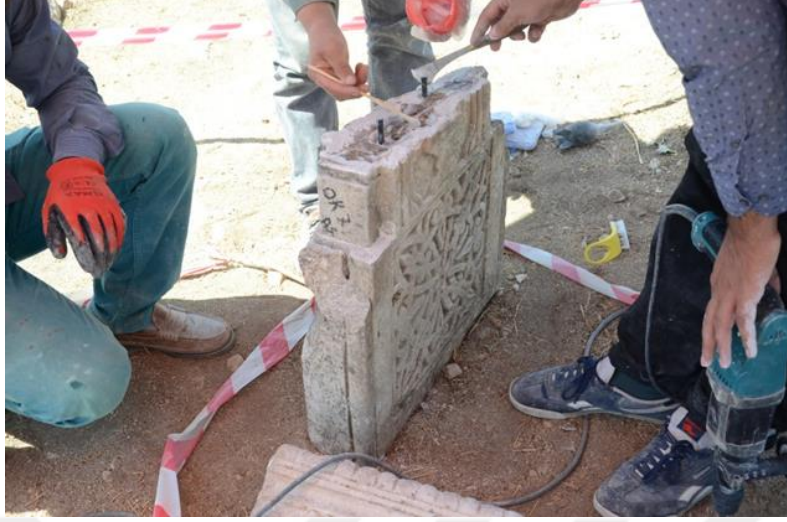
Şekil 5.21. Karbon Fiber Çubuk + Epoksi Kullanılması Uygulaması
