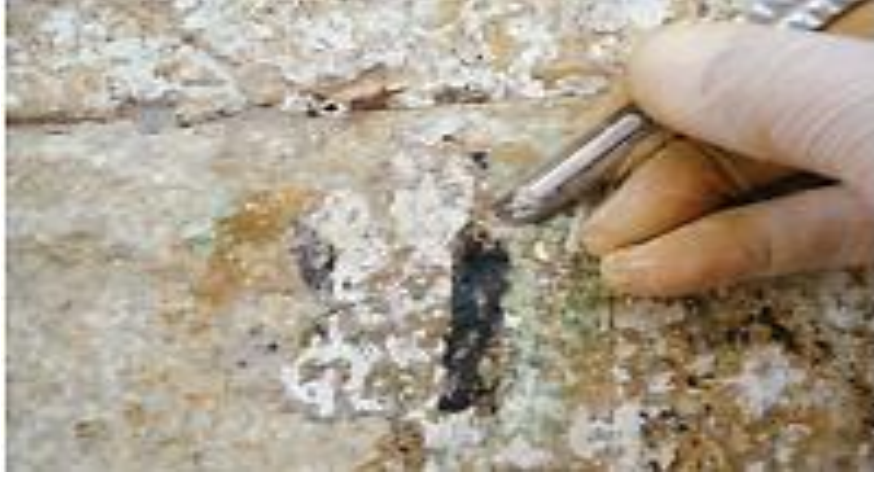
Şekil 4.18. Mekanik Temizleme Uygulaması (Ersen, 2013, S. 6).
