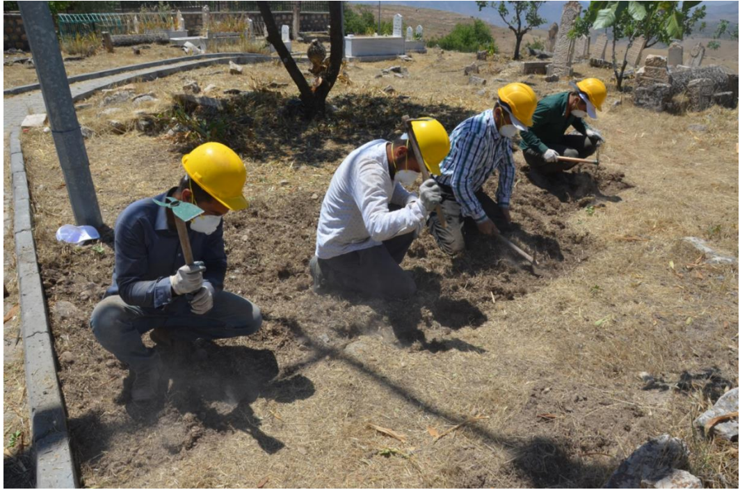
Şekil 5.9. Toprak Seviyesin Düşürülmesi ve Tahliyesine İlişkin Çalışma
