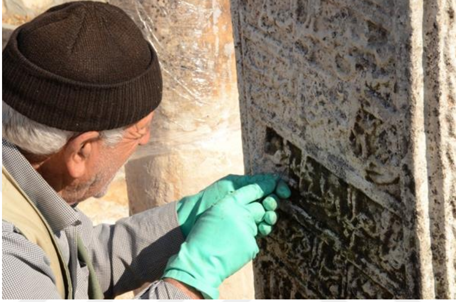
Şekil 5.31. Likenlerin Bistüri ve Spatula Yardımı İle Mekanik Olarak Alınması
