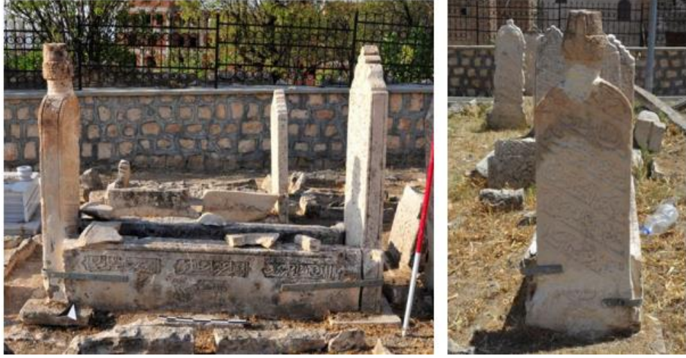
Şekil 5.36. KA3 Numaralı Mezarın Çelik Levha Kullanılarak Mezar Taşına Vidalanması Durumu
