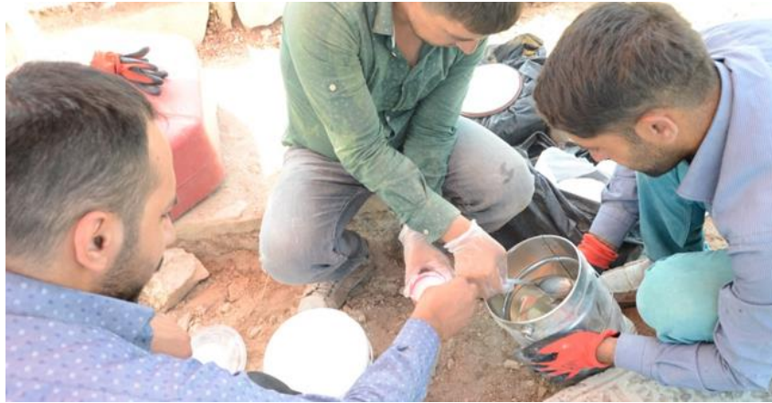
Şekil 5.19. Taşların Sağlamlştırma ve Bir Araya Getirilmesinde Kullanılan Epoksinin Orantılanması
