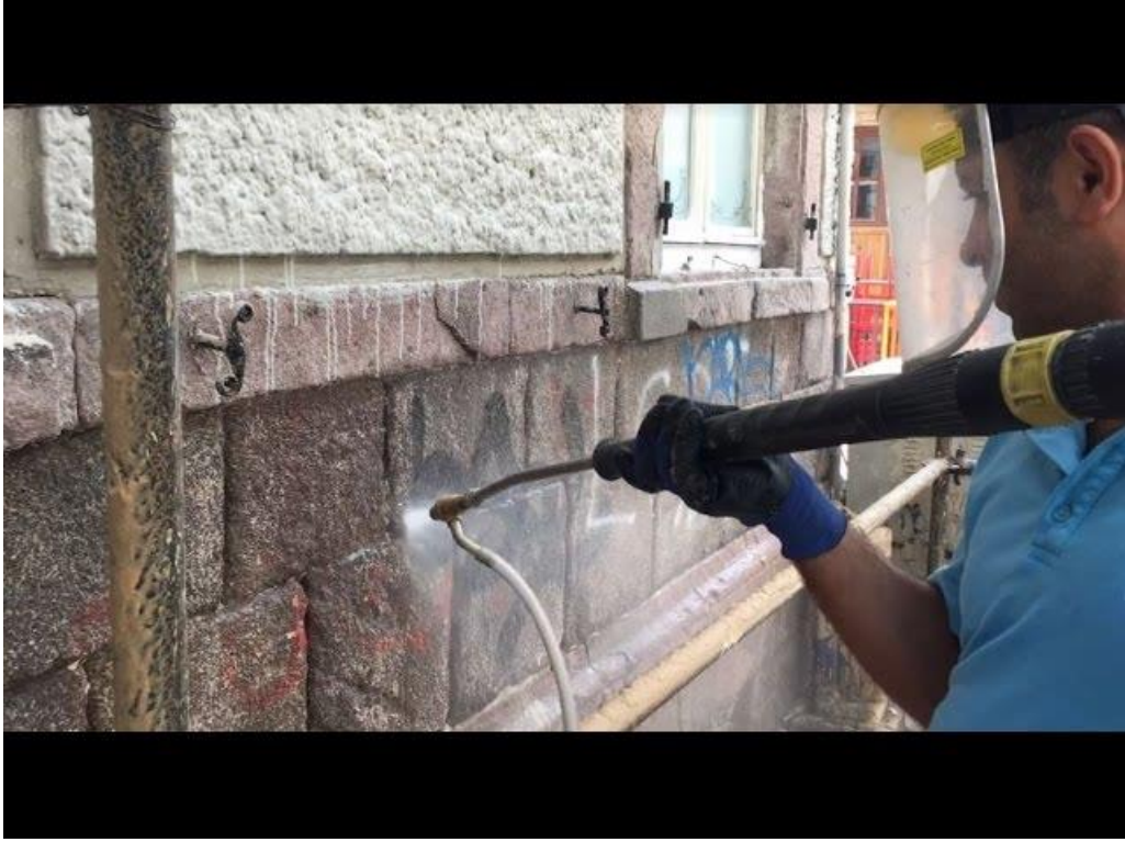
Şekil 4.17. Basınçlı Su İle Yıkama (Ersen, 2013, S. 6).
