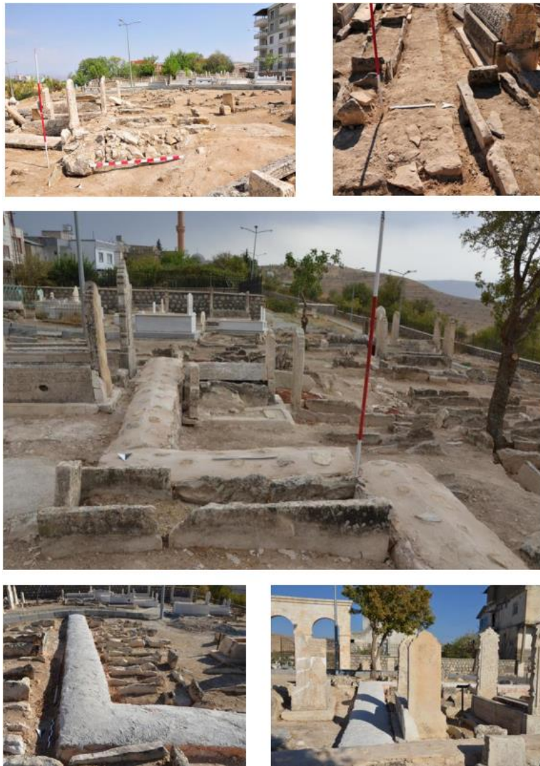
Şekil 5.15. İç Duvar Capping – Harpuşa Uygulama Öncesi-Sonrası
