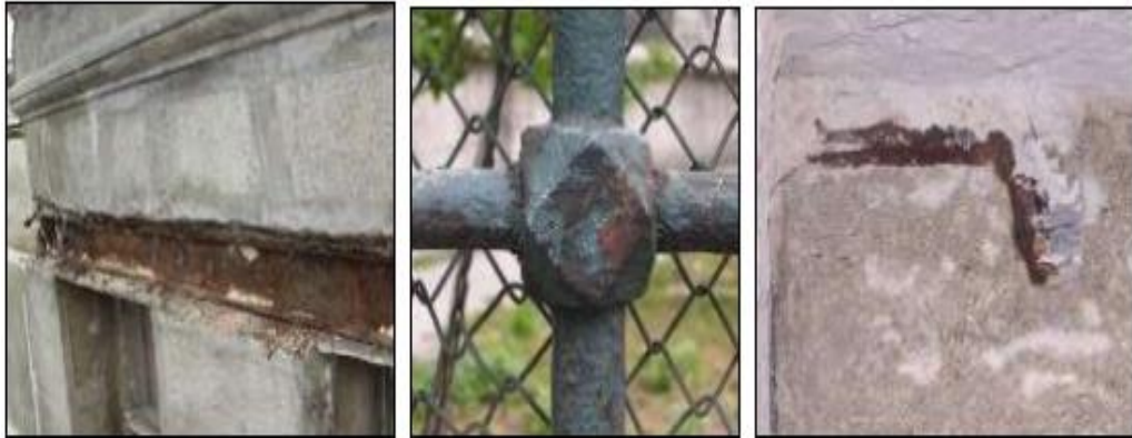
Şekil 4.13. Demir Elemanlarda Görülen Korozyon (MEB, 2013, S. 22).
