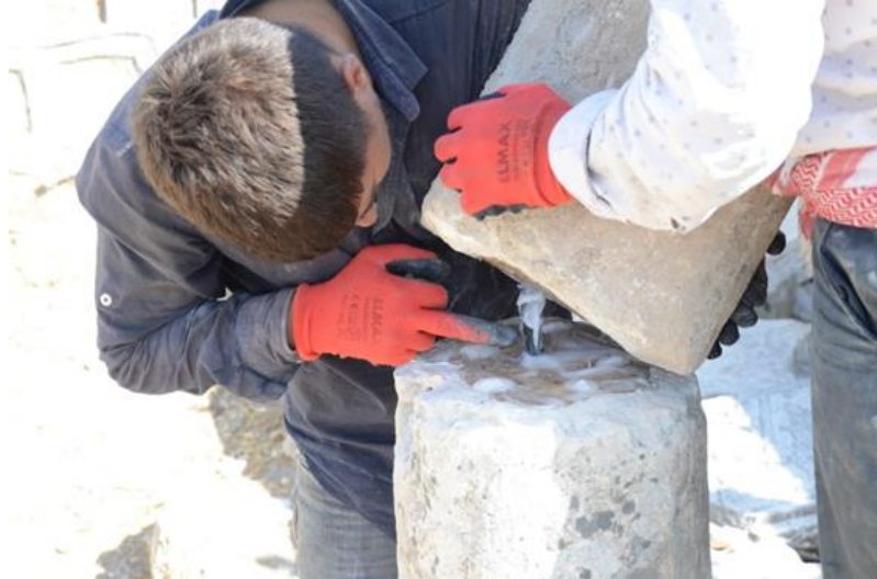
Şekil 5.30. İkiye Ayrılmış Sütun Parçalarının Birleştirilmesi
