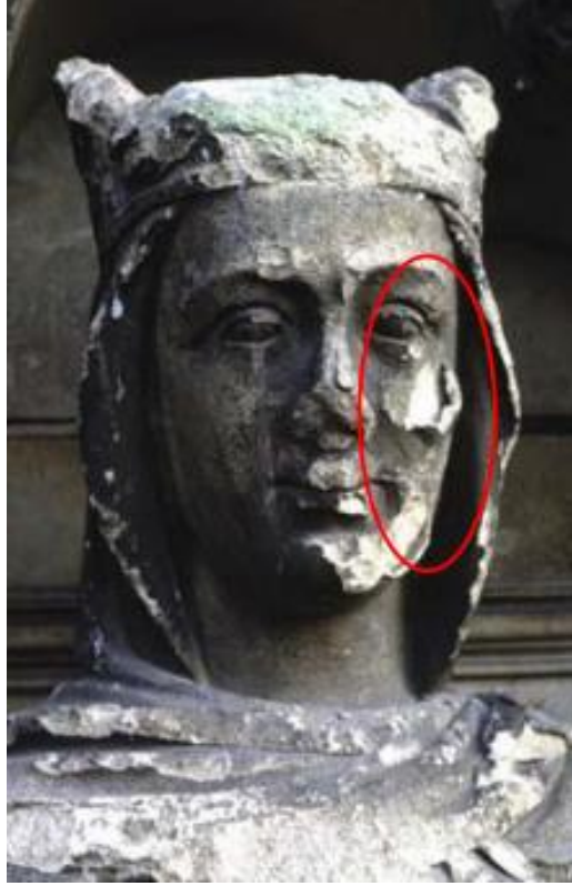
Şekil 4.12. Taşta Oluşan Kabuklanma (Hasbay ve Hattap, 2017, S. 36).
