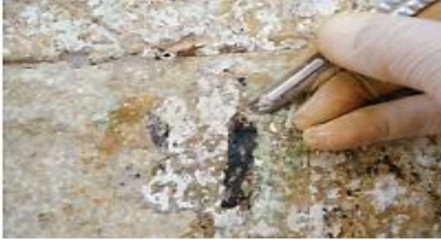
Şekil 4.18. Mekanik Temizleme Uygulaması (Ersen, 2013, S. 6).
