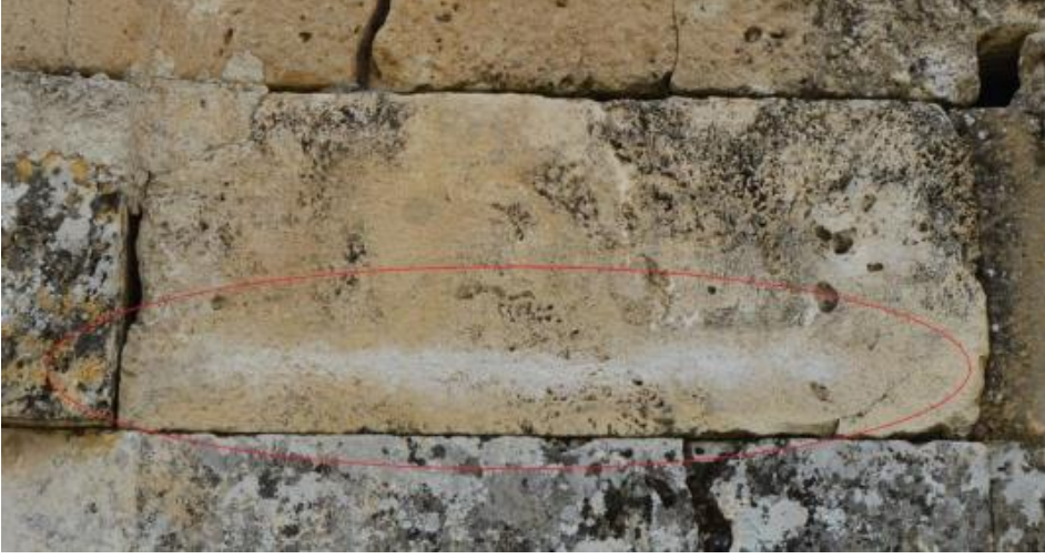
Şekil 4.8. Taş Yapıda Çiçeklenme Örneği (Erdem, 2016, S. 20)
