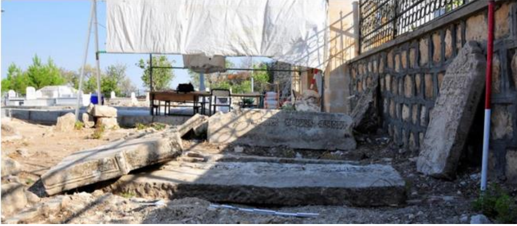
Şekil 5.50. Güney Alanı 3 Numaralı Mezar'ın Restorasyon Öncesi Genel Durumu
