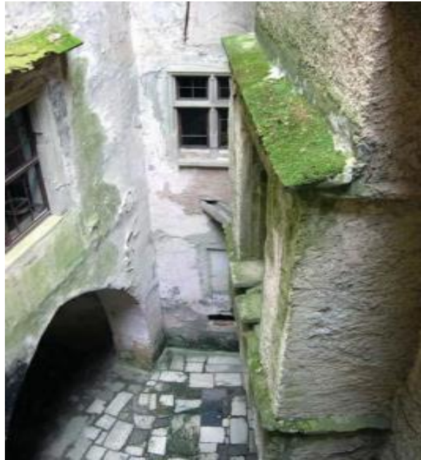
Şekil 4.14. Binaların Taş Yüzeyinde Alg Oluşumu (Hasbay ve Hattap, 2017, S. 38)
