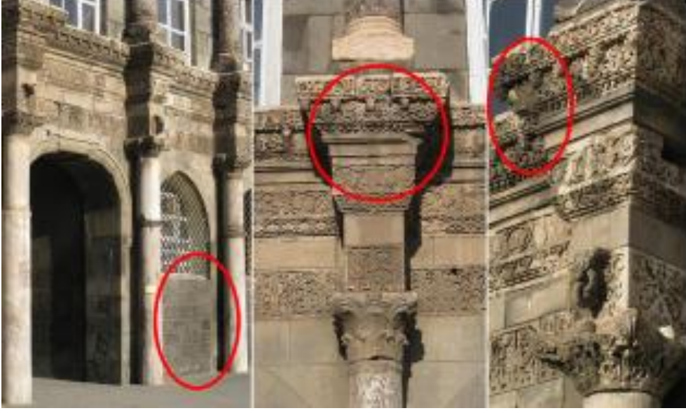
Şekil 4.6. Taş Yüzeyindeki Kararmalar (Hasbay ve Hattap, 2017, S. 32).
