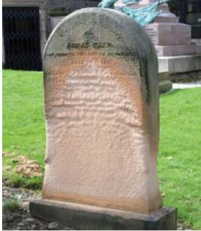
Şekil 4.11. Taşta Oluşan Tozlaşma (Hasbay Ve Hattap, 2017, S. 35).
