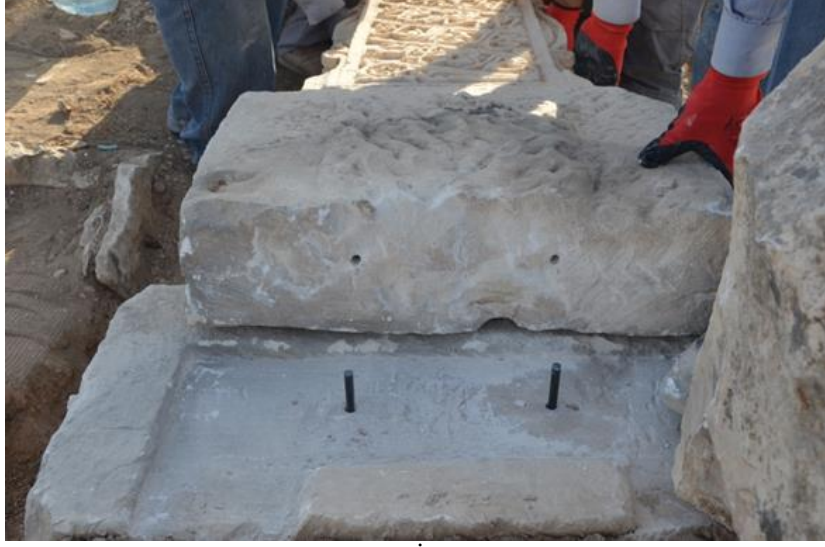
Şekil 5.27. Şahide ve Kaidenin Birleştirilmesi İçin Kullanılan Karbon Fiber Çubuk ve Epoksi
