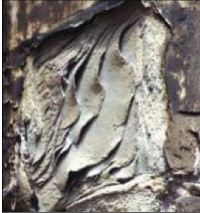
Şekil 4.9. Yapraklanma Örneği (MEB, 2013, S. 16).
