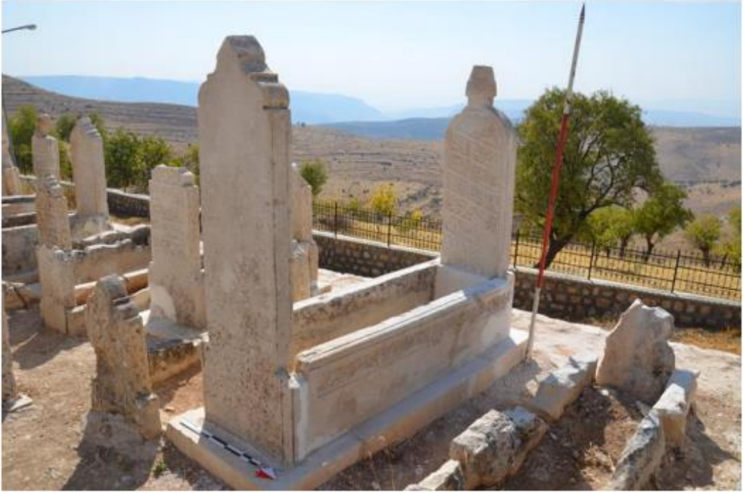
Şekil 5.47. Şeyh Ethem'in Kabri Restorasyon Sonrası Genel Durumu
