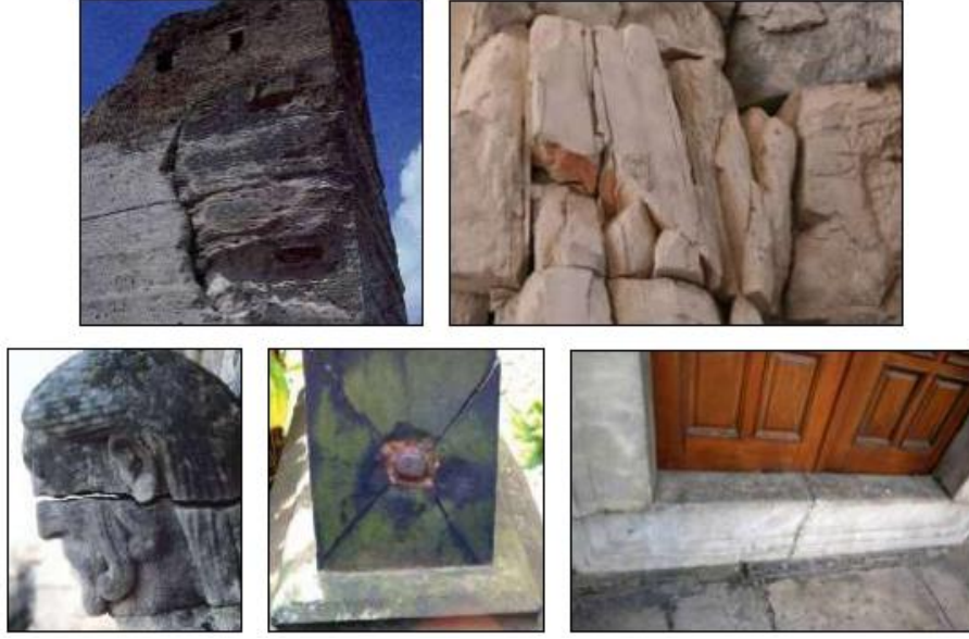
Şekil 4.1. Çeşitli Derecelerde Çatlak Oluşumları (MEB, 2013, S. 14)
