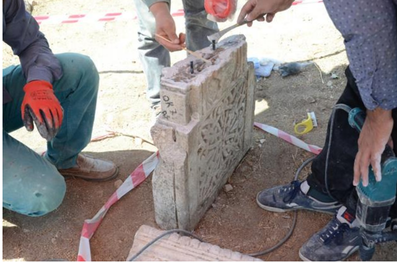
Şekil 5.21. Karbon Fiber Çubuk + Epoksi Kullanılması Uygulaması
