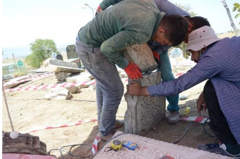
Şekil 5.22. Kopan İki Parçanın İki Taraftan Açılan Dübellere Bütünleştirilmesi
