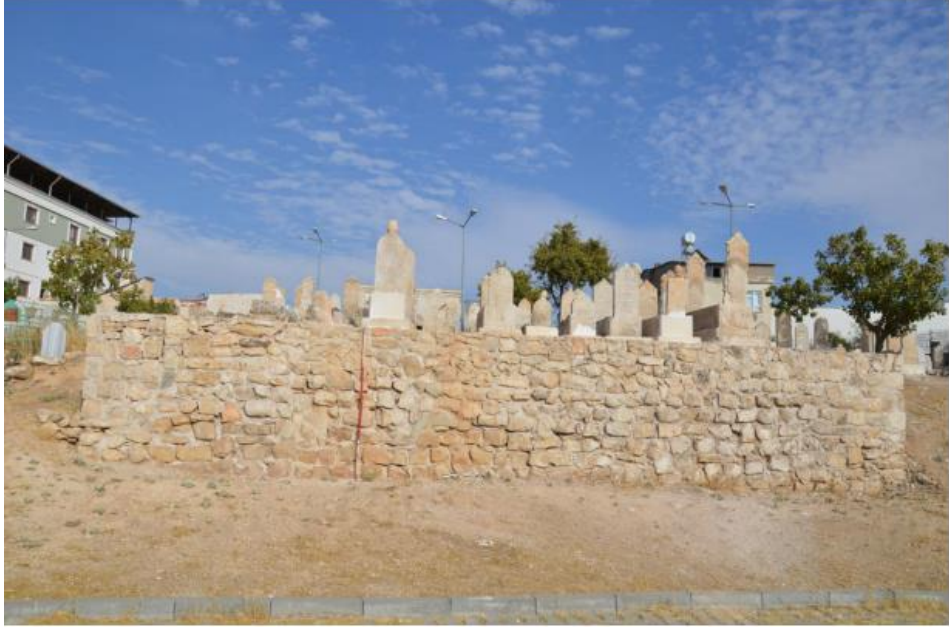
Şekil 5.14. Set Duvarının Restorasyon Öncesi-Sonrası Durumu
