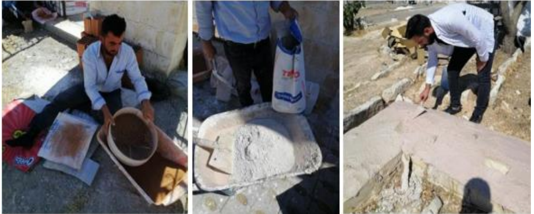
Şekil 5.13. İç Duvarların Restorasyon Uygulama Çalışmaları
