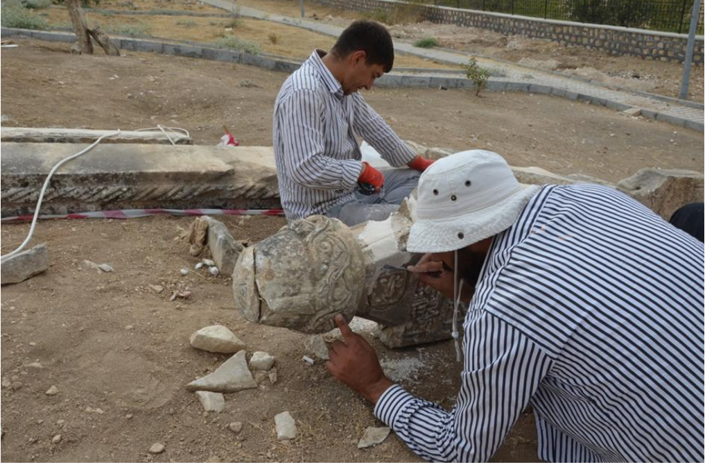
Şekil 5.38. Harç (Hidrolik Kireç + Dispersiyon K9 + Saf Su) Kullanılarak Çatlak ve Eksik Parçaların Tamamlanması
