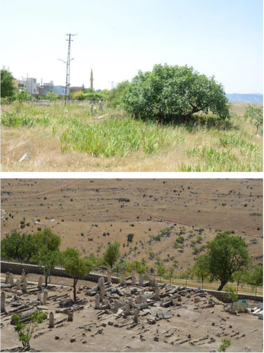
Şekil 5.11. Kazık Köklü Bitkilerin ve Muhdes Yapıların Temizliği Öncesi-Sonrası Durumu
