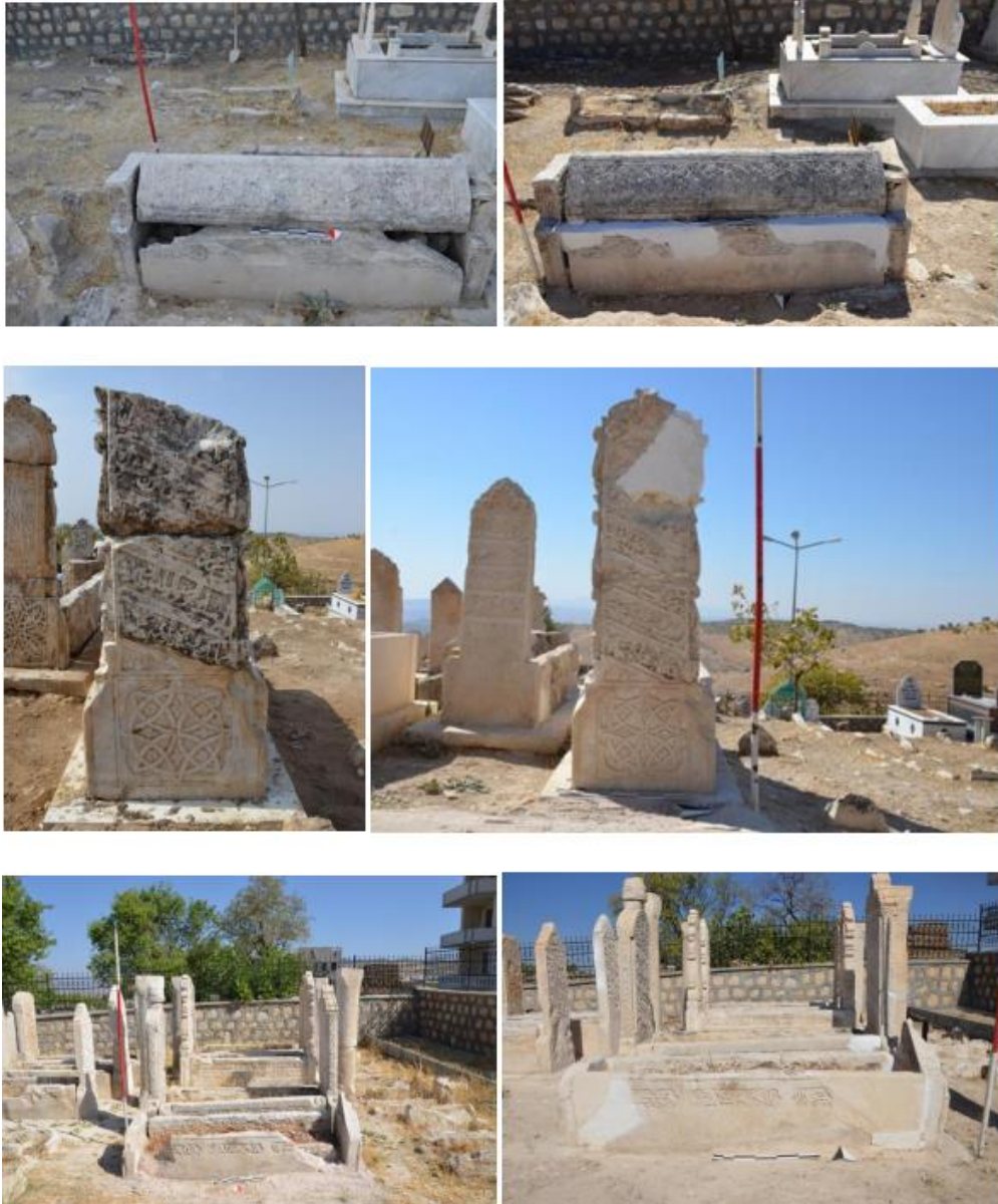
Şekil 5.40. Mezar Taşlarına Harç Kullanılarak Dolgu Yapılması İşlemi, Restorasyon Öncesi-Sonrası
