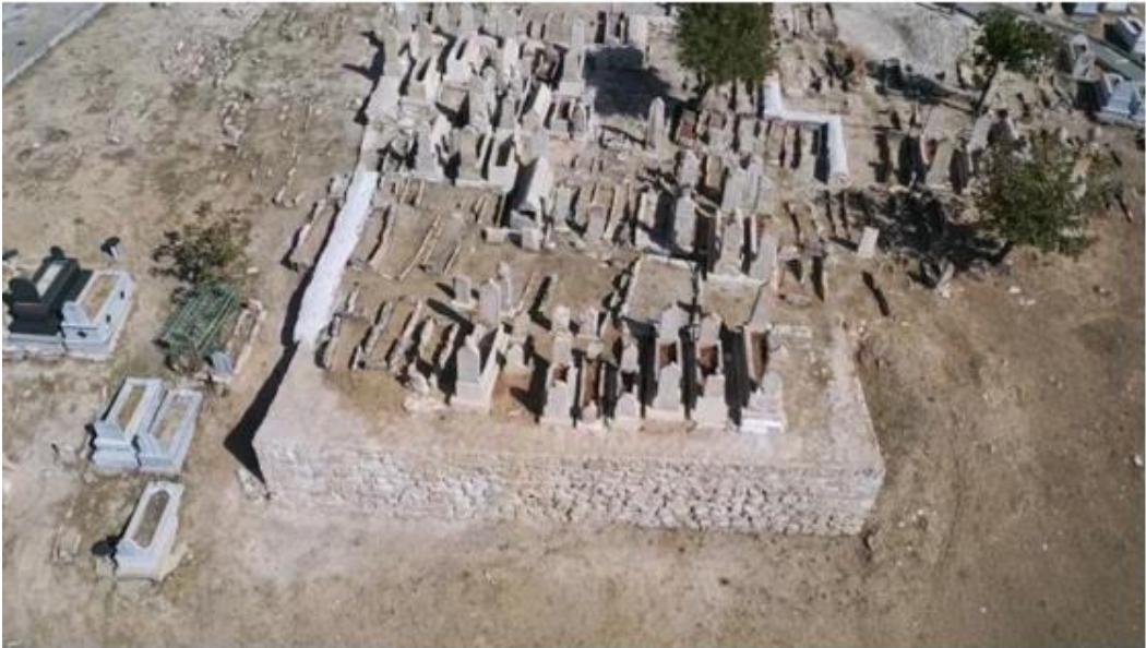
Tillo Tarihi Mezarlık Alanı Set Duvarı Restorasyon Öncesi-Sonrası Görünüm
