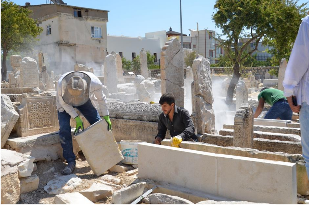
Şekil 5.39. Mezarların Eksik Olan Yan, Baş ve Ayak Taşlarının Mezar Yapısına Uygun Kireç Taşıyla Tümlenmesi
