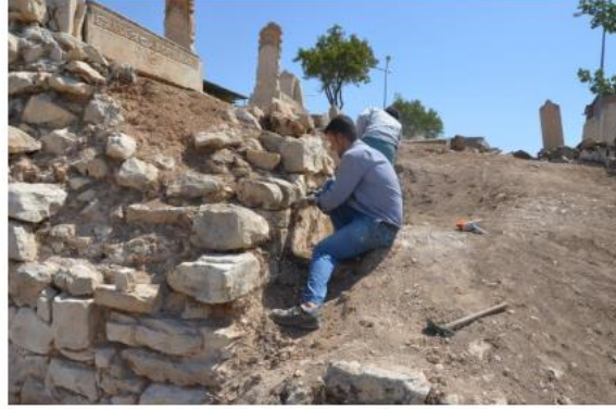
Şekil 5.12. Set Duvarının Onarılması
