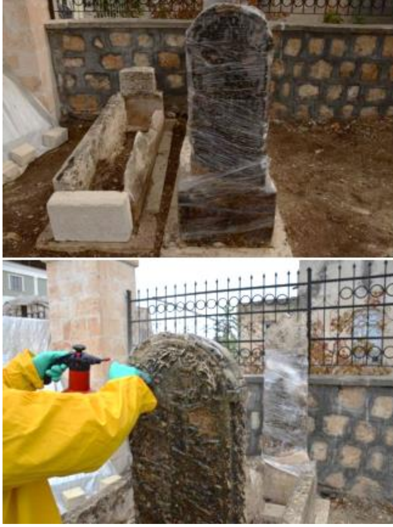
Şekil 5.33. Streçle Sarılan Şahidenin Bekleme Sonrası Distile Su İle Arındırılması
