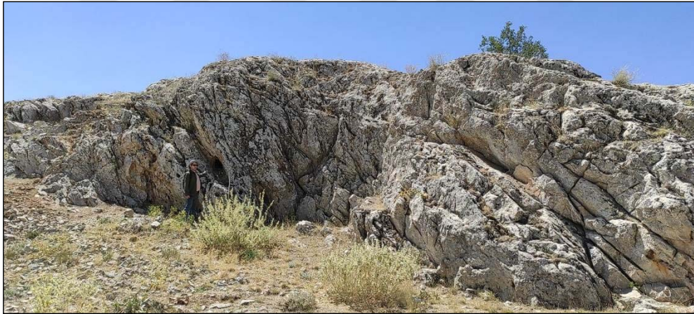
Şekil 3.2.1.4:Uzunçal Tepe kuzeydoğusunda Lorasdağı kireçtaşlarında gelişen yoğun diyagonal çatlaklardan bir görünüş
