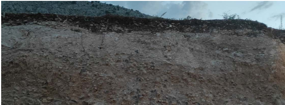
Şekil 2.5.3: Abaz Dağı kuzey eteğinde Seçme Köyü kum ocağında yamaç molozunun görüntüsü.
