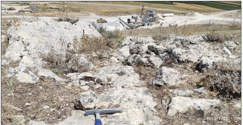
Şekil 3.3.2.1.f: Obruk Tepe taş ocağının güneybatısından Timraş Obruğu'na doğru uzanan K10°D, 45°GD konumlu bir kırık yüzeyinin görünüşü
