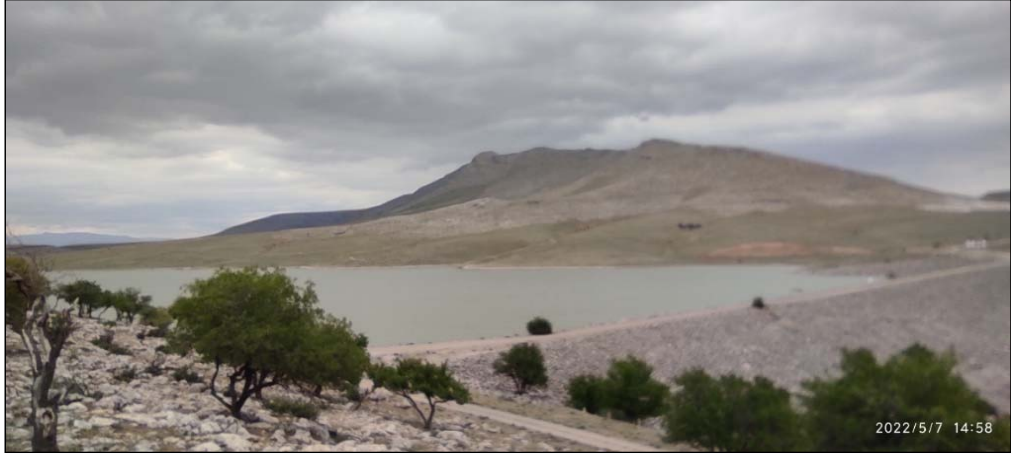
Şekil 5.3.e : May barajı göletinin dolu hali (07.05.2022)
