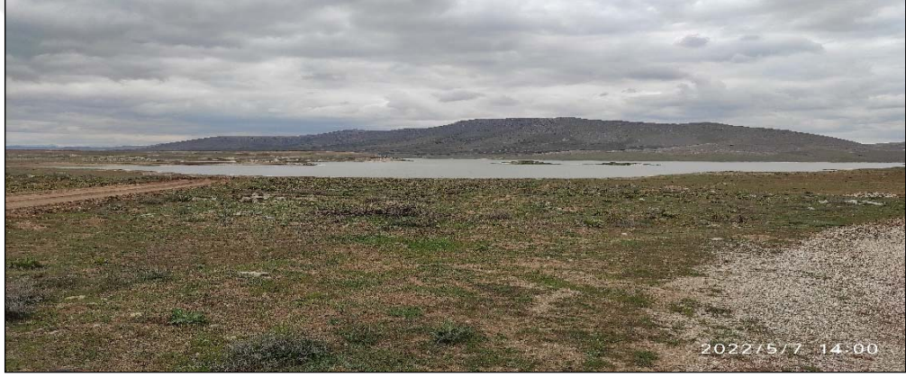
Şekil 5.3.f: Yağışlarla dolan May barajı göletine, Ahmediye Köyünden bir bakış
