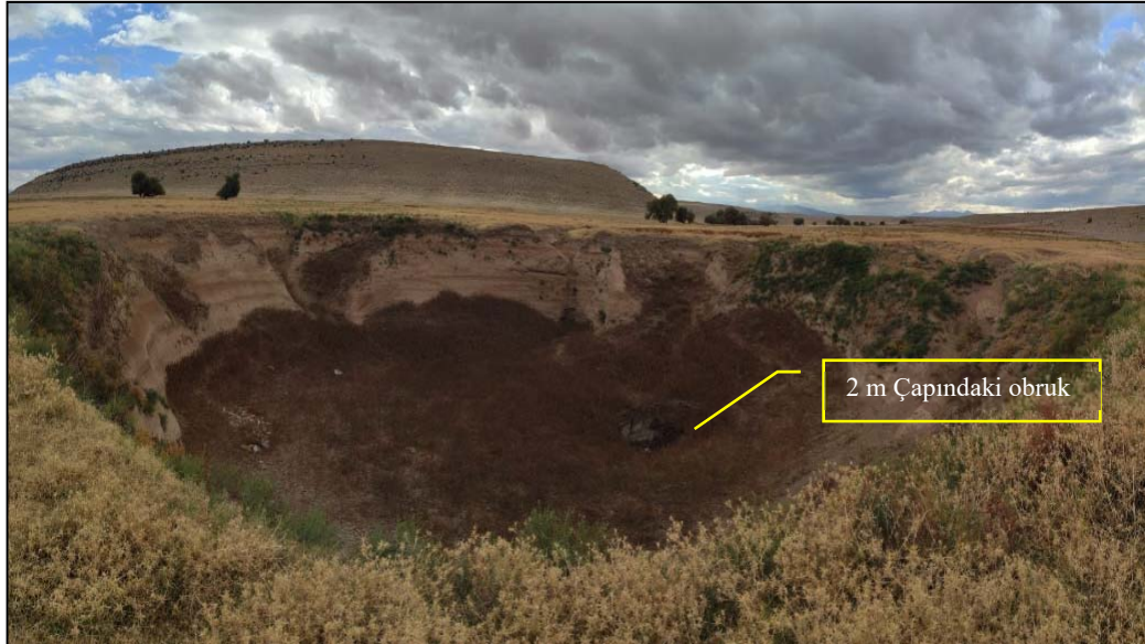
Şekil 5.3.a: May barajı obruğu panoramik görünümü (07.05.2022)
