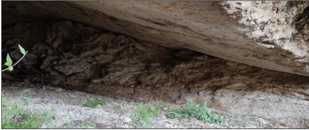
Şekil 3.3.2.6.a: Apasaraycık obruğunda Sille formasyonu içindeki kiltaların su ile taşınmasıyla oluşmuş küçük bir boşluk
