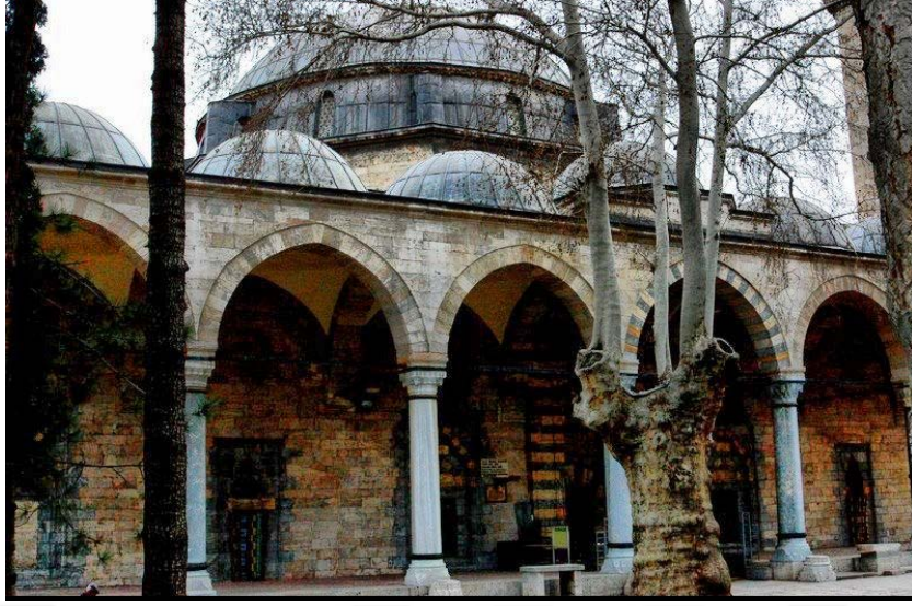
Şekil 5.4. Restorasyon öncesi ön cephe (Erkara, 2010)
