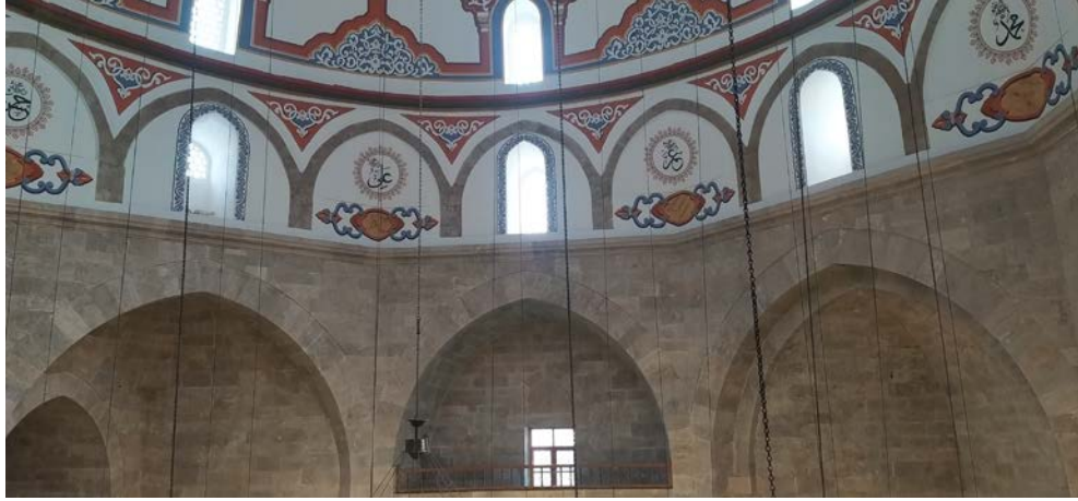
Şekil 4.21. Caminin kasnağı, eteği ve tromplar
