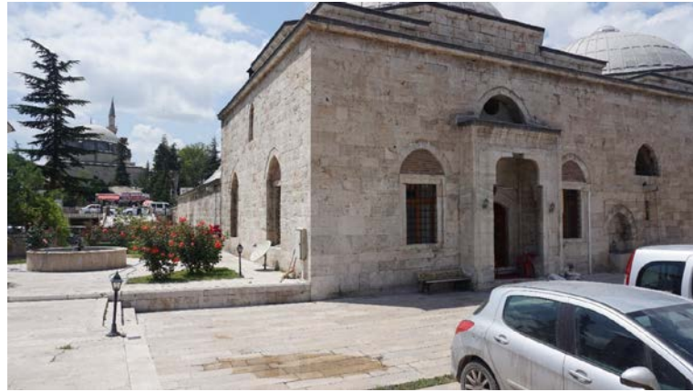
Şekil 4.77. Güneydoğu cephesi ve avlu
