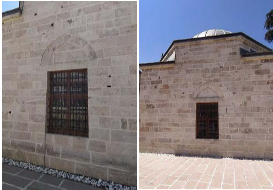
Şekil 4.41. Kuzey ve doğu cephesinde pencereler
