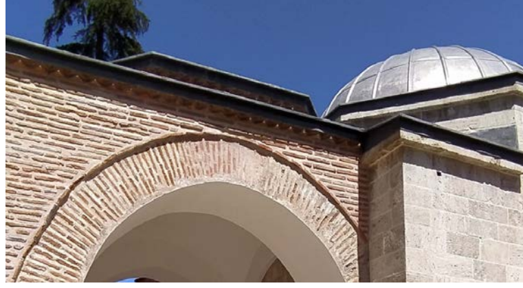
Şekil 5.12. Restorasyon sonrası baldaken sundurma kısmı
