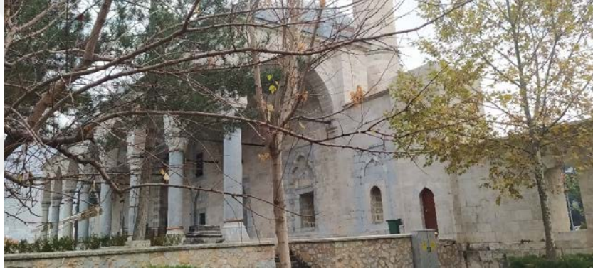
Şekil 5.5. Mikro kumlama ile temizlenmiş dış cephe
