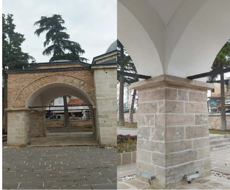
Şekil 4.38. Baldaken kısmı sundurma ve kubbeye geçiş elemanı
