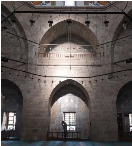
Şekil 4.12. Batı cephesinde harimde yer alan nişler ve kadınlar mahfili
