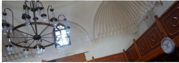
Şekil 4.52. Tromplar ve asma kat
