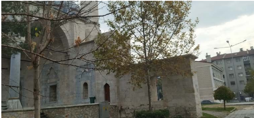
Şekil 4.28. Batı cephesindeki üç parçalı taşan kısım
