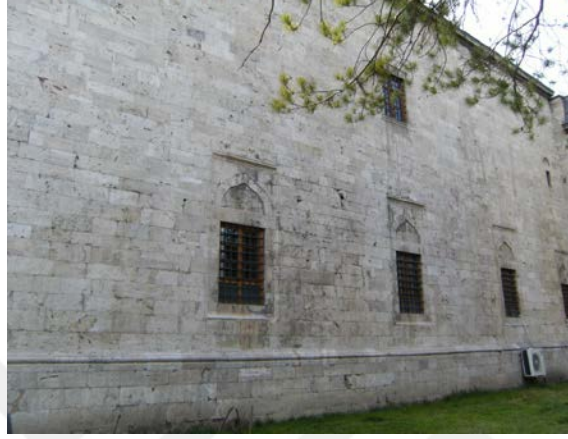
Şekil 4.27. Dođu Cephesi (Erkara, 2010)
