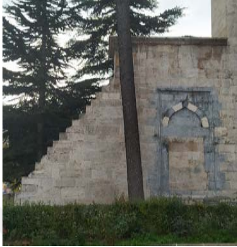
Şekil 4.29. Son cemaat mahalinin doğu cephesindeki taşan kısımları
