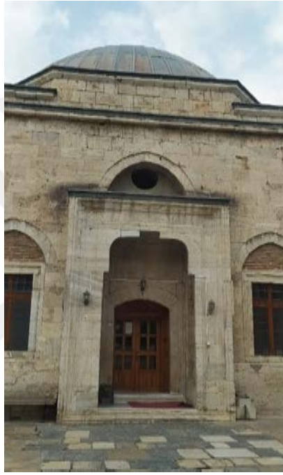
Şekil 4.51. Erkekler bölümü girişi ve rüzgarlıktaki nişler
