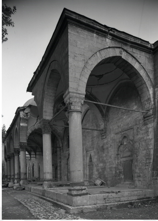
Şekil 5.1. 1939 ve 1943 sonrası yıkılan son cemaat mahali (VGM Arşivi)
