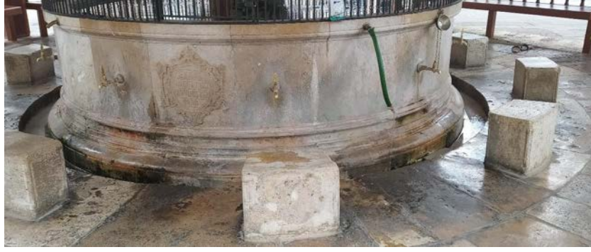
Şekil 4.33. Şadırvan havuz kısmı ve oturma yerleri
