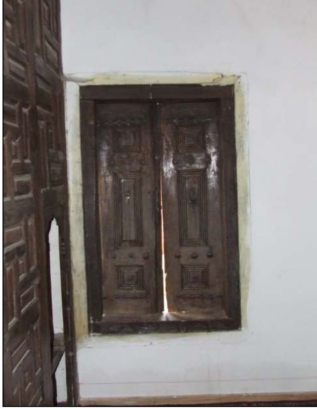
Resim 4.28. Güney Cephesindeki Ahşap Pencere Kapakları
