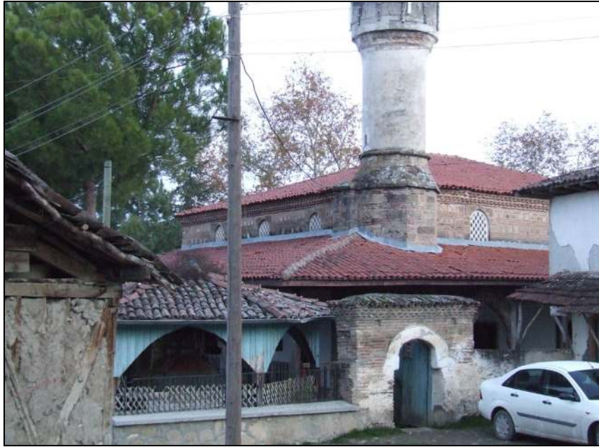
Resim 4.46. İmam Evinin Batıdaki Giriş Kapısı ile İlişkisi
