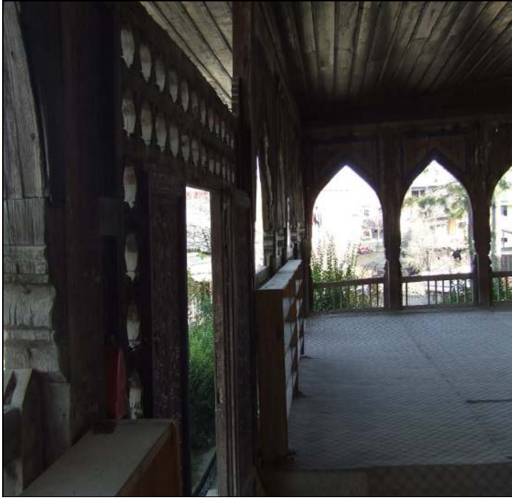
Resim 4.17. Kuzey Cephe Sivri Kemer ve Giriş Kapısı İç Görünüşü
