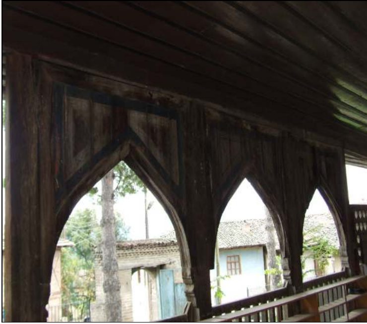
Resim 4.19. Kuzey Cephesi Sivri Kemer İç Görünüşü
