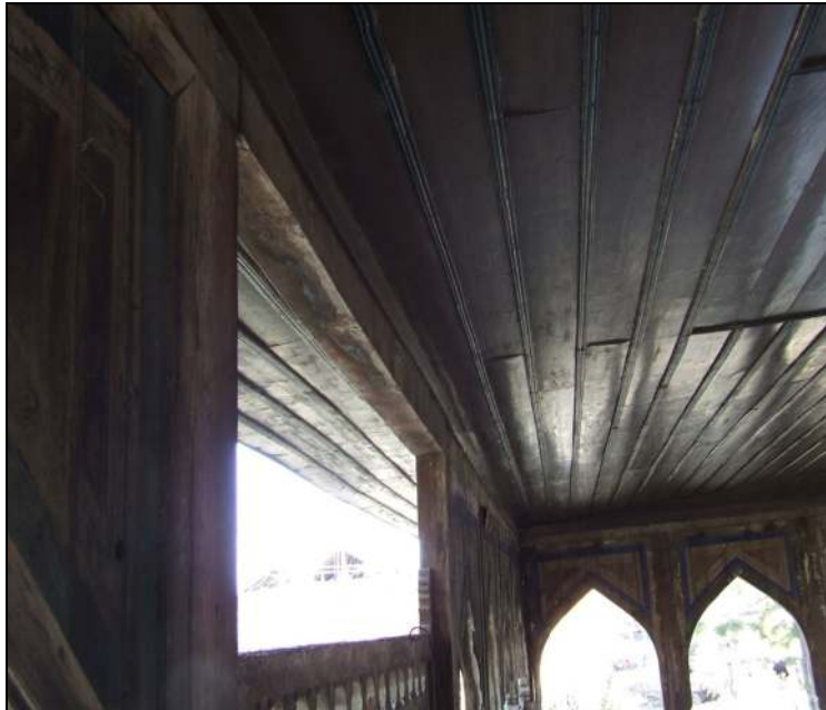
Resim 4.16. Kuzey Cephe Sivri Kemer ve Giriş Kapısı Görünüşü
