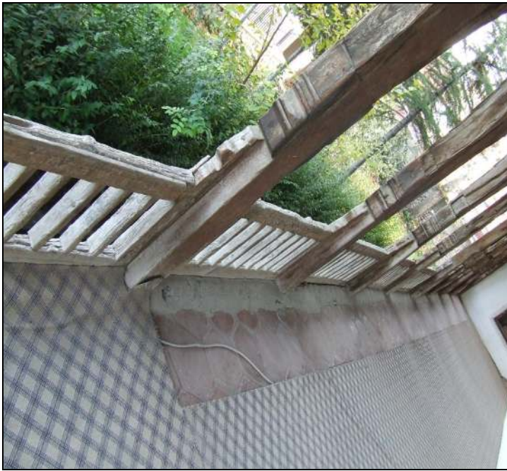
Resim 4.18. Doğu Cephe Sivri Kemer Taban Döşemesi
