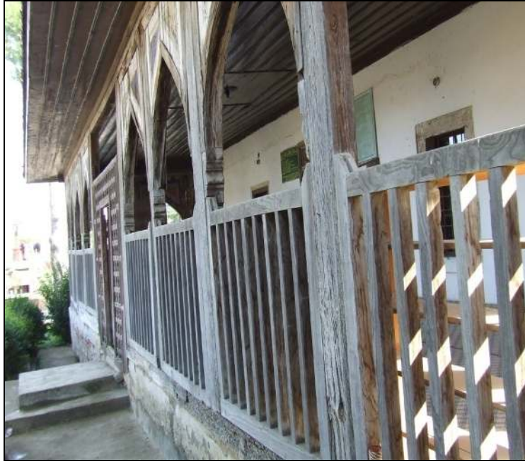
Resim 4.15. Kuzey Cephe Sivri Kemer ve Giriş Kapısı Görünüşü
