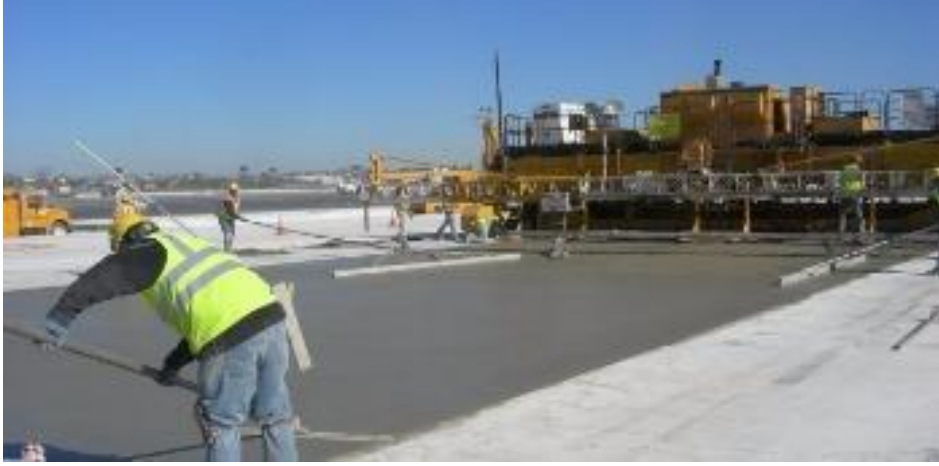
Şekil 2.11. Havalimanı pist ve taksi yolu beton kaplama uygulaması (www.ccaa.com.au,2024)
