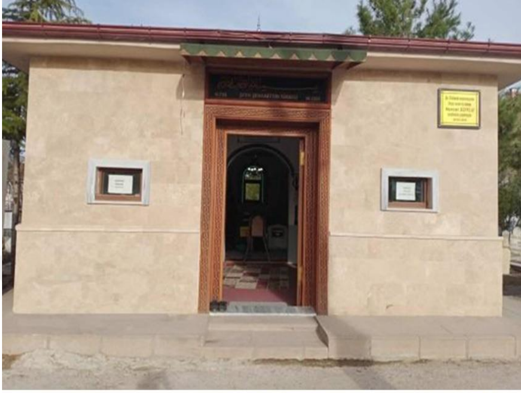
Fotoğraf 2. 48: Şeyh Şehabettin Türbesi (İç ve Dış Görünüş)
