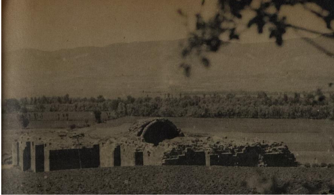
Fotoğraf 3.4: 20.Yüzyılda Mahperi Hatun Kervansarayının Güney Cephesinden Görünümü
