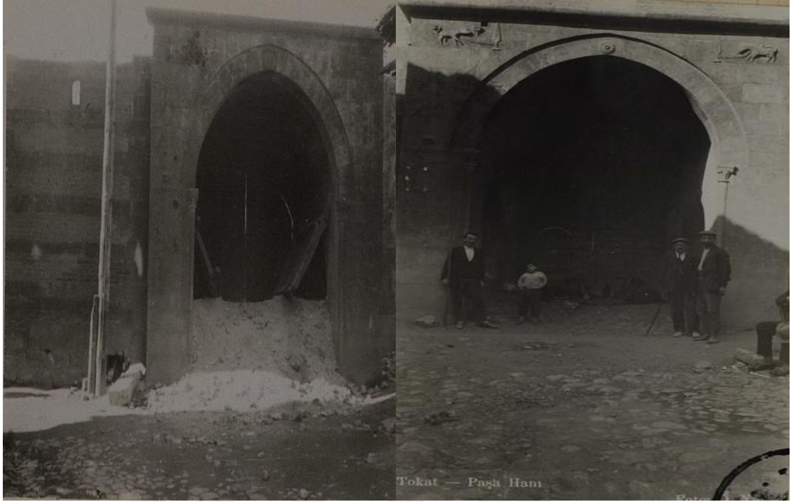
Fotoğraf 3.13: 20. yüzyılda Paşa Hanı'nın Giriş Bölümünden Bir Görünüm
