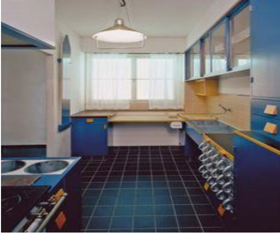
a) Frankfurt Mutfak mekanı
