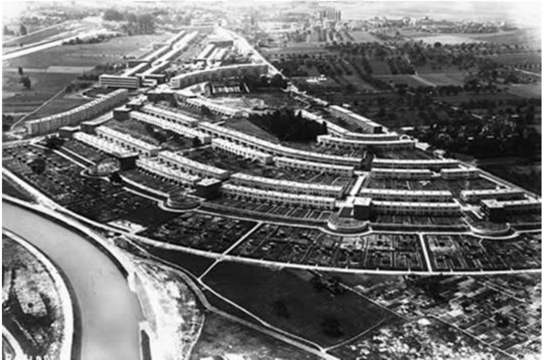
Şekil 2.14 Römerstadt yerleşiminin havadan görünümü
