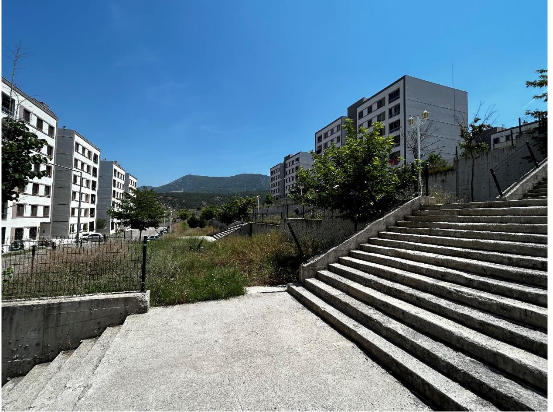
Şekil 3.20 Uygulama sonrası, eğimin istinat duvarları ile kotlandırılması (Kişisel arşiv, 2023)
