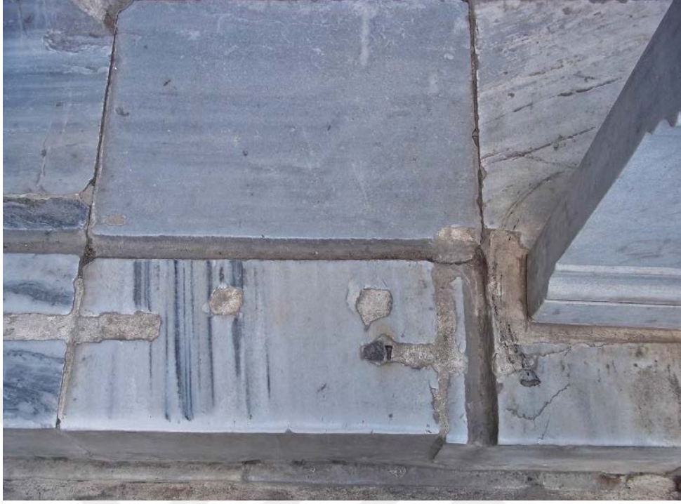
Resim 21: Revaklı Alanda Bir Dönem Bulunan Doğrama Çerçevelerin Kapı Eşiği İzleri (Serhan Şalk, 18.06.2019)
