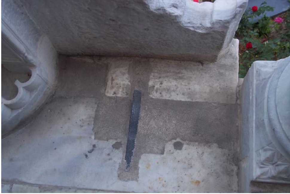
Resim 22: Revaklı Alanda Bulunan Doğrama Çerçevelerin Zemine Bağlandığı Demirler (Serhan Şalk,18.06.2019)
