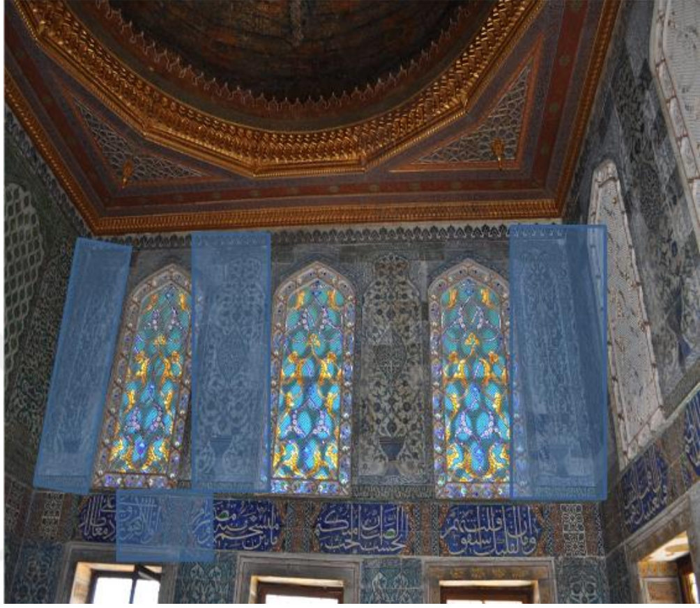
Resim 164. Veliaht Dairesi Duvar 3
