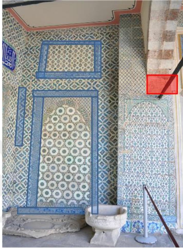
Resim 70. Valide Taşlığı Giriş Duvar 2
