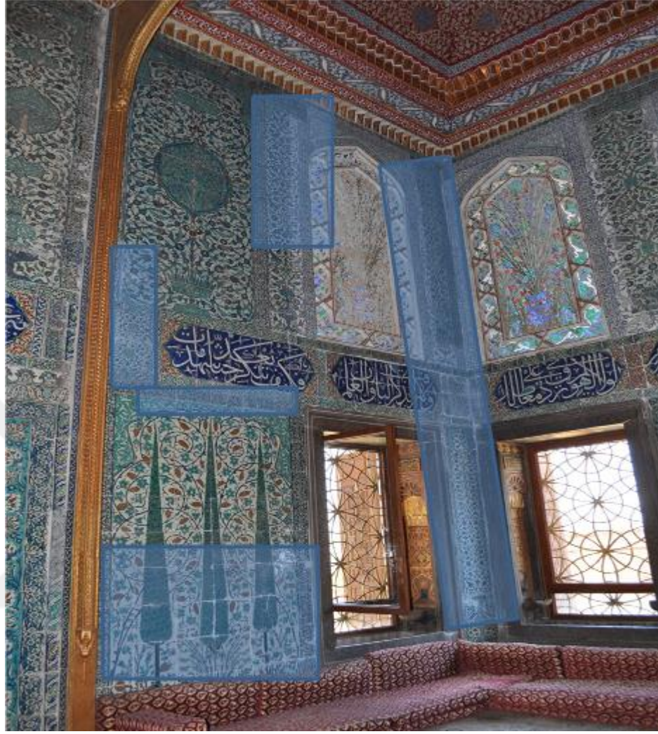
Resim 178. Veliht Dairesi 2.Oda Duvar 3
