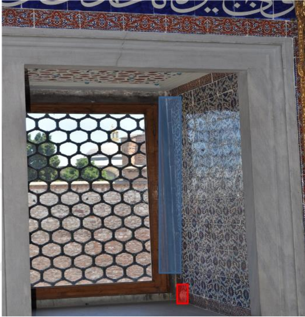
Resim 142. 3. Murad Has Odası Duvar 4
