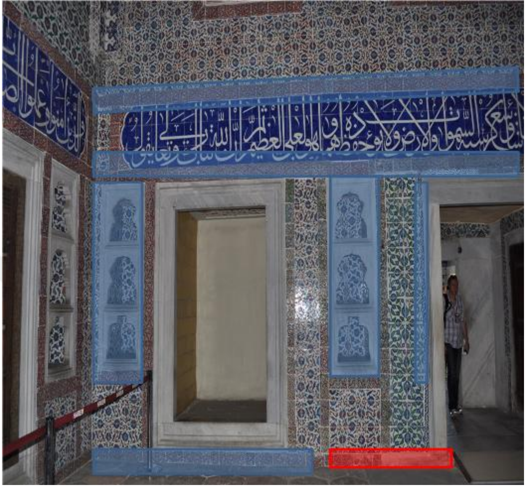
Resim 134. 3. Murad Has Odası Duvar 3
