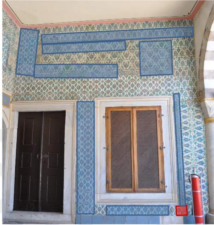
Resim 65. Valide Taşlığı Giriş Duvar 1
