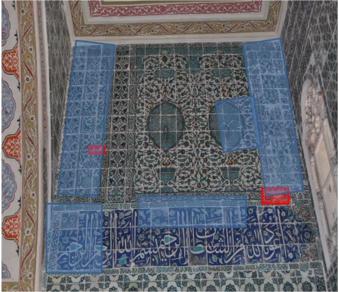
Resim 85. Saltanat Kapısı (Cümle Kapısı) Duvar 3
