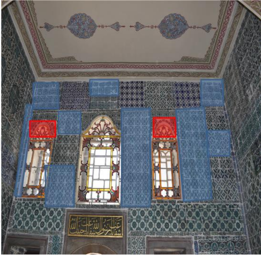
Resim 78. Saltanat Kapısı (Cümle Kapısı) Duvar 1
