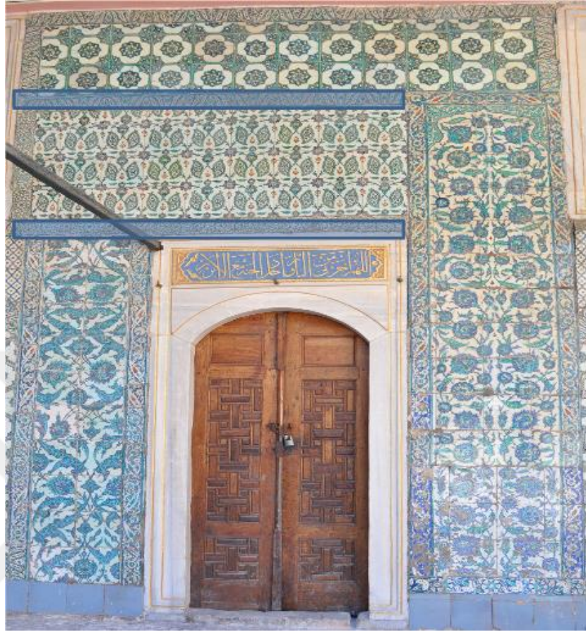
Resim 68. Valide Taşlığı Giriş Duvar 2
