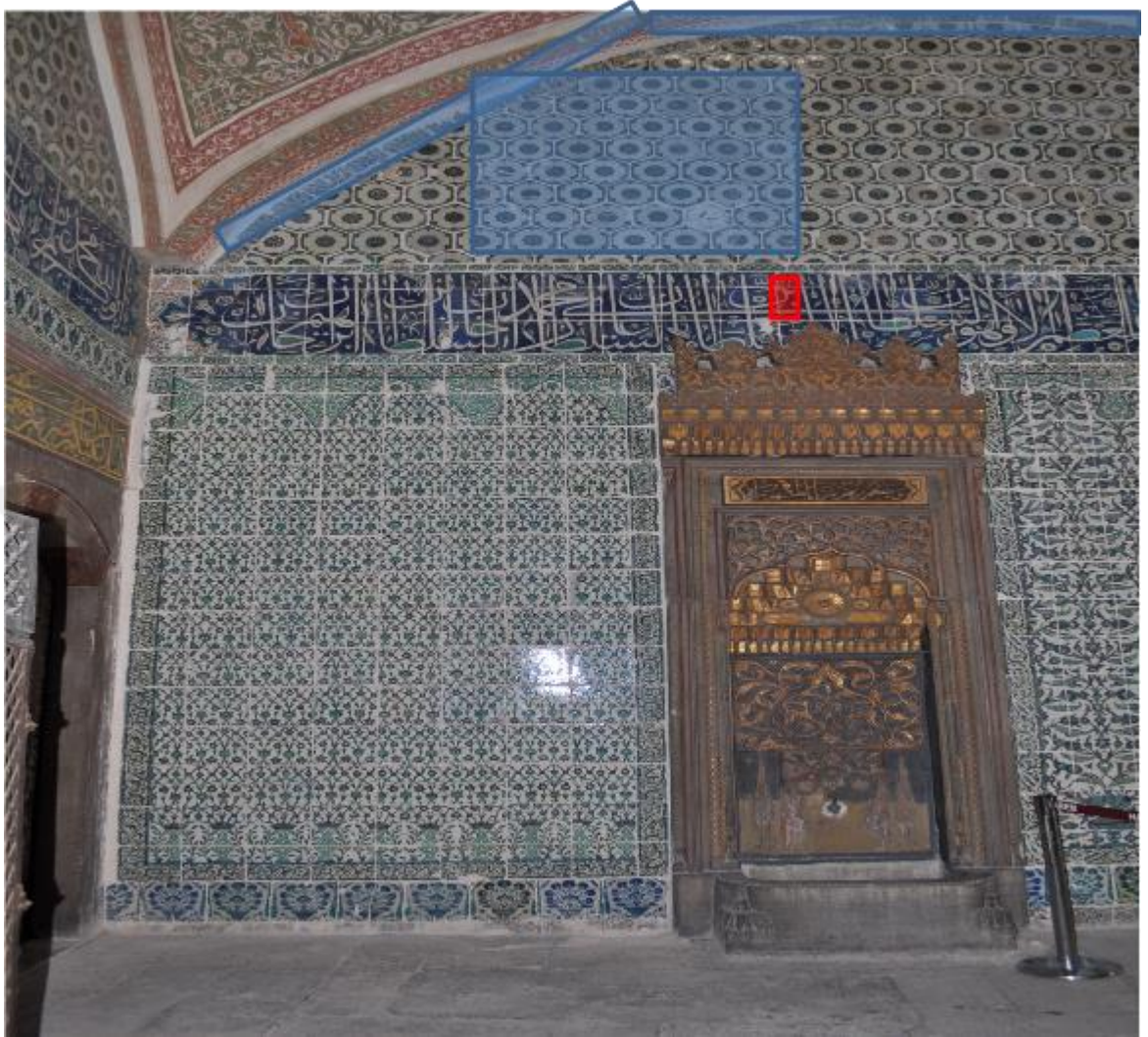
Resim 88. Saltanat Kapısı (Cümle Kapısı) Duvar 3
