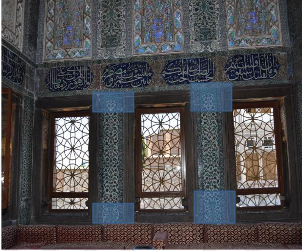
Resim 175. Veliyat Dairesi 2.Oda Duvar 2
