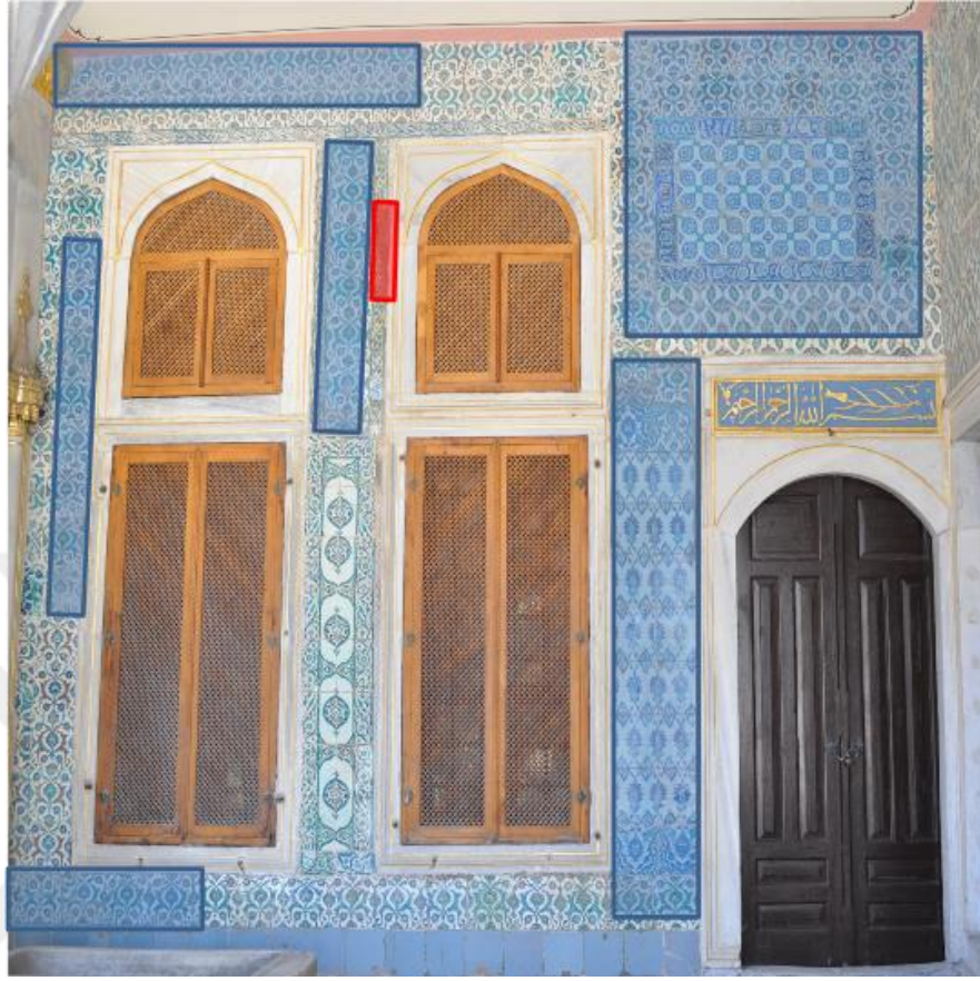
Resim 66. Valide Taşlığı Giriş Duvar 2
