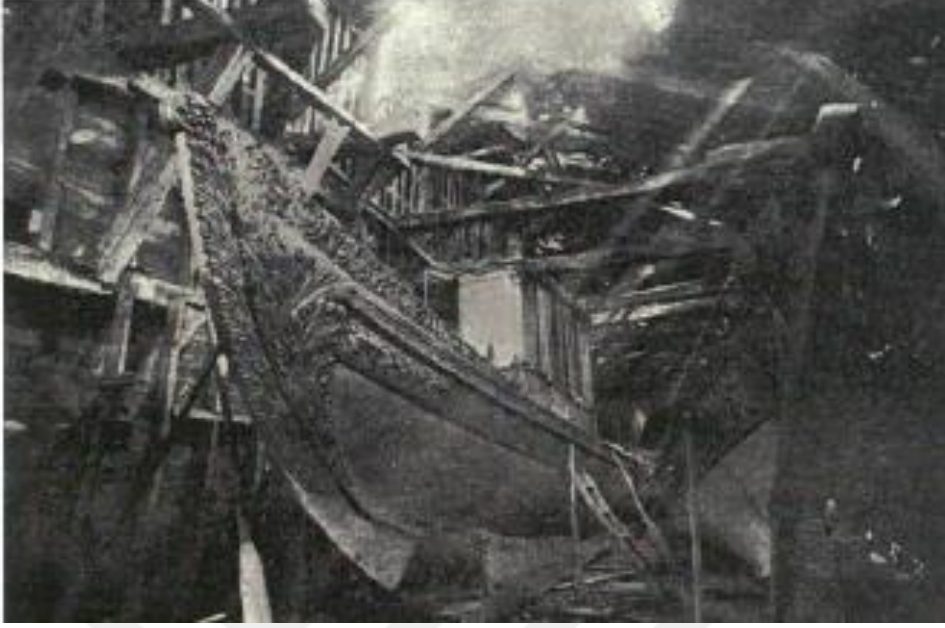
EK 17: Kayıkhanenin yıkımı esnasında çekilmiş fotoğrafı ( Burak Çetintaş, Denizci Mezar Taşları, s.81.)
