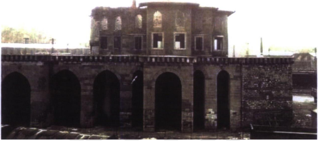
Şekil.64: 1960 Restorasyon Çalıřmaları Esnasında Sepetçiler Kaskı'nın sonradan eklenen yapı gruplarından arındırılmış halini gösterir fotoğrafı (IV Numaralı Kùltür ve Tabiat Varlıkları Koruma Kurulu Arşivi)
