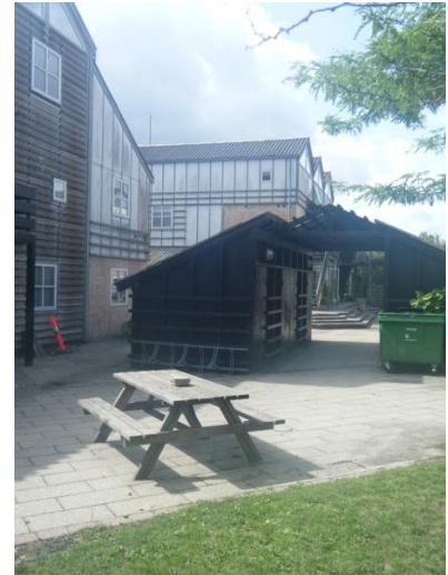
Şekil 4.132: Ortak kullanım alanı ve çöp deposu (Mangut, 2014)
