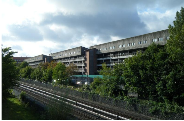
Şekil 4.135: Tren yolu ve çok katlı çeper blok (Mangut, 2014)
