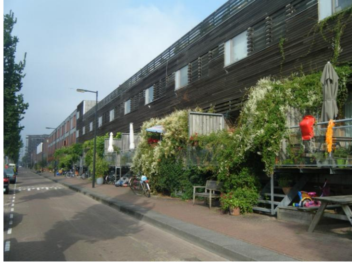
Şekil 4.86: Zemin katların uzantısı olarak kullanılan kaldırımlar (Mangut, 2014)
