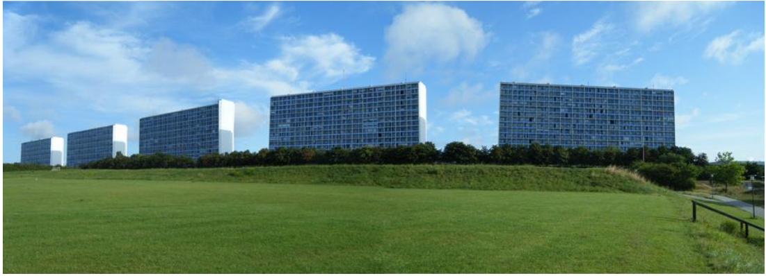
Şekil 4.184: Yerleşimin genel karakterini oluşturan çok katlı koridorlu bloklar (Mangut, 2014)
