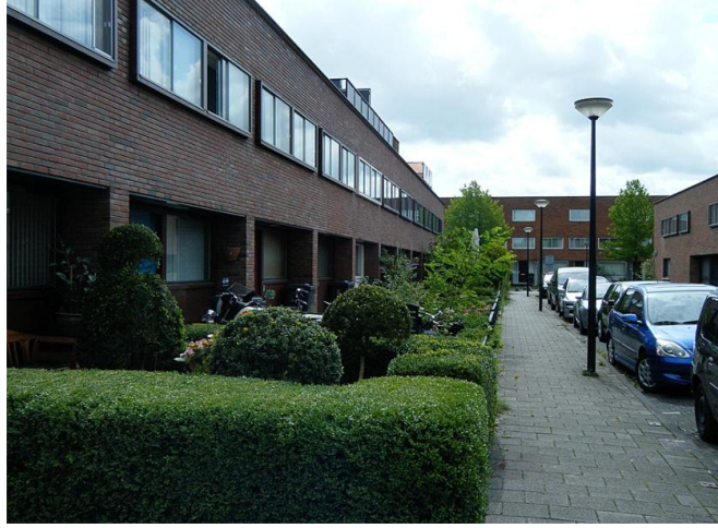
Şekil 4.102: Yerleşimin doğusunda yer alan, yenileme sonrası inşa edilen az katlı sıra konutlar; özel bahçeler-kaldırım ilişkisi (Mangut, 2014)
