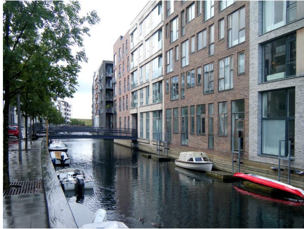
Şekil 4.157: Kanal cephelerinde yer alan pontonlar (Mangut, 2014)
