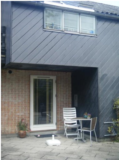
Şekil 4.128: Yapı girişleri (Mangut, 2014)
