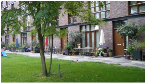
Şekil 4.25: Kullanıcılara ait kişisel eşyalar ve döşeme malzemesindeki farklılıklar (Mangut, 2014)
