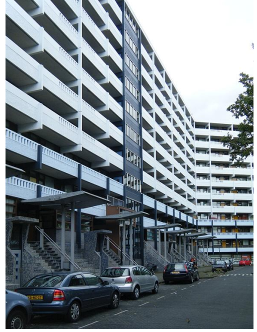
Şekil 4.101: Yapı-açık alan ilişkisini kesintiye uğratan yükseltilmiş yapı girişleri ve araç parkları (Mangut, 2014)
