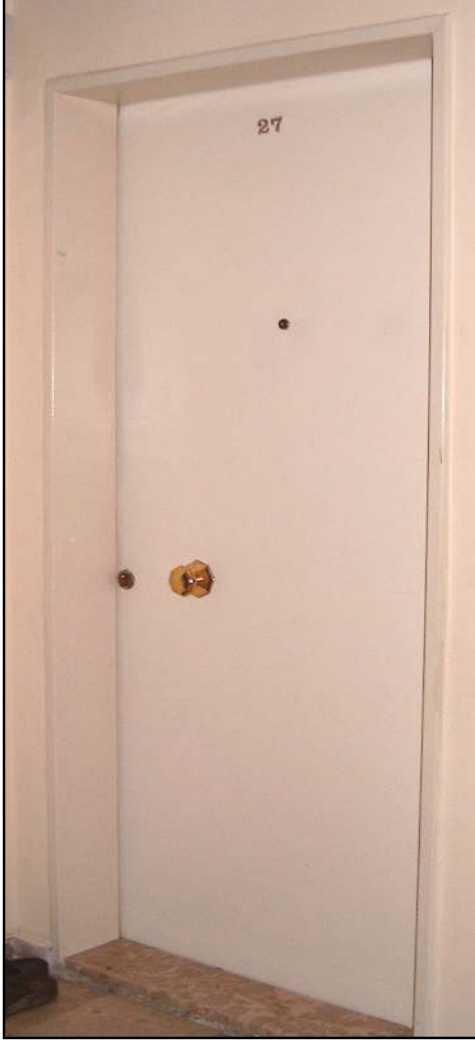
Resim 7.1. Deęişiklik yapılmadan önceki dış kapı örneęi
