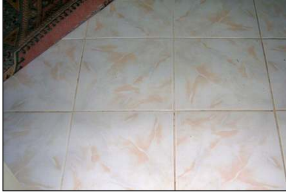
Resim 7.18. Antre, mutfak ve ıslak hacimlerde kullanılan seramik yer döşemesi
