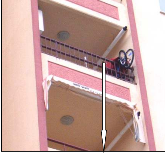
Resim 7.13. Yükseltelen balkon korkuluk örneği
