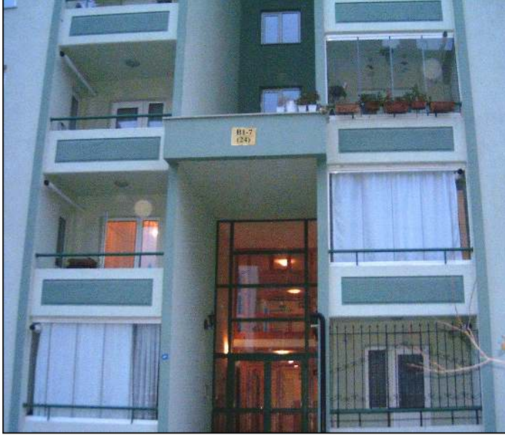
Resim 7.15. Isı yalıtımı ve mekan kazancı amacıyla balkonu kapatılan ve güvenlik nedeniyle pencerelerinde demir korkuluk olan konut örneği
