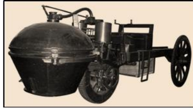
Şekil 2.3 Cugnot’un buharlı aracı (Brain, 2011)
