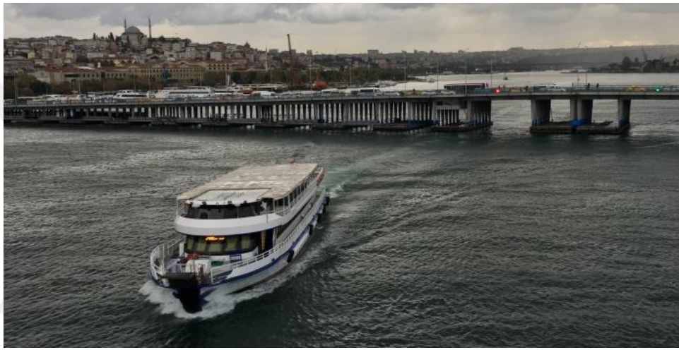
Şekil 2.9. Denizyolu toplu taşıma, Haliç, İstanbul
