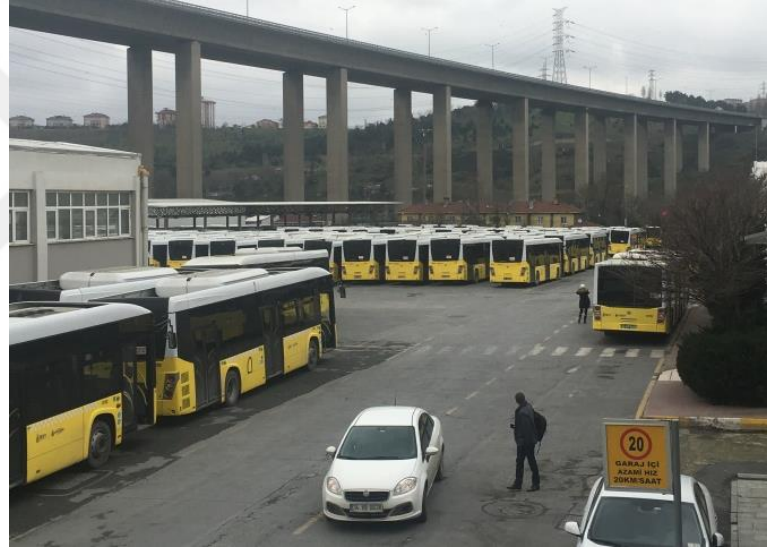
Şekil 2.16. İETT Kağıthane Garajı
