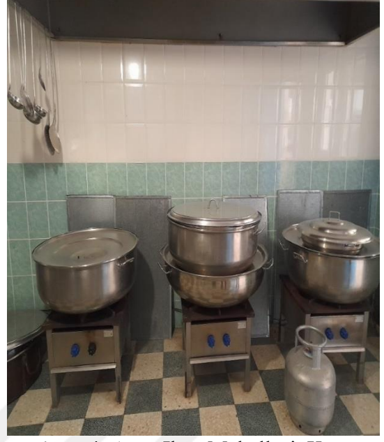
Resim 4.4: Ayaş Ilıca Mahallesi, Köy konağı mutfağında bulunan kazanlar
