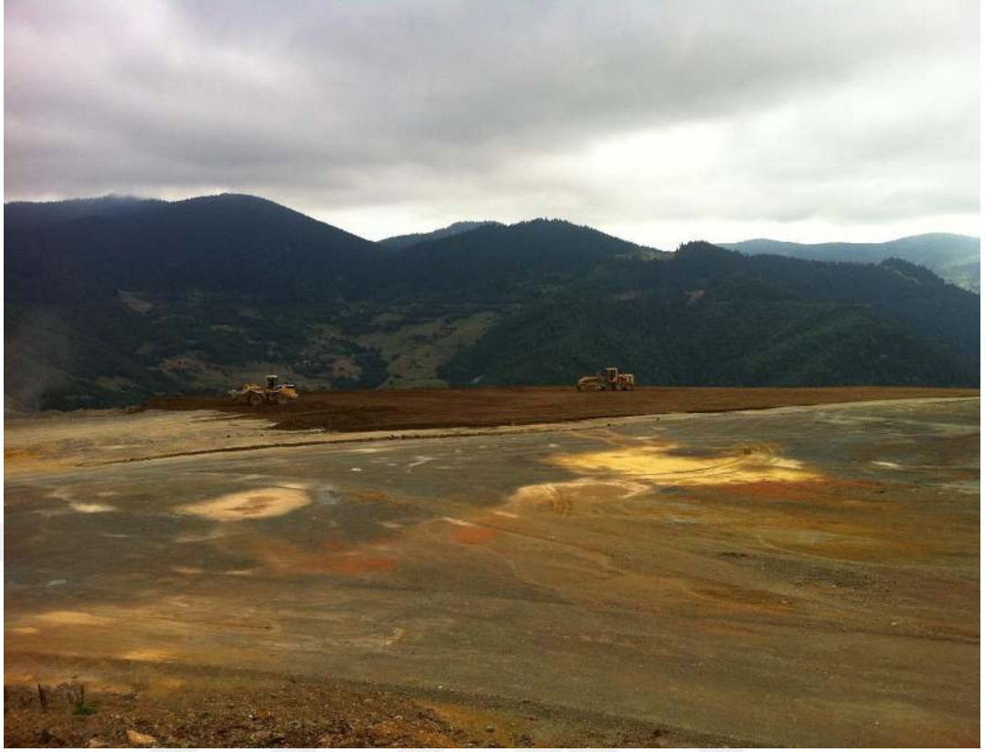
Şekil 2.5 Sahada düz ve hafif eğimli arazilerde bitkisel toprak serimi
