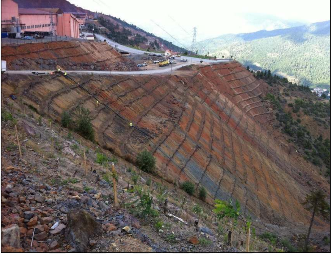
Şekil 2.6 Sahada eğimli arazilerde seki teras uygulaması ve toprak serimi
