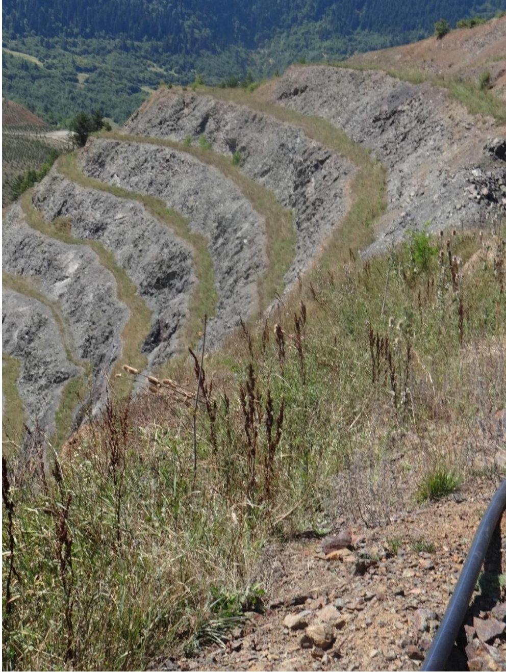
Şekil 2.7 Sahada çok eğimli arazilerde cascade sistemi ve toprak serimi
