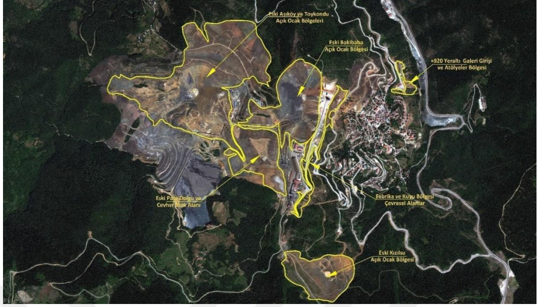
Şekil 2.3 ETİ Bakır A.Ş. Küre işletmesinin reklamasyon ve rekültivasyon bölgeleri
