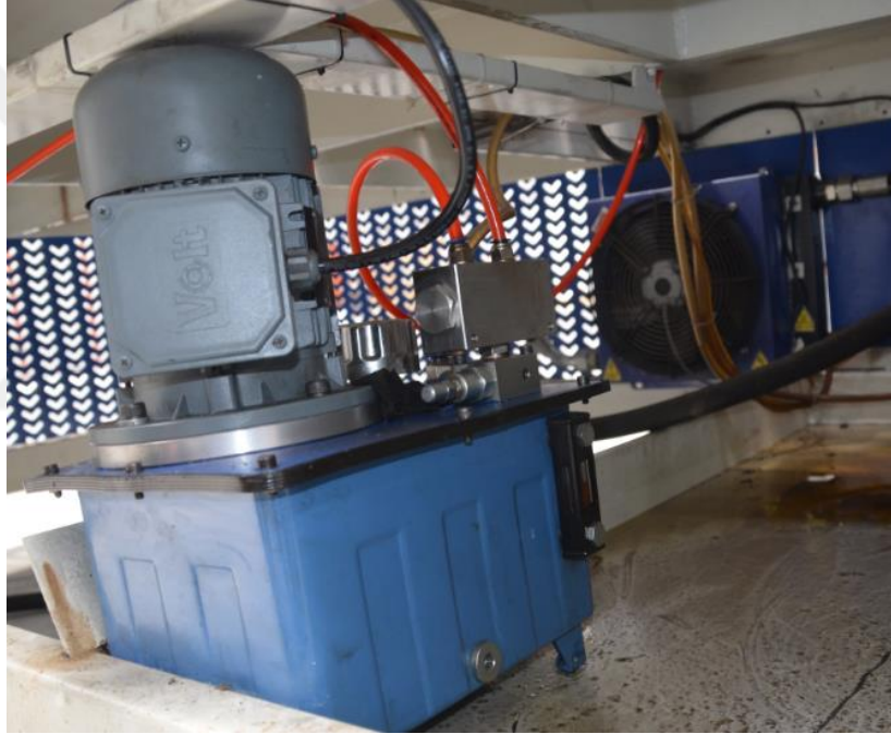
Şekil 3.22 Fanlı radyatör soğutma sistemi.
