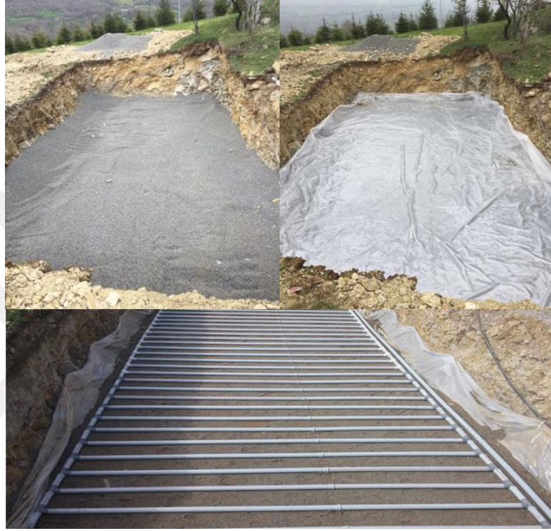
Şekil 4.2. Yeraltı boru tesisatı ve yapay gölet resmi (Durmaz ve Özdemir 2018).
