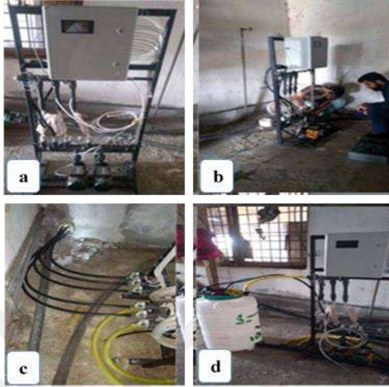
Şekil 3.5. Sulama sisteminin kurulması: a. Sulama kontrol panelinin kurulması, b. Selenoid vanaların yerleştirilmesi, c. Sulama çıkışlarının yerleştirilmesi d. Karıştırıcı tankının yerleştirilmesi,
