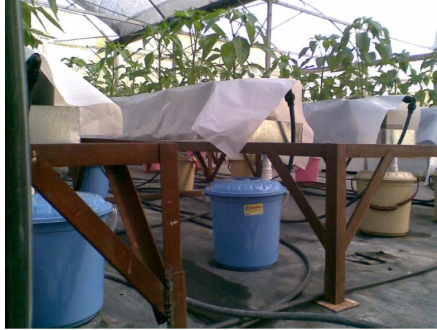
Şekil 3.11. Drenaj çözeltisinin iletildiği PE borular ve drenaj tankları.
