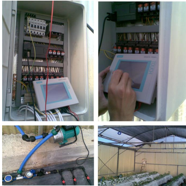
Şekil 3.2. Sulama sistemi otomasyon birimi ve sisleme başlığının genel görünümü.
