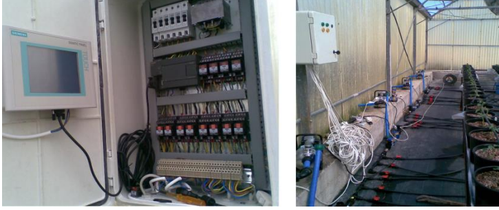
Şekil 3.7. Sulama sistemi otomasyon birimi ve sistemi oluşturan elektromotopomp, sayaç, filtre ve vanalar.
