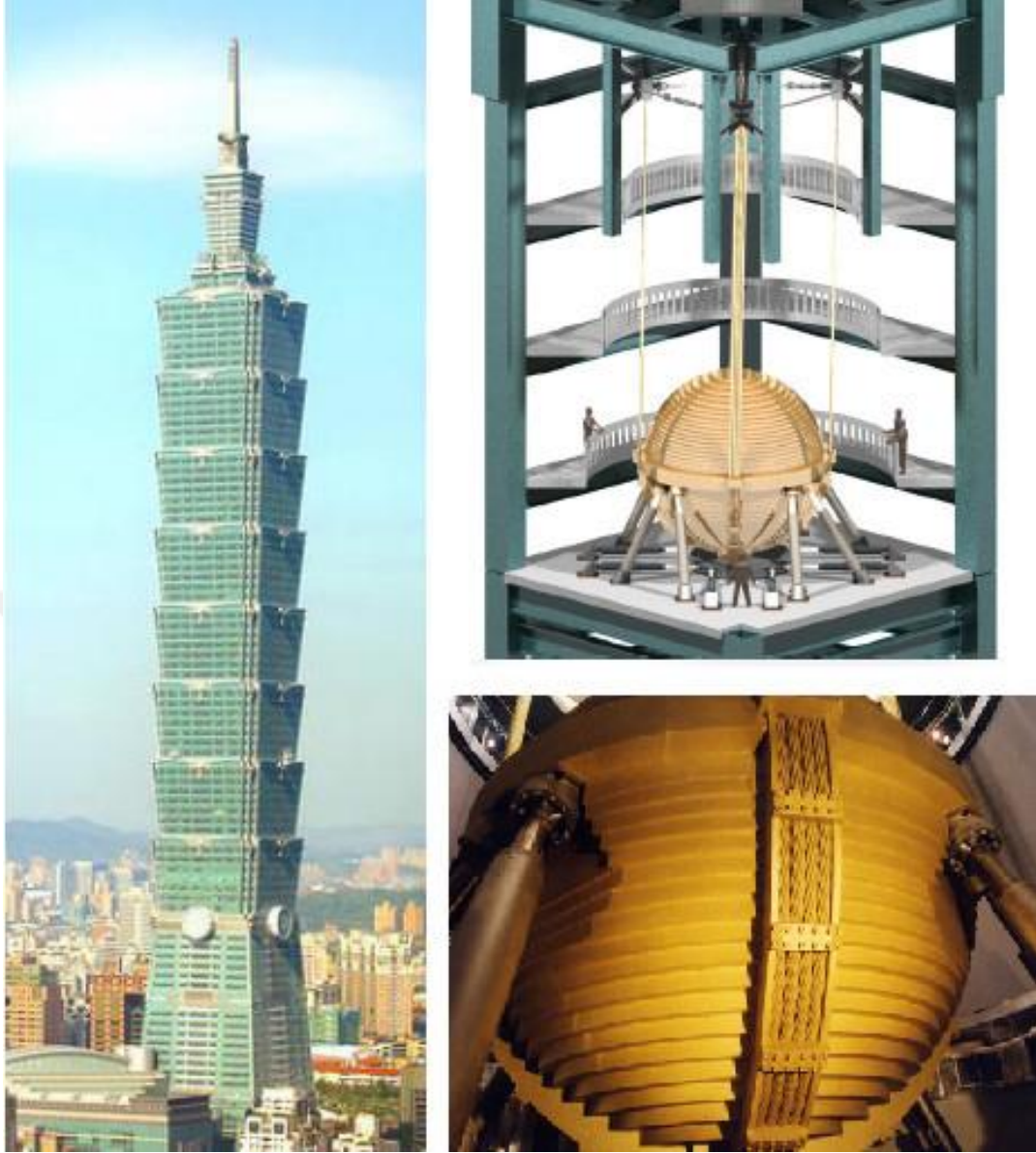
Şekil 1.1: Taipei Tower da kullanılan dinamik titreşim sönümleyici sistemi
