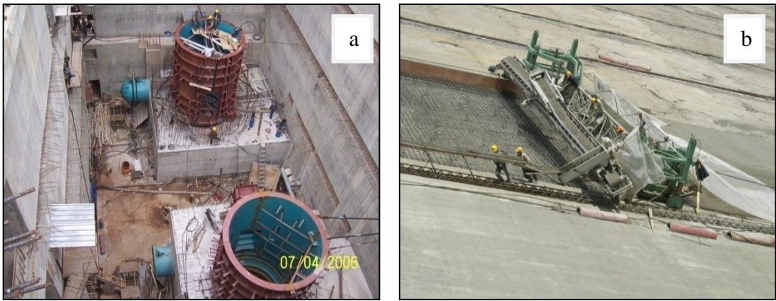
Şekil 2.25. Torul Barajı inşaat aşaması (a), Torul Barajı inşaat aşaması (b)
