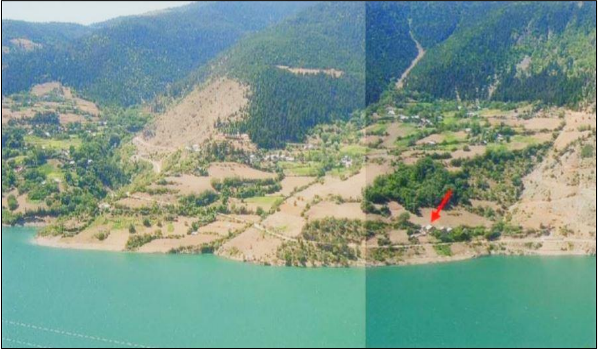
Şekil 2.11. Torul Barajı sol sahilinin su tuttuktan sonraki hali (Özdoğan, 2010)
