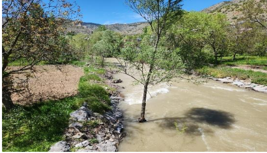
Şekil 12. Mescitli Dere Boyu Oluşan Alüvyonlar (Yer Mescitli Köyü Köprüsü)
