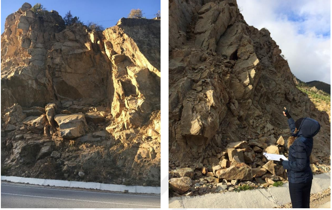
Şekil 2.14. Şevden kopup düşen blok görüntüleri
